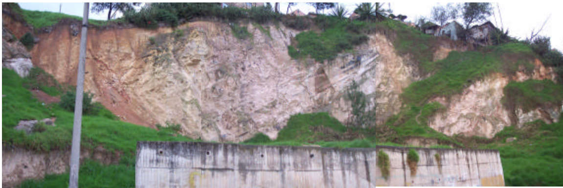
Ladera sometida a extracción de materiales de construcción.
