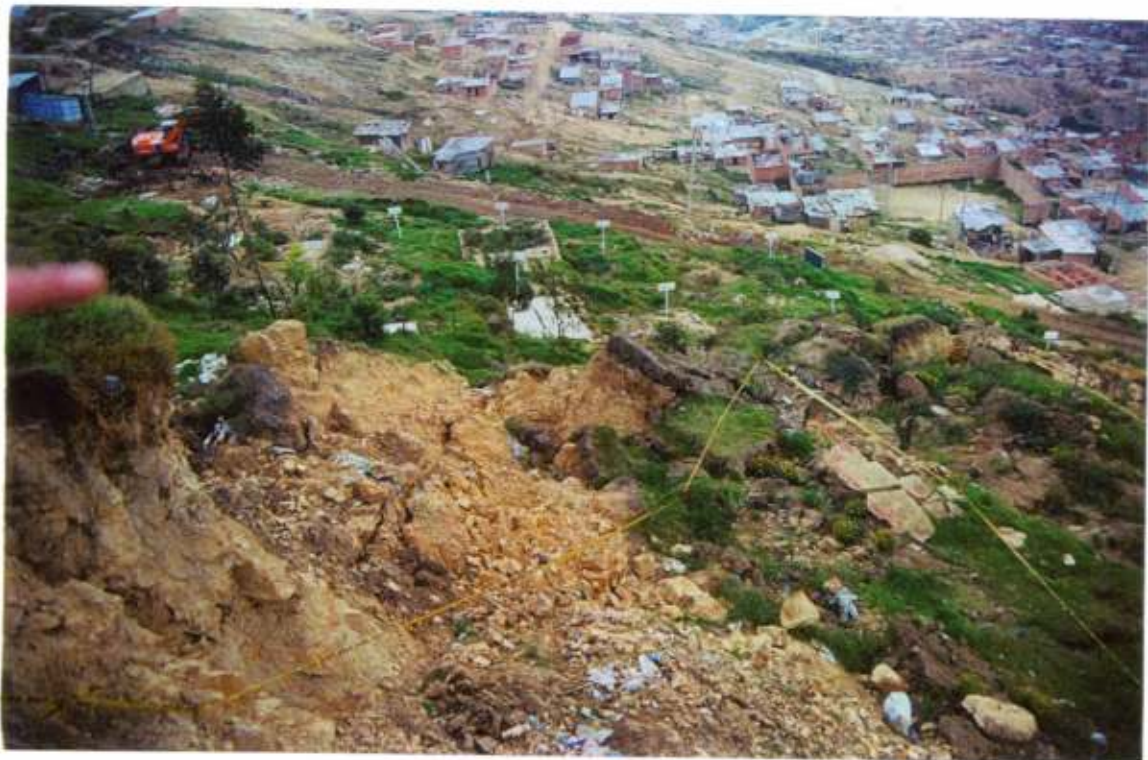
2. Flanco izquierdo del deslizamiento, las cintas muestran el replanteo del terraceo (mayo/2000).
