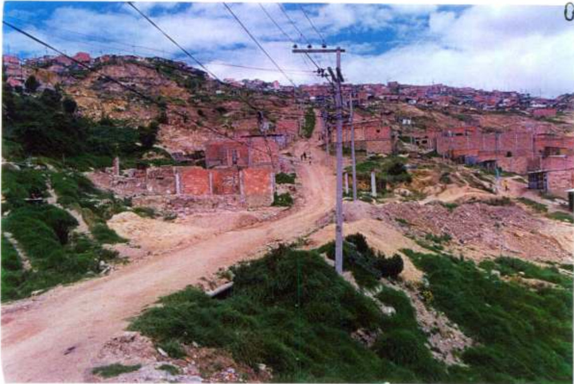
1. Vista general del deslizamiento en mayo/2000. En primer plano el hundimiento incipiente de la banca de la vía.
