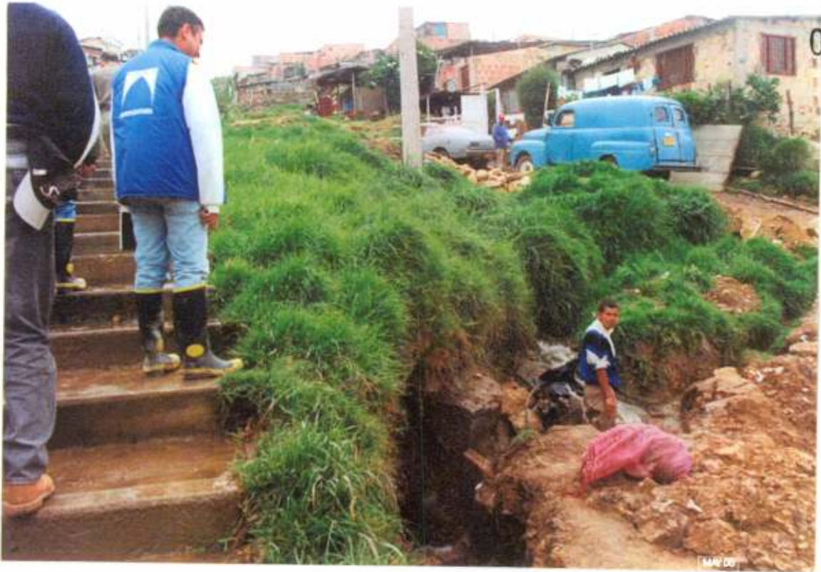
11. Sitio donde se entuba la quebrada La Carbonera, arriba del deslizamiento.
