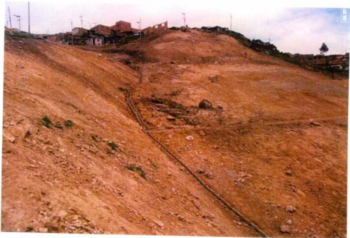
6. Parte media superior del deslizamiento, después del terraceo.
