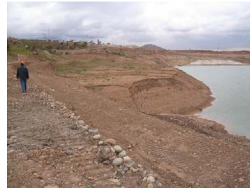
Figura 6.7 Fotografías del talud Codeipa en su parte baja – Fenómenos de inestabilidad local
