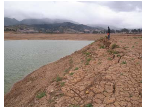
Figura 6.8 Fotografías del talud Codeipa en su parte baja – Fenómenos de desecación y cambios volumétricos
