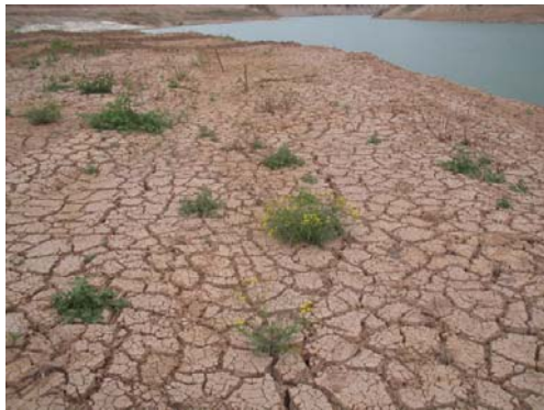
Figura 6.8 Fotografías del talud Codeipa en su parte baja – Fenómenos de desecación y cambios volumétricos
