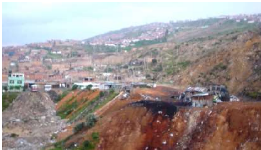
Foto 4-26 Detalle del botadero de escombros de aserrín (rojo) y enchapados de construcciones (gris azulado)
