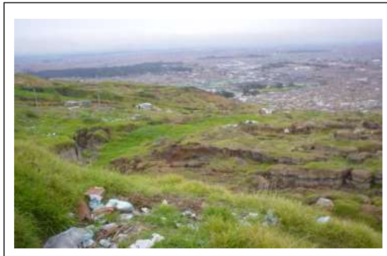
Foto 4-8 Vista de la zona de deslizamiento translacional de suelos residuales “pendiente abajo” del escarpe principal
