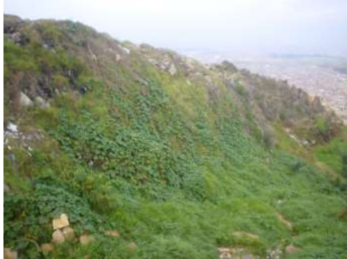
Foto 4-15 Vista lateral del flanco izquierdo del deslizamiento formado una morfología escarpada
