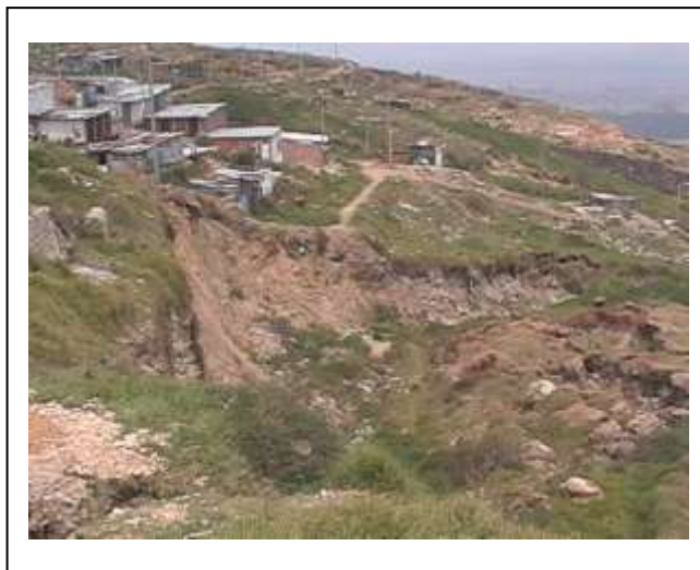
Foto 4-5 Vista en la imagen de satélite (izquierda) y el escarpe principal (derecha) del deslizamiento El Espino
