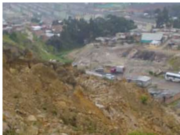
Foto 4-11 Vista de la pata del deslizamiento El espino
