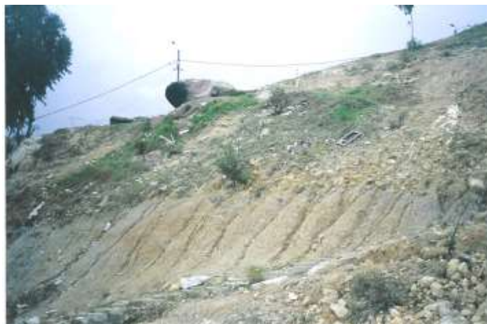
Foto 4-21 Zona de terraceo en la parte alta del deslizamiento de La Carbonera.
