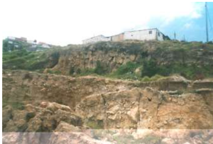
Foto 4-18 Vista de escarpes escalonados mostrando un avance retrogresivo del movimiento.
