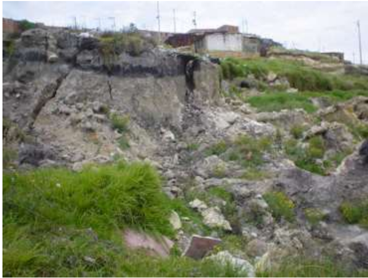
Foto 4-17 Vista de terreno de la cabeza del deslizamiento La Carbonera en el sector de la corona y escarpe principal
