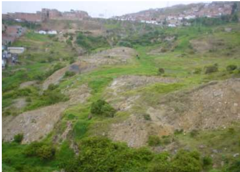
Foto 4-23 Vista de terreno del pie del deslizamiento La Carbonera
