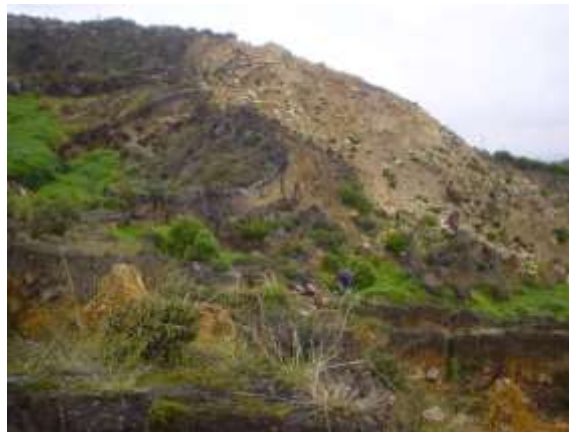
Foto 4-14 Vista del deslizamiento de rocas en la zona del montículo de presión. Nótese el cabalgamiento de los suelos residuales sobre la roca fracturada y desplazada
