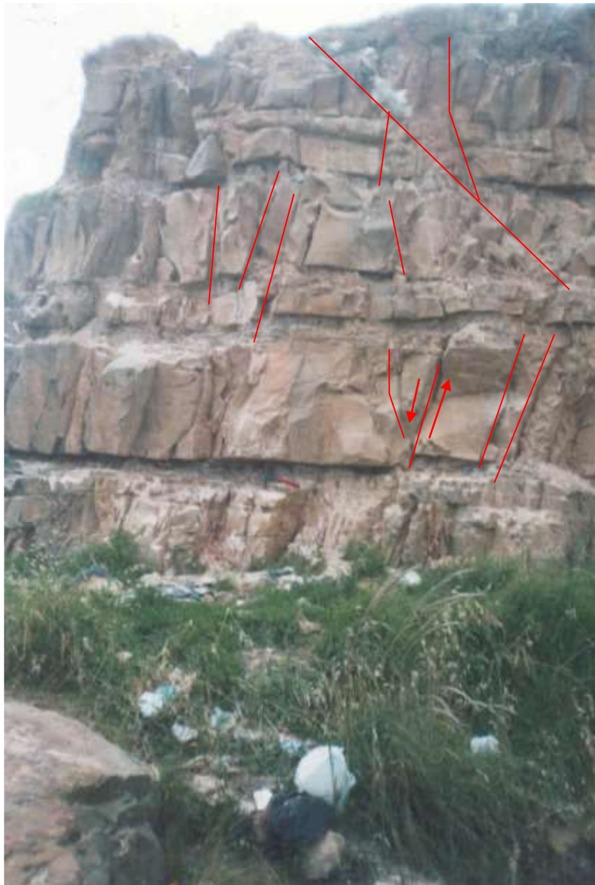
Foto 3-14 Parte alta de la Quebrada Santo Domingo. En donde se aprecia marcado fracturamiento de tipo distensivo. Con pequeñas fallas normales por gravedad y cuñas por diaclasamiento. Líneas rojas marcan los sistemas de diaclasas
