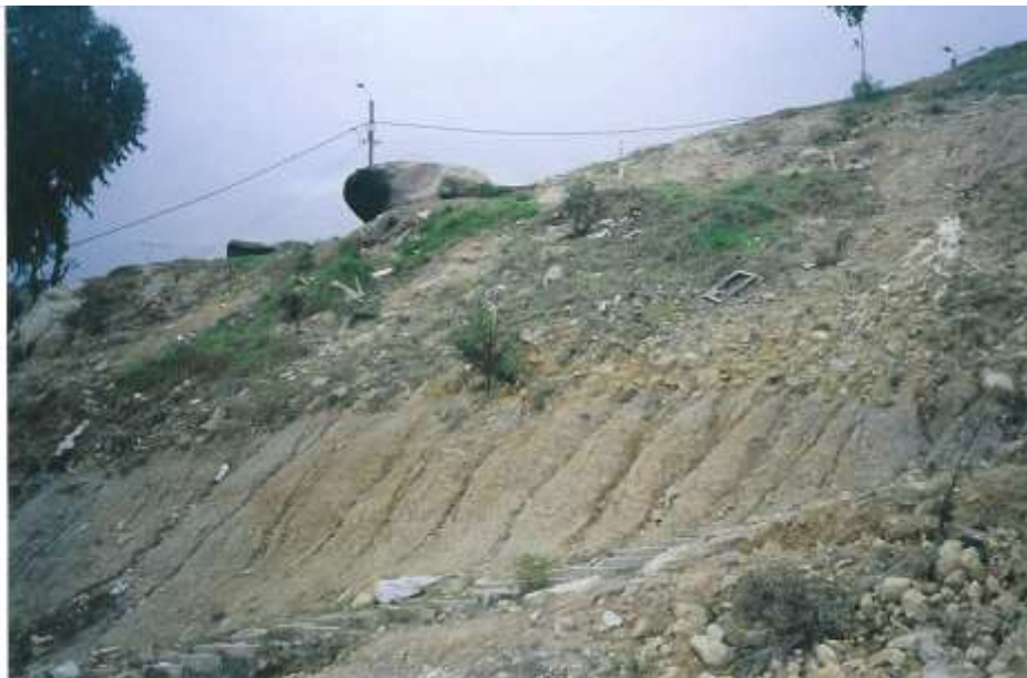
Foto 3-19 Detalle de arcillolitas grises y rojizas en la parte alta del deslizamiento la Carbonera. Nótese el cambio del drenaje superficial a partir del contacto superior con depósitos de relleno y suelos residuales.
