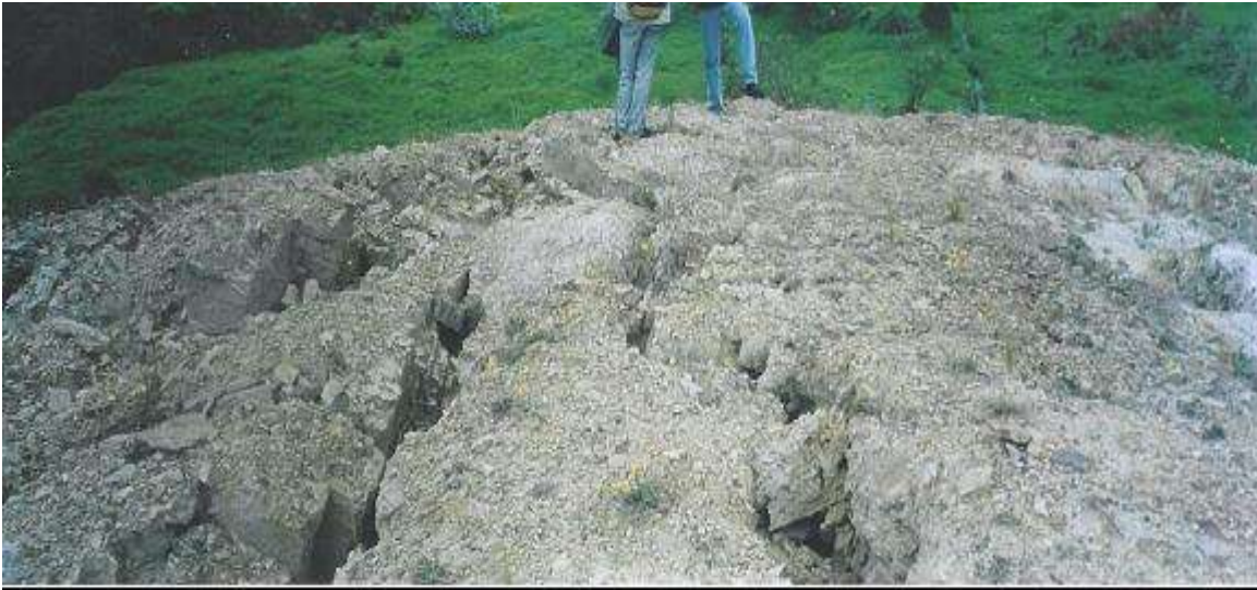
Foto 3-21 Detalle de areniscas muy agrietadas y fracturadas formando un montículo de presión.
