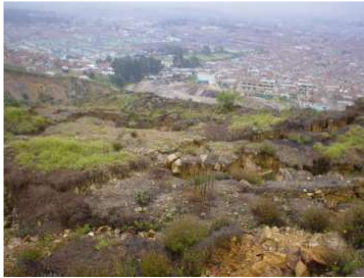
Foto 3-24 Detalle del material deslizado compuesto por suelos residuales y bloques de arenisca
