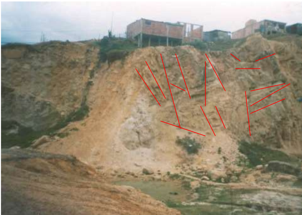
Foto 3-13 Areniscas de la formación Guadalupe Arenisca Tierna fracturadas mostrándose varios sistemas de diaclasas. Cantera Luis Carlos Galán
