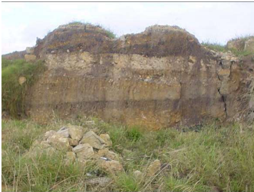
Foto 3-16 Depósitos de materiales de rellenos antrópicos de antiguas canteras. En la parte superior (A) residuos orgánicos y escombros, en B y C material de relleno, en D suelo orgánico.
