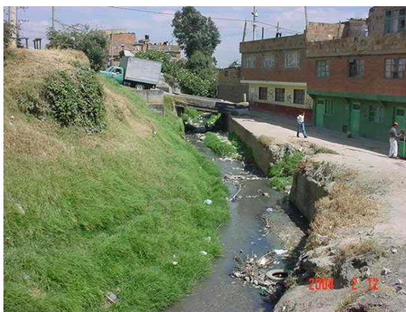
Sitio No. 1 rodeado de vías y viviendas. Nótese también la depositación de residuos en el cuerpo hídrico
