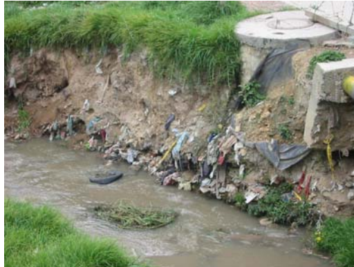
Parte alta del sitio No. 2. Nótese el relleno con materiales de desecho y el depósito de residuos sobre el cauce de la quebrada de Limas.
