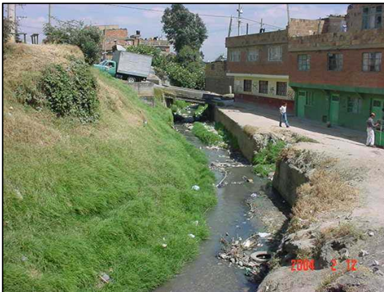
Foto 6 – Inflexión de la quebrada y protecciones sobre la curva externa (margen derecha)
