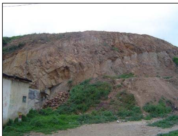
Foto 1. – Intercalaciones de areniscas y arcillolitas y derrubios y escombros de antigua explotación de material.
