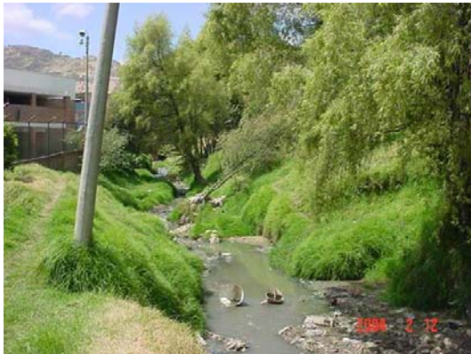
Foto 4 – Pequeños deslizamientos en la margen izquierda de la quebrada (derecha de la foto)
