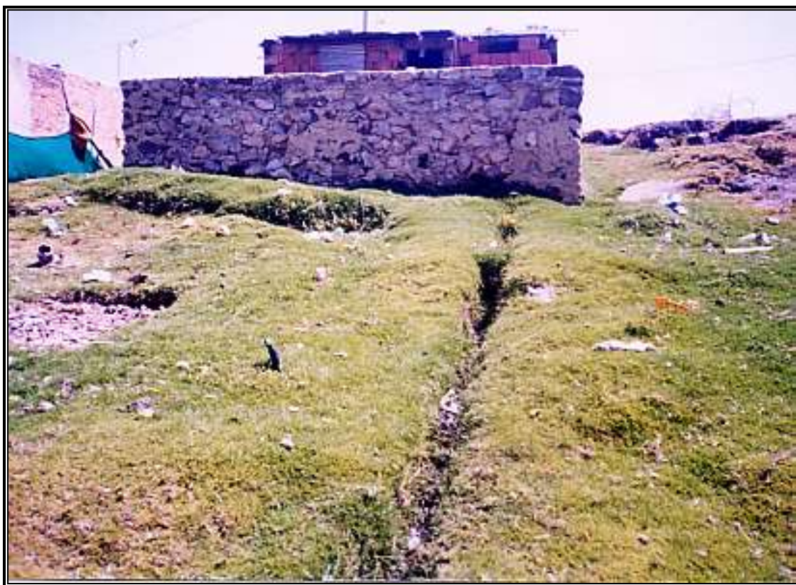
Fotografía 6. 3. Vertimientos libres de aguas negras por medio de zanjas en las viviendas localizadas en las laderas que drenan hacia la quebrada de Limas.
