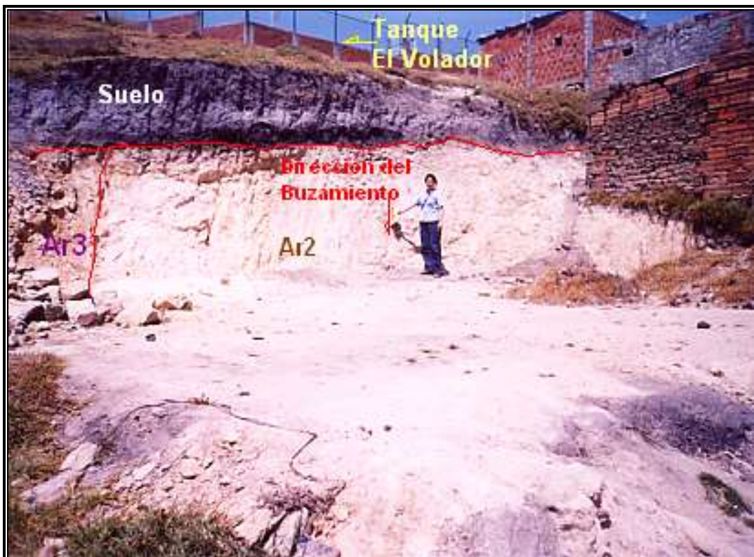
Fotografía 3. 5 Corte en la vía principal del Barrio Brisas del Volador, entre las Calles 74 y 75 Sur. Se observa el replegamiento de las Areniscas Laminadas Ar3, en la parte baja del Tanque de Quiba
