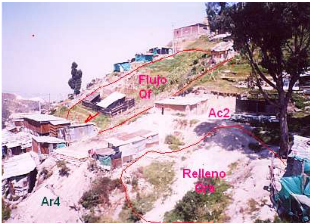
Fotografía 3. 19 Manzana 11. Brisas del Volador. Relleno de vertimiento libre sobre la margen del drenaje principal
