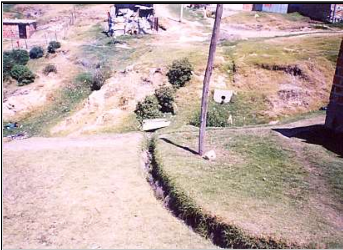
Fotografía 6. 4. Entrega del alcantarillado comunal a los drenajes de la zona en estudio.
