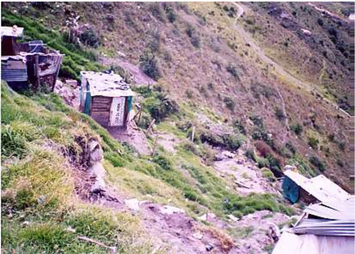
Fotografía 3. 22 Manzana 54: Viviendas ubicadas en la ladera de contrapendiente
