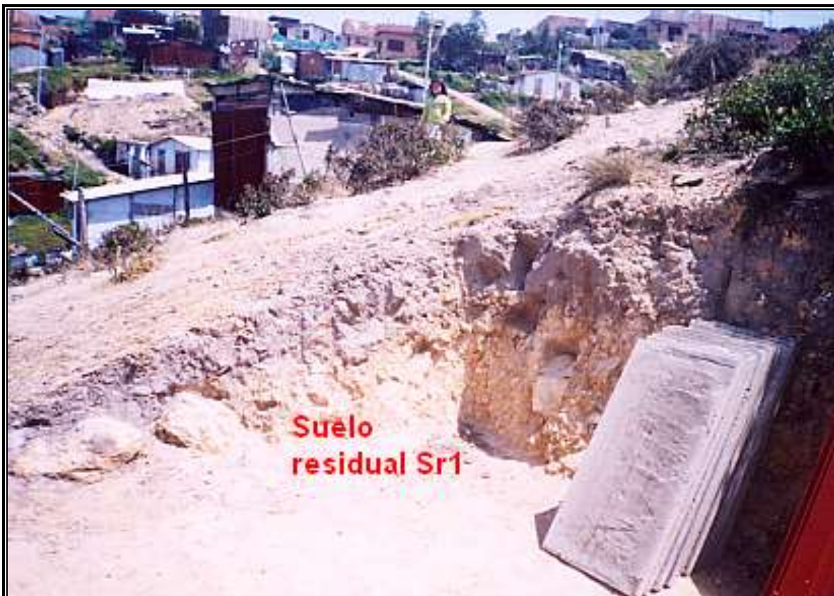
Fotografía 3. 13 Corte para construcción de una vivienda en la Manzana 16. Se observa un suelo residual conformado por bloque dentro de matriz arenosa y limosa
