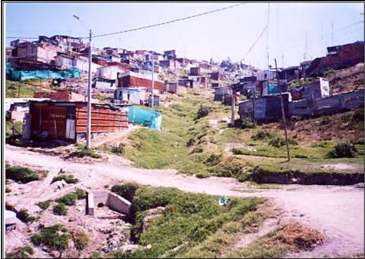
Fotografía 6. 2. Descargas del alcantarillado pluvial al drenaje principal.
