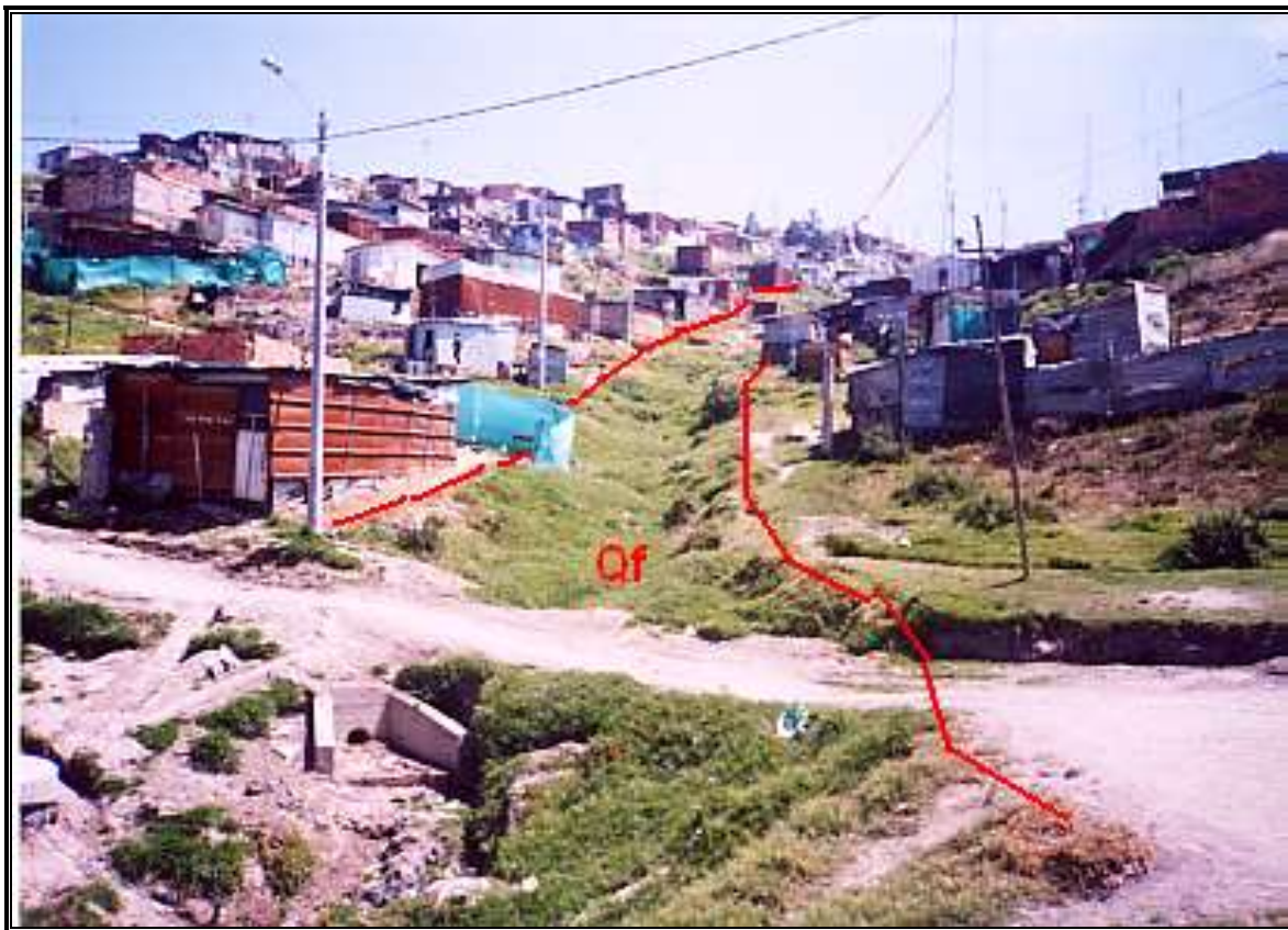
Fotografía 3. 18 Drenaje Principal. Flujos de material saturado a lo largo del drenaje
