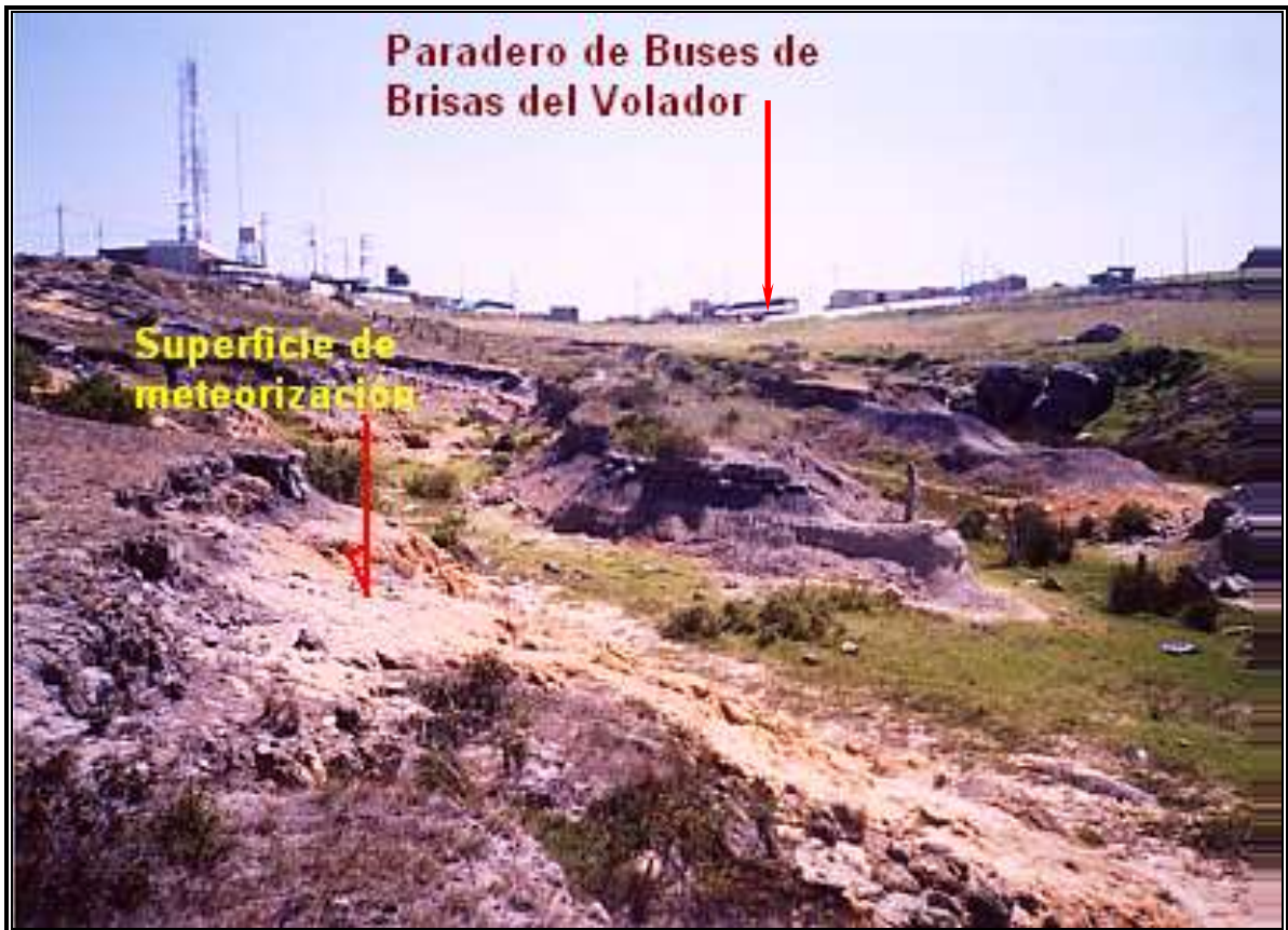
Fotografía 3. 4 Zanjón Quebrada Sur. Se aprecia el horizonte de meteorización de la unidad de areniscas Ar1 y la unidad de bloques sobre ésta.
