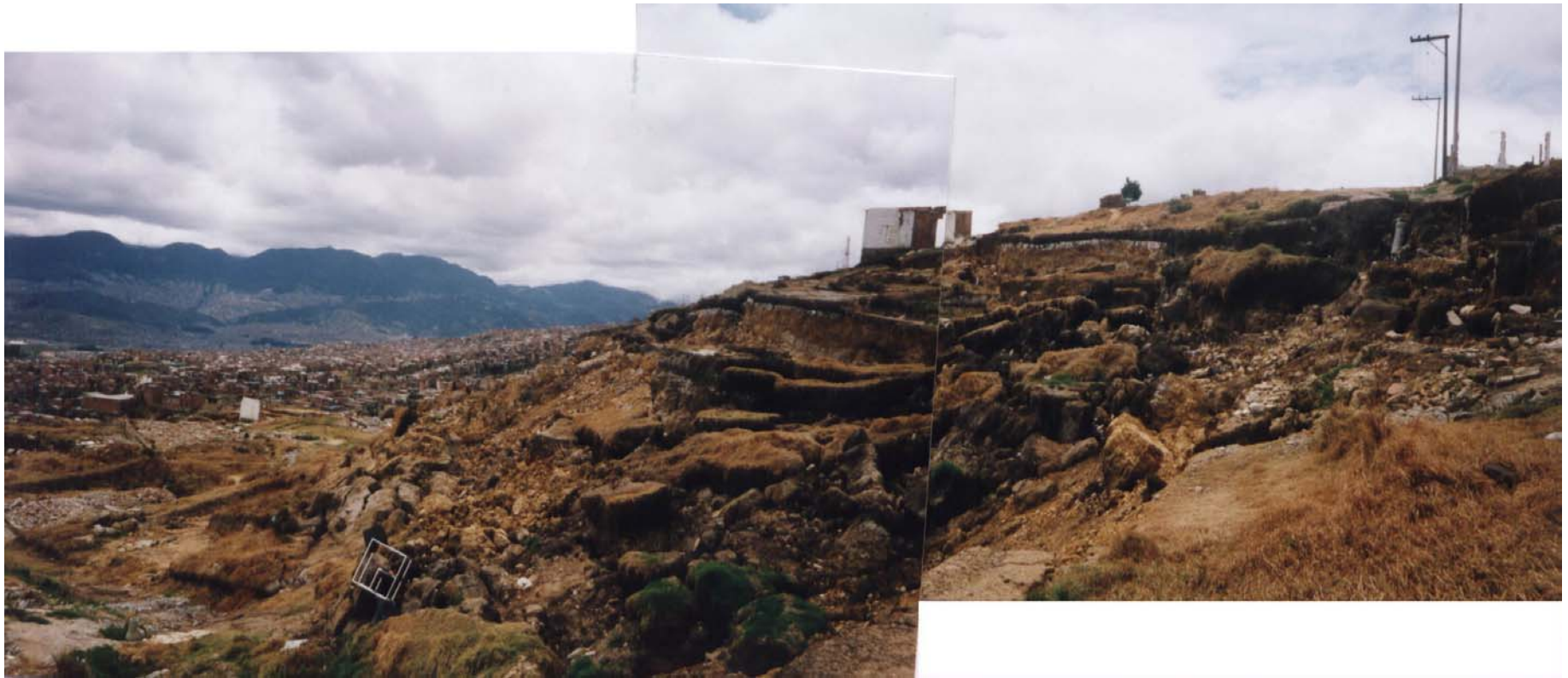
Vista panorámica del material removido en escalones, evidencia del comportamiento retrogresivo del movimiento. Nótese el delgado material de superficie y bajo este el material residual intensamente fracturado.
