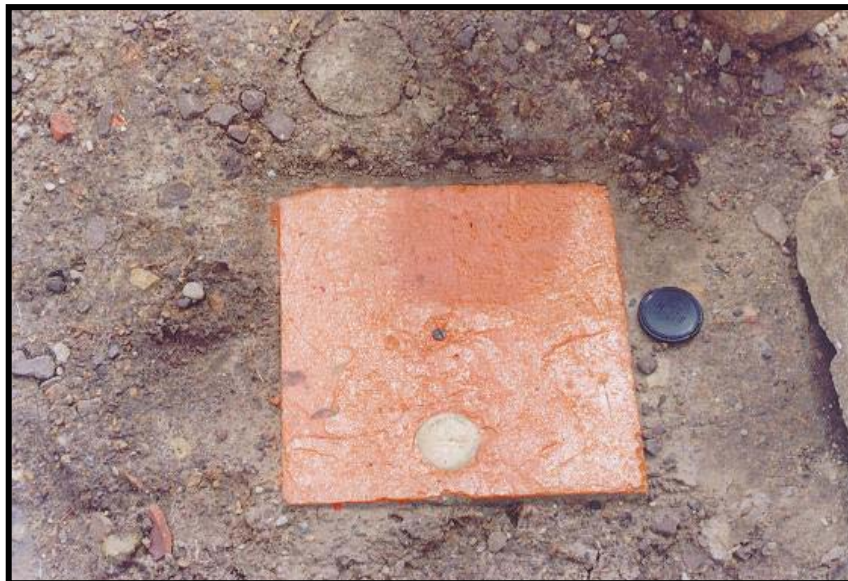
Foto 7.2 Mojón terminado, obsérvese la plaqueta de referencia y el punto central en negro. (May/02)
