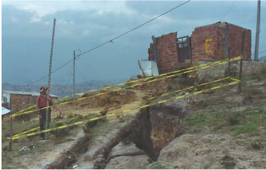
Foto 3.2 Desplazamiento vertical y horizontal sobre escarpe principal
