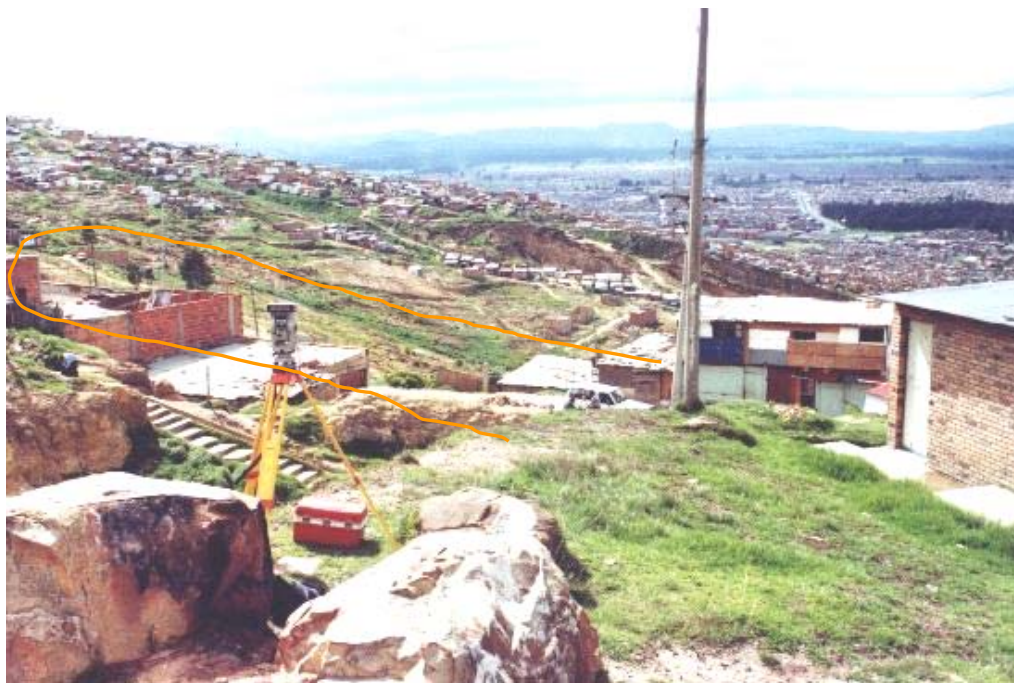
Foto 8.1. Depresión del terreno delimitando parte del deslizamiento de la Carbonera.
