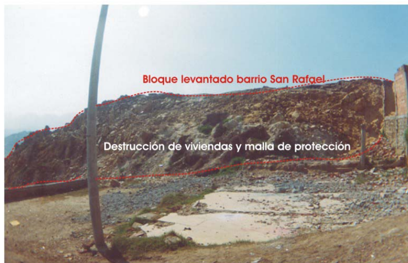
Foto 7.20 Estación San Rafael. Febrero de 2003
