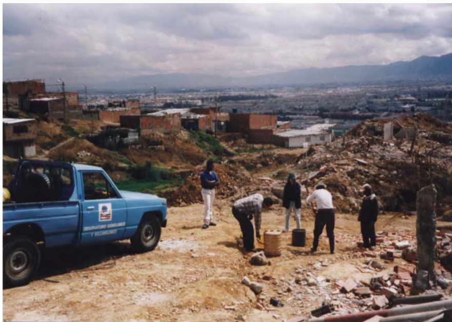
Punto 8 – KR 89 con CL 59 A. Vista por la margen derecha de la Quebrada Santa Rita. Nótese el material removido y las grietas sobre la superficie.
