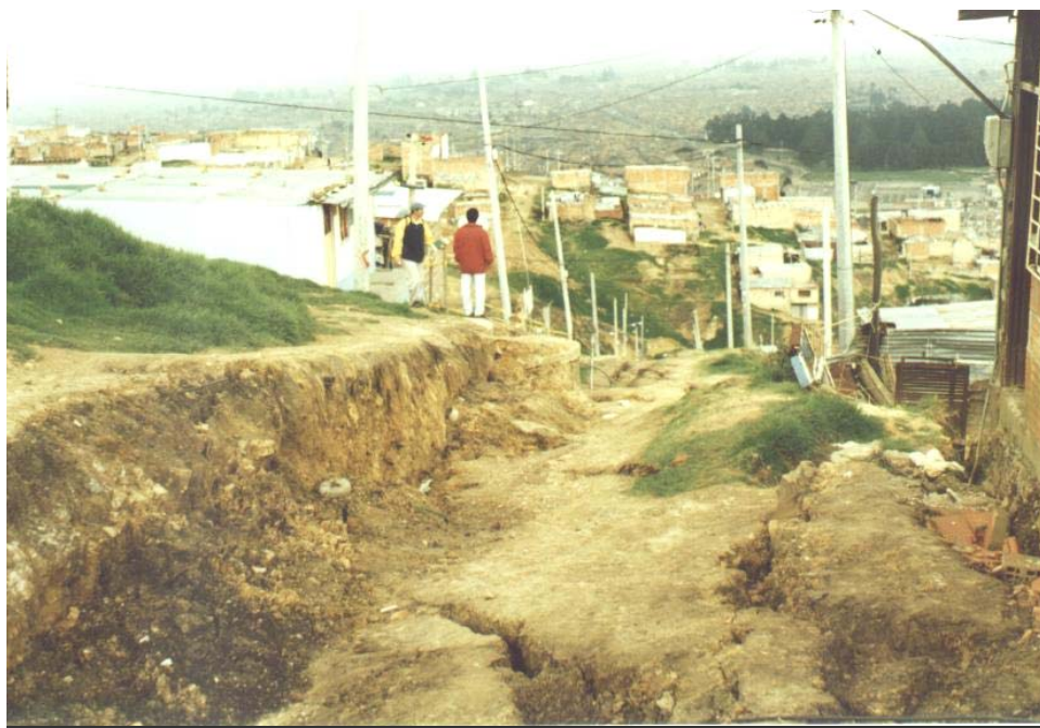
Foto 4.7. Vía destruida y postes de alumbrado público inclinados debido a los agrietamientos de Carrera 89, barrio Cerros del Diamante, (May/02).
