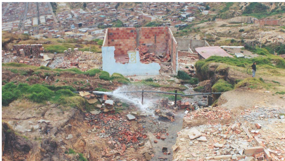
Foto 8.5 Desacople de mangueras fue otro fuente importante de inestabilidad (agosto 2002)
