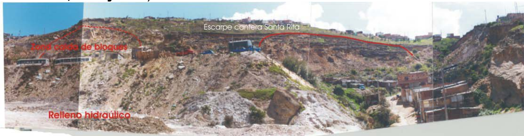
Foto 7.4 Estación Paradero Abril de 2002. Vista a la cantera Santa Rita desde el sector El Rodeo
