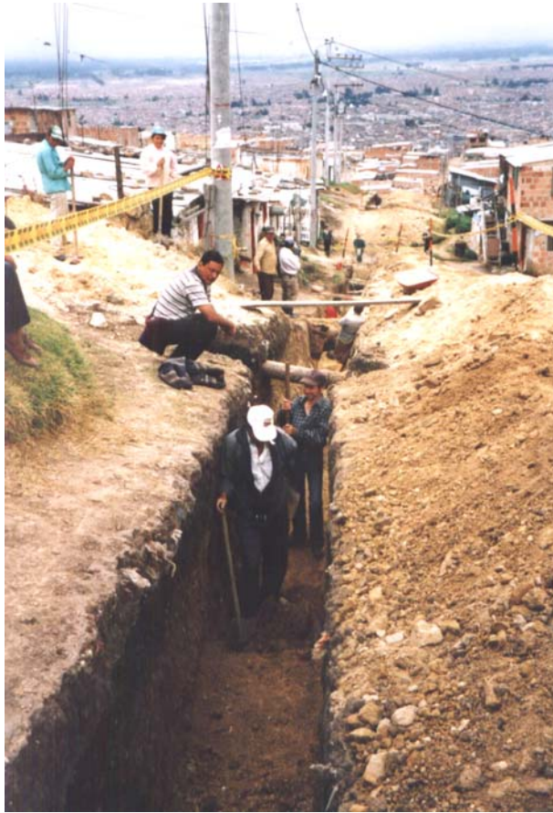
Puntos 3 y 9 - Vista desde el punto 3 hacia el punto 9. Nótese el material excavado que corresponde al material residual superficial predominante en el área
