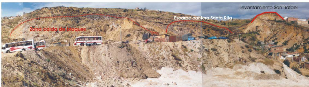
Foto 7.6 Estación Paradero Octubre de 2002. Vista a la cantera Santa Rita desde el sector El Rodeo
