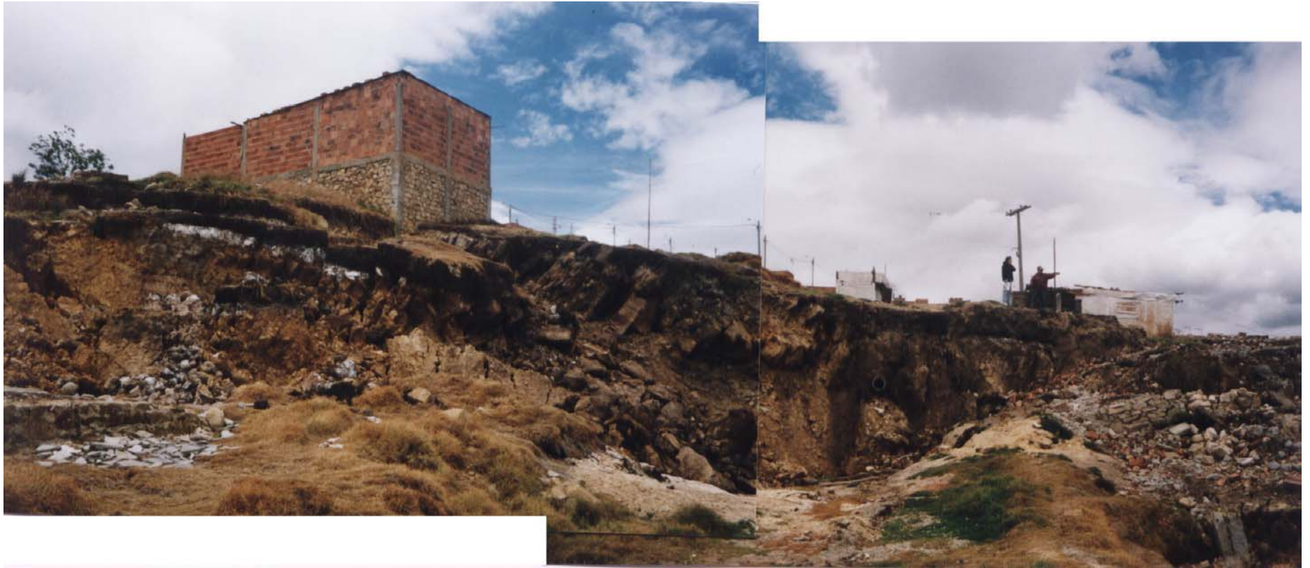
Vista panorámica del material removido el Barrio El Diamante. Nótese el espesor de la cobertura del suelo, el paquete de material residual y la roca alterada y fracturada intercalada con delgados paquetes de arcillas.
