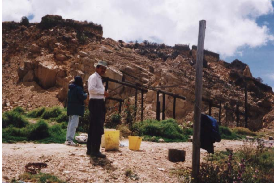
Punto 11 – KR 88 con CL 56 A. Una de las zonas donde se inició el movimiento. Nótese la roca al fondo y el material removido sobre el cual se realiza el ensayo.
