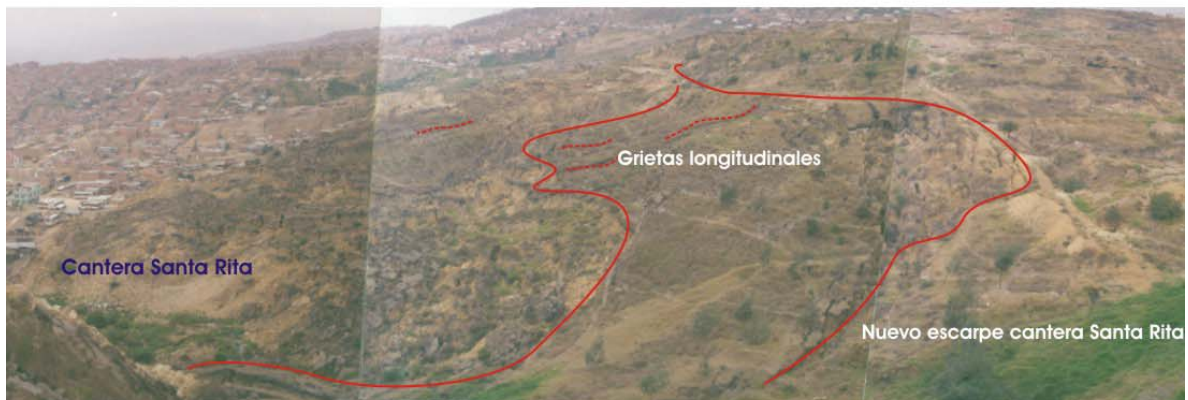
Foto 7.14 Estación Santa Rita Marzo de 2002. Vista a la cantera Santa Rita desde Mirador de La Estancia
