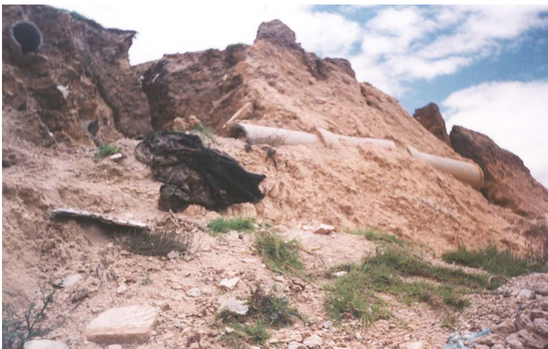
Foto 8.8 Ubicación de tubería del alcantarillado paralelo a la greita principal
