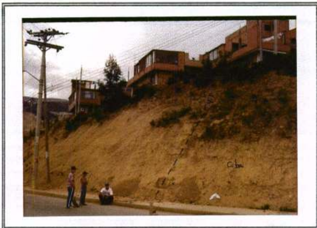
FOTO 7 Talud Nº 4 Afloramiento de Areniscas altamente fracturadas hacia la parte superior de la secuencia y arcillolitas en la base intercaladas con delgadas capas de areniscas.
