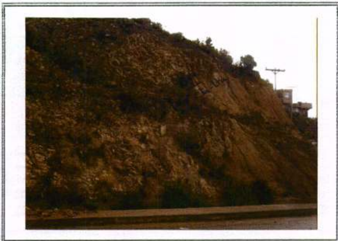
FOTO 2 Talud Nº1. Afloramiento de Areniscas altamente fracturadas en la parte superior de la secuencia. Hacia la base arcillolitas finamente laminadas.
