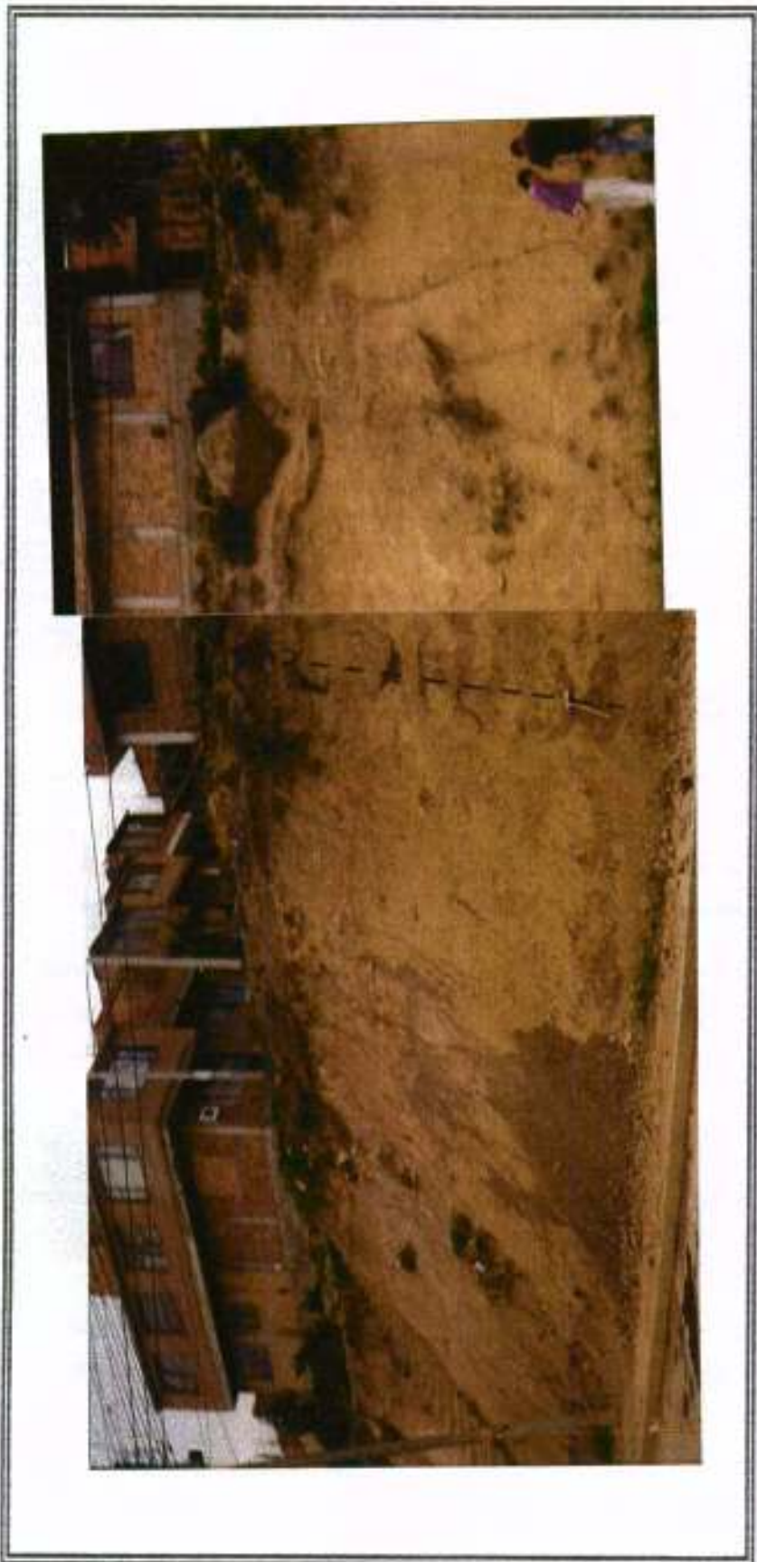
FOTO 9 Talud N°.4 Afloramiento de arcillolitas con delgadas capas de areniscas intercaladas. El plegamiento y fracturamiento alto en las areniscas ocasionan que no se observe la continuidad en los estratos.
