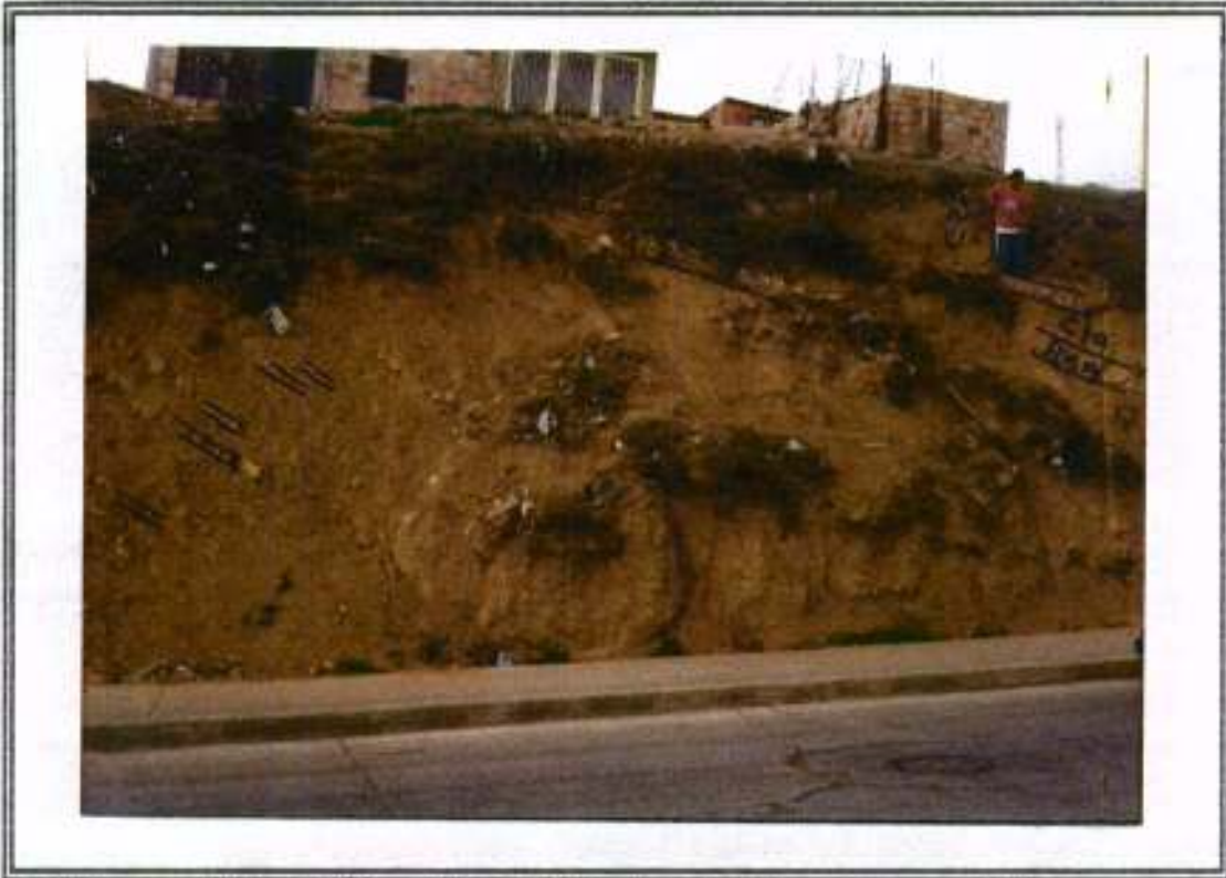
FOTO 5 Talud Nº2. Afloramiento de Areniscas y arcillolitas intercaladas. Las capas de areniscas se hacen más potentes hacia la derecha de la foto. Hay ligeros cambios en la dirección de la estratificación.
