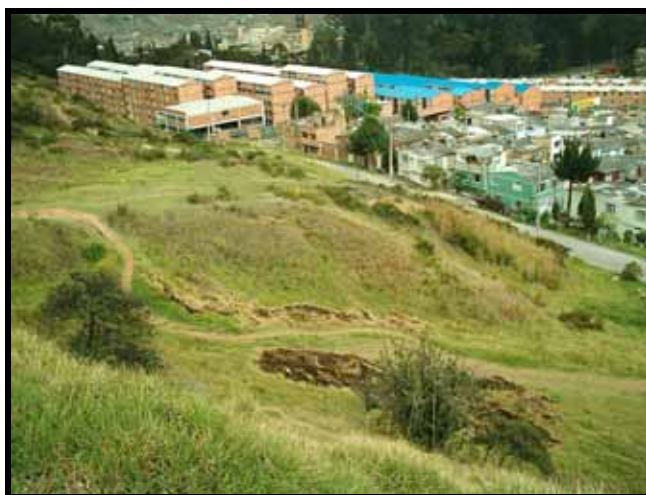
Fotografía No. 8. Ladera sur. Se evidencian los procesos morfodinámicos cartografiados como DTE-004, en primer plano y DTE-005, al fondo. la urbanización de edificios cimentada sobre areniscas de la Formación Regadera.
