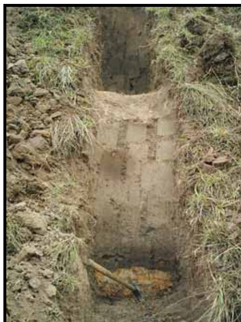
Fotografía No. 18. Trinchera No. 2, afloramiento de suelos residuales arcillo arenosos y rocas alteradas de las areniscas de la Formación Regadera sobre la carrera 10C.
