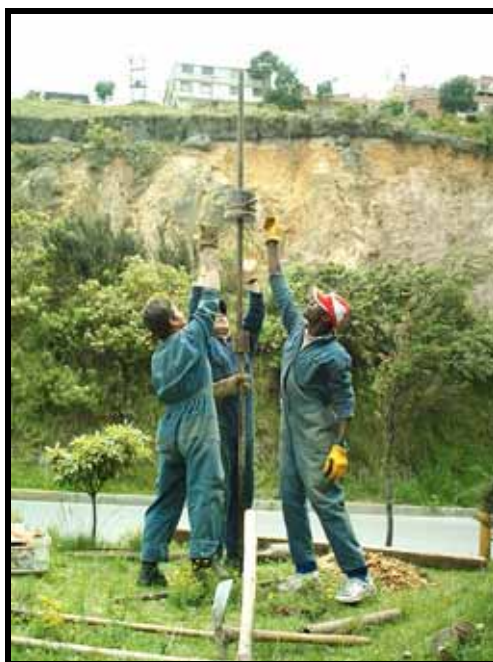
Fotografía No. 1. Perforación del sondeo manual N. 4, a una profundidad de 2.75 m, en donde se encontró un relleno de 20 cm., un suelo residual de 1.60 m. y areniscas de la Formación Regadera. Al fondo se observa el perfil de meteorización encontrado en el sondeo.
