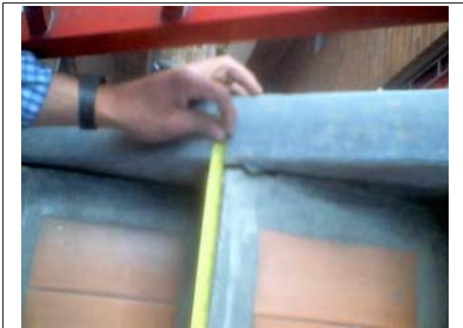
Foto 21. Detalle de la Dilatación Lateral
