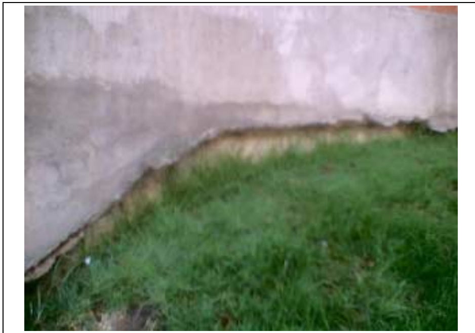
Foto 5. Asentamiento en el contacto con el bloque
