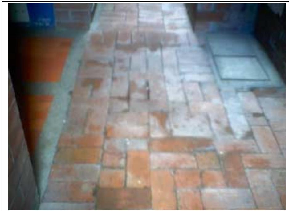
Foto 18. Adoquines a la entrada del edificio
