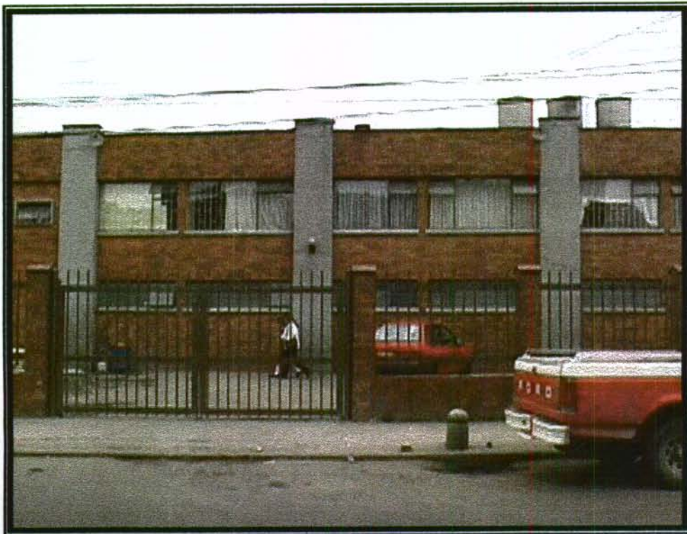
Foto 3. CERRAMIENTO DE PARQUEADERO FRONTAL
