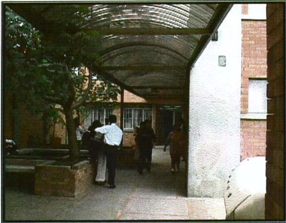
Foto 10. PERGOLA SOBRE ACCESO PRINCIPAL
