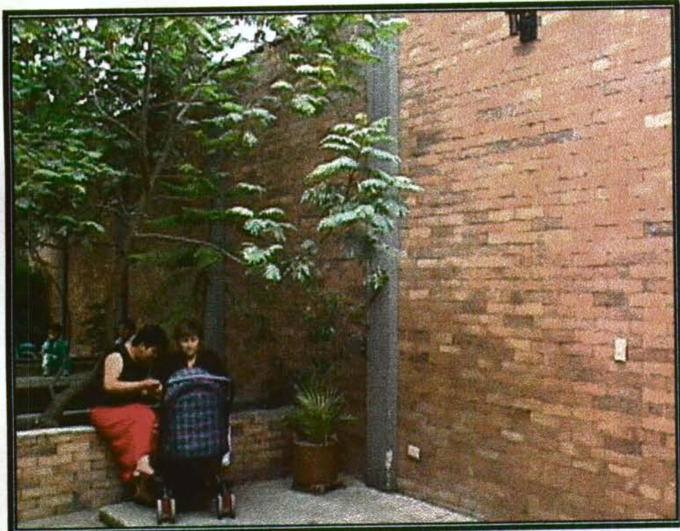
Foto 30. MURO CONFINADO LATERAL DE CERRAMIENTO
