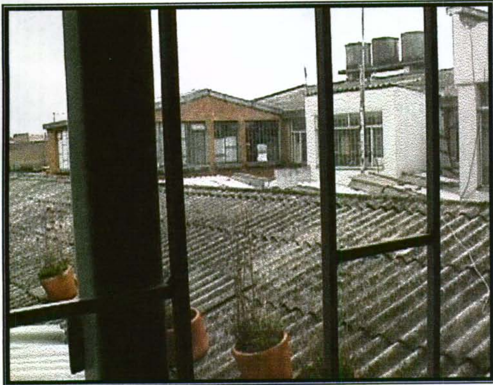
Foto 18. VISTA GENERAL DE CUBIERTAS
