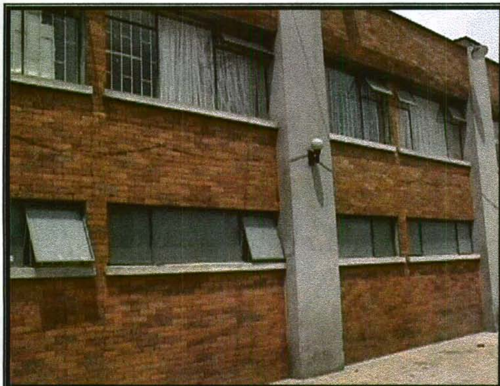
Foto 7. FACHADA PRINCIPAL ZONA DE MUROS DE CARGA
