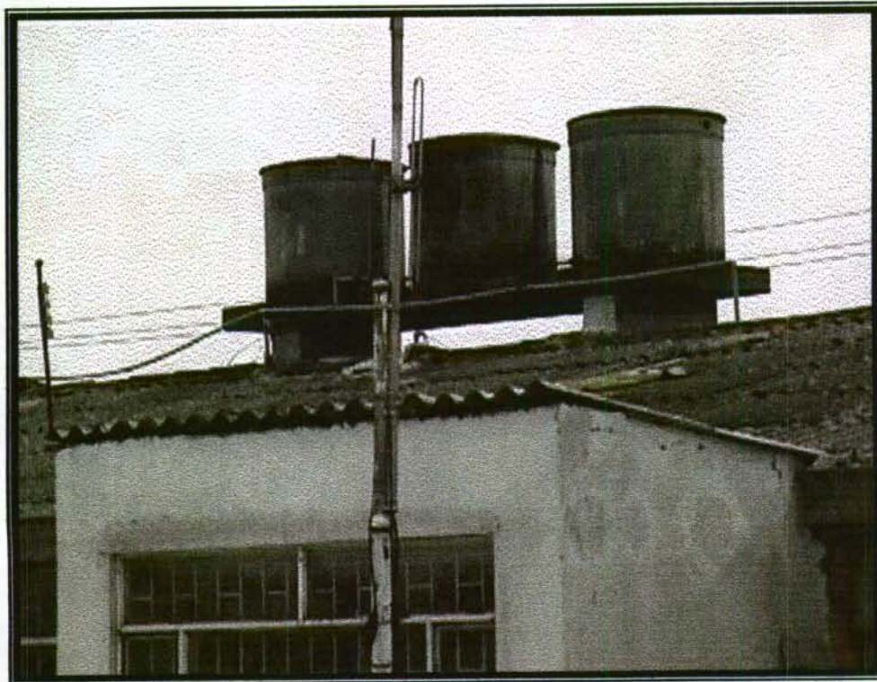
Foto 19. TANQUES ELEVADOS SOBRE ZONA DE MUROS DE CARGA
