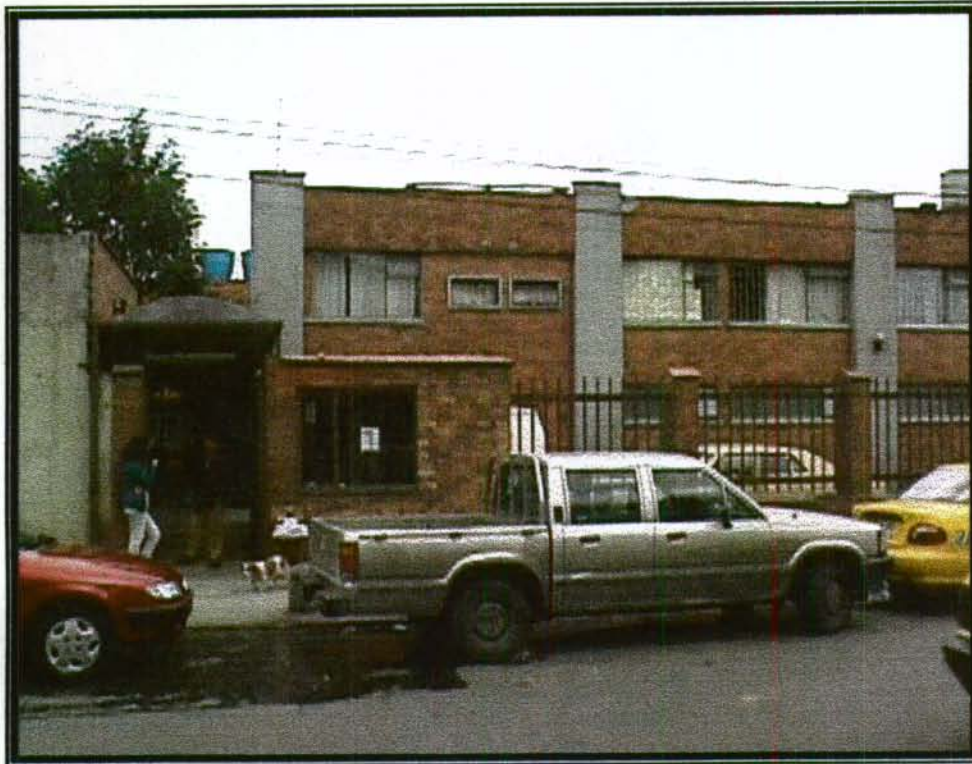
Foto 4. CERRAMIENTO PARQUEADERO Y FACHADA LATERAL
