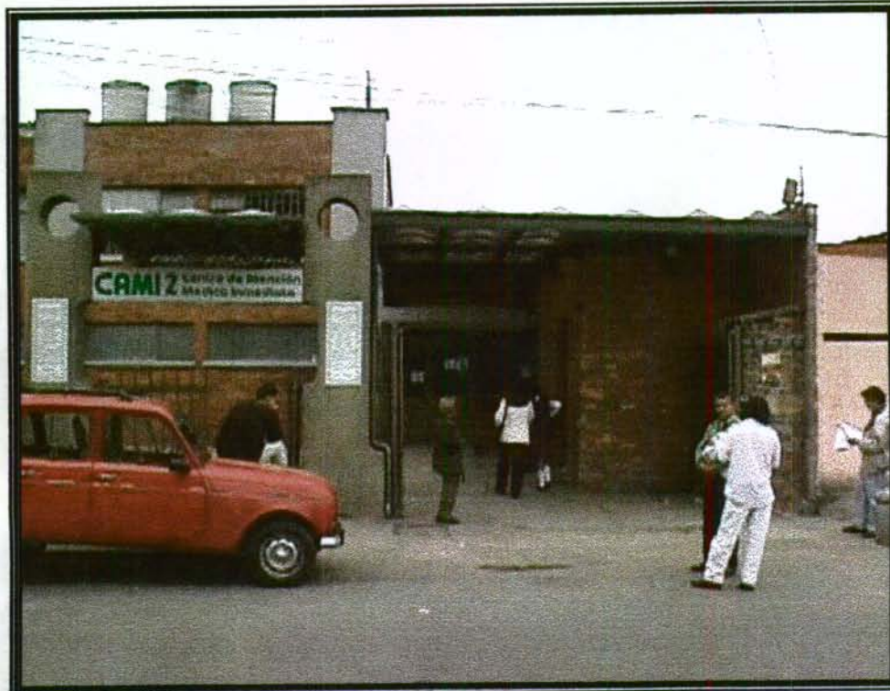
Foto 1. ACCESO ZONA DE URGENCIAS
