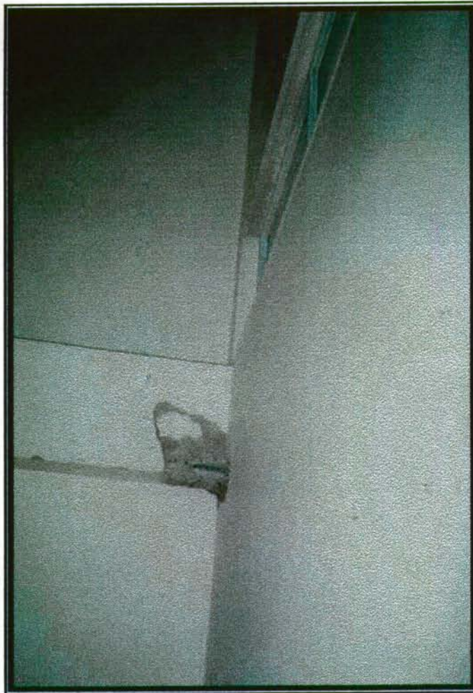
Foto 13. EXPLORACION EN VIGA – ZONA DE PORTICOS
