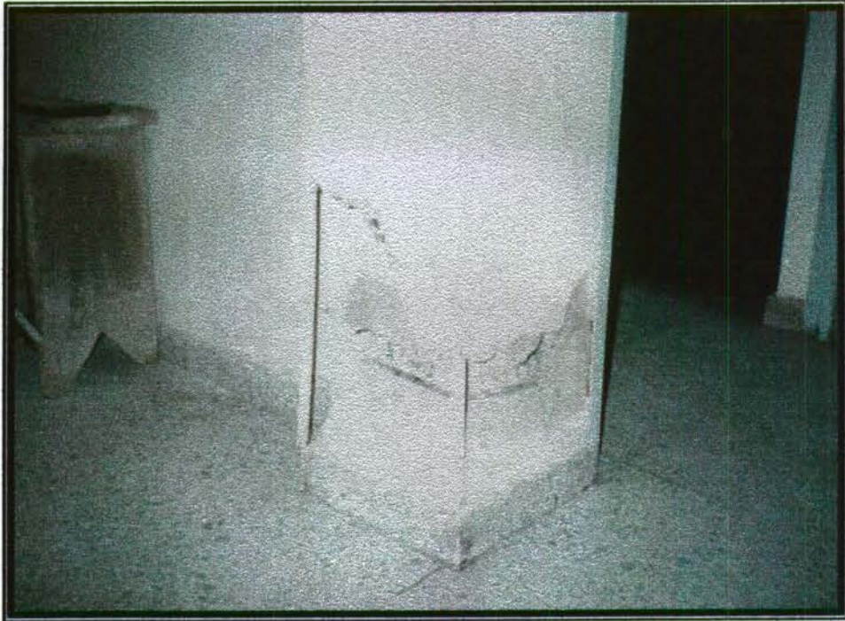
Foto 8 . EXPLORACION DE COLUMNA – ZONA PORTICOS
