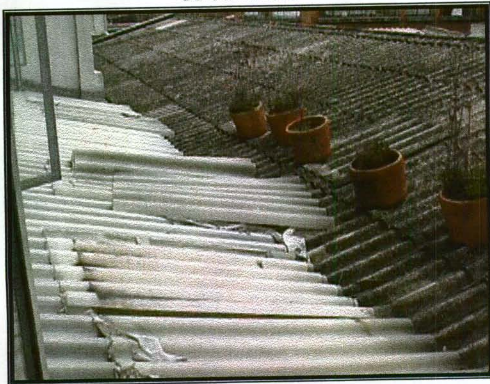
Foto 17. CUBIERTA EN ZONA POSTERIOR (CONSULTORIOS Y ESTADISTICA)
