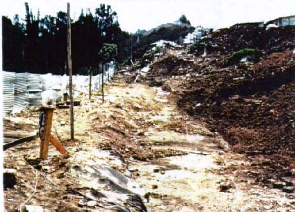
Vista de la instrumentación del talud afectado por movimiento de la ladera inferior. (instalación de piezómetros e inclinómetros como monitoreo del movimiento del talud.
