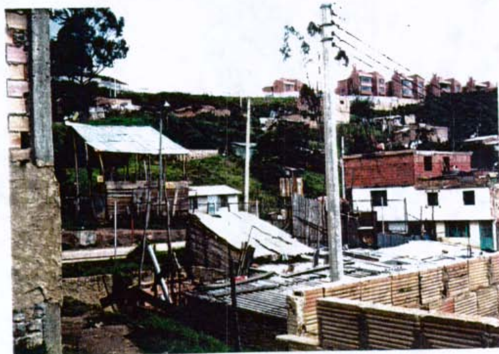
Detalle de los asentamientos urbanos localizados sobre la zona III, sector afectado por las aguas de infiltración y evidencias de reptación del terreno.
