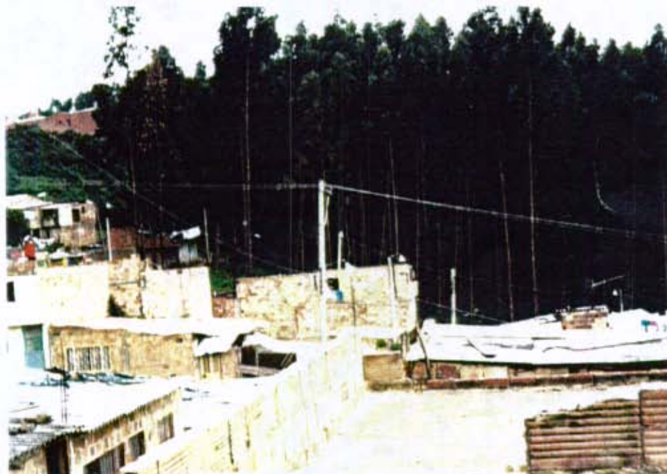
Vista de los asentamientos urbanos en el costado norte de la zona I (flujo principal estabilizado), y la arborización del costado sur.
