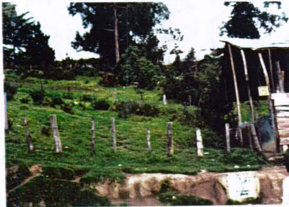
Vista de los sector de ladera (zona III), afectado por aguas de infiltración, donde se observa una alta saturación y reptación local con daños en las viviendas.
