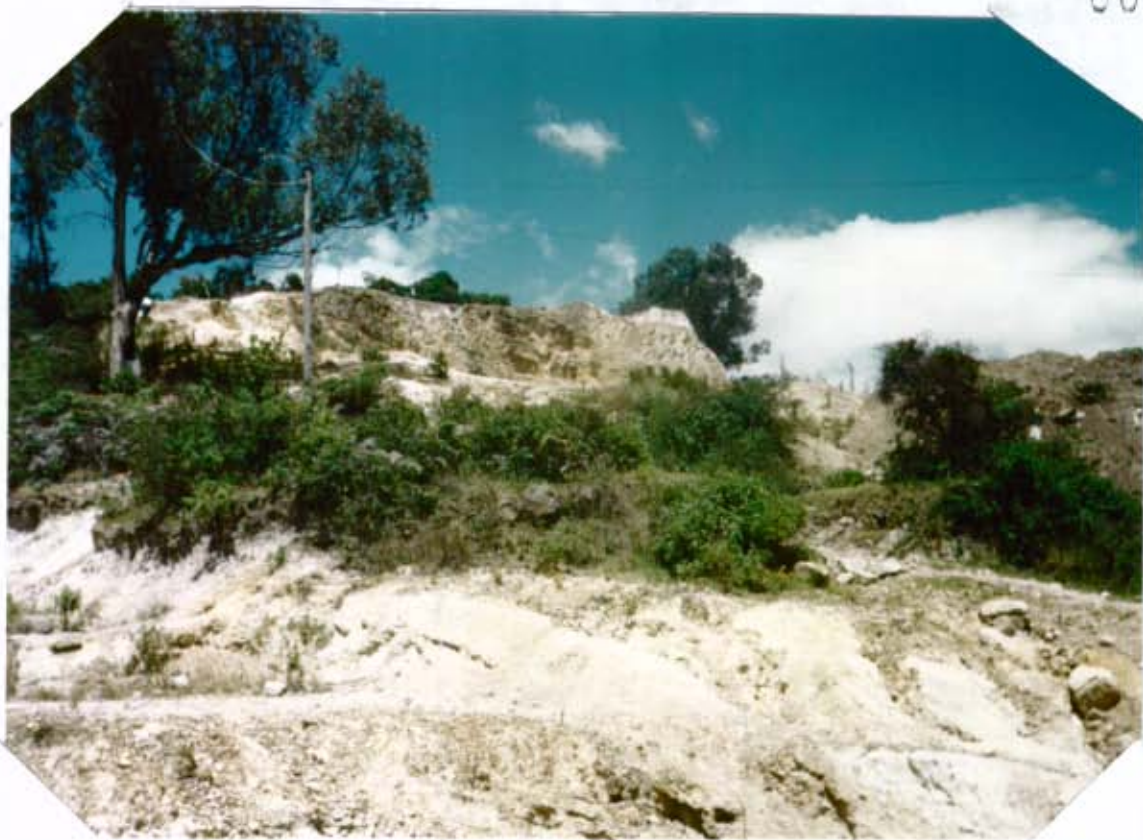
ZONA DE ALTA EROSION LA CANTERA
