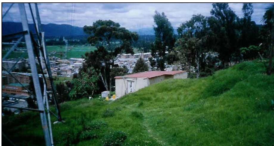
Foto 21. Detalle de la casa blanca localizada en el extremo sur-oriental de la zona 3. Allí se presenta el vertimiento de aguas residuales hacia la parte baja, contribuyendo a acentuar los problemas de deformaciones por reptación en la parte baja de la ladera..
