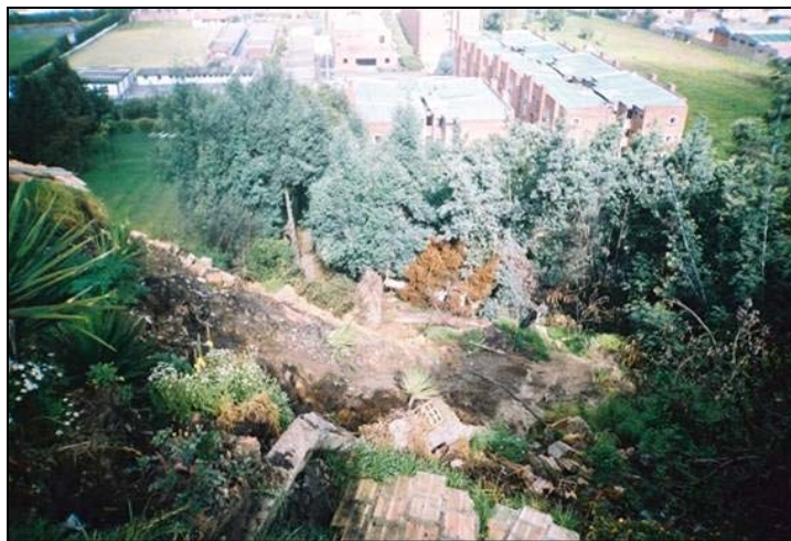
Foto 33. Esquina nor occidental de la casa de Don Octavio. Se generó el desprendimiento y la caída de un eucalipto, el cual se volcó hacia la zona del parque infantil; en donde existe una pequeña terraza natural justo debajo de la pata del deslizamiento.
