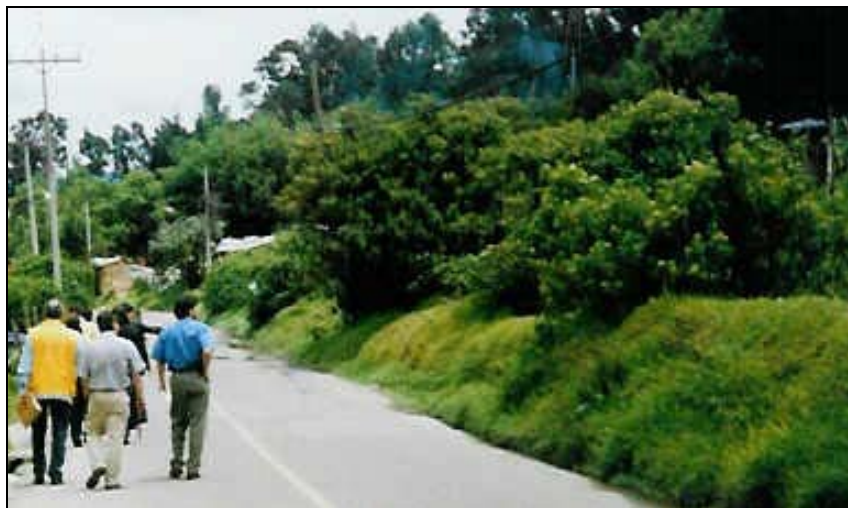
Foto 4. Vista desde el sur del límite oriental del área de estudio, por la Carrera 90. Al lado derecho de la vía nótese la presencia de deformaciones leves de la superficie por reptación del suelo, que inclusive han obstruido la cuneta de la vía.
