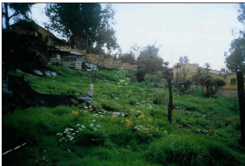
Foto 9. Vista de la parte alta de la zona 2 desde el lado norte. Se presenta un tercer escarpe que se prolonga por la parte baja de una pequeña casa de un piso. Esta grieta cierra contra la fila de eucaliptos que se encuentra a la altura del punto de toma de la foto.
