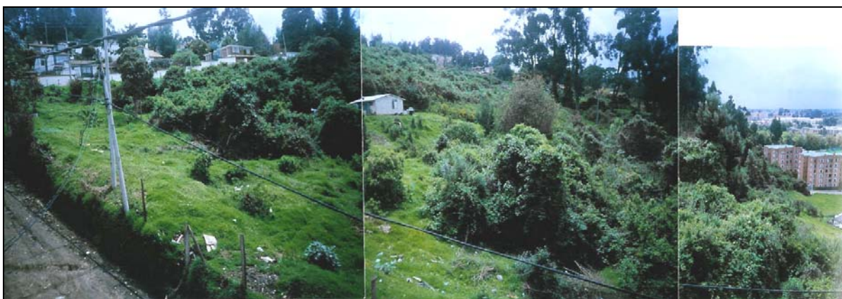
Foto 5. Vista general de la Zona geotécnica 1, en la parte alta, al costado nótense encuentra un terreno de pendiente moderada con la presencia de movimientos de masa antiguos, flujos de tierras y deslizamientos rotacionales de poca profundidad. En este sector se encuentra solamente una casa prefabricada la cual está cimentada en una zona estable.
