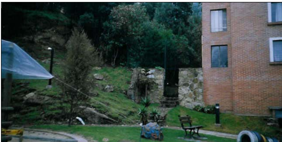
Foto 16. Vista de la parte baja de la zona 2, en el sector adyacente al Conjunto residencial Aragón. Allí se encuentra una capa delgada de coluvión clasto-soportado compuesto por grandes bloques de arenitas en matriz arcillosa; este depósito descansa sobre el sustrato de arenisca. Detrás del muro de piedra se efectuó un corte en roca.
