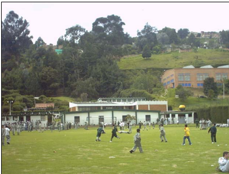
Foto 30. Panorámica desde la parte baja de la zona de estudio. Se observa el colegio Antonio Nariño y al fondo costado derecho el colegio Saint George, en frente del talud que se denominó en este estudio como zona geotécnica 3.
