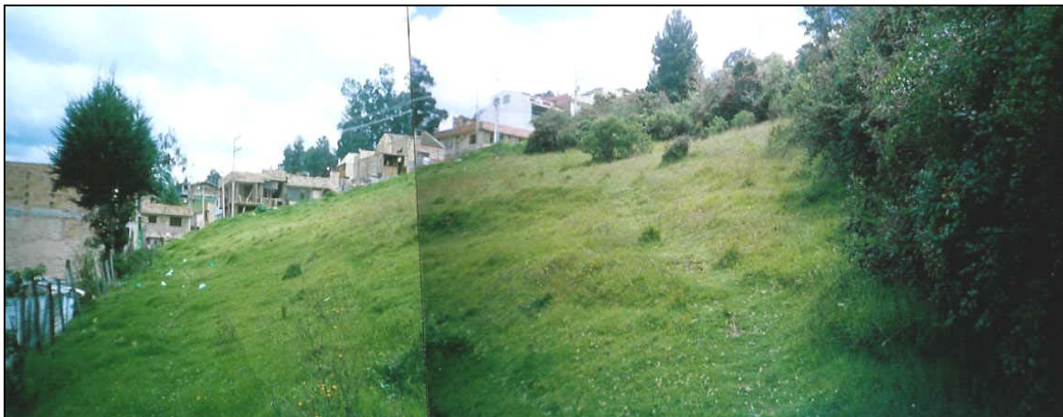
Foto 7. Vista general de la Zona Geotécnica 1, en la parte baja, al lado izquierdo se encuentran varias casas separadas de la ladera por un muro de piedra pegada de poca altura. Al lado derecho se presentan pequeñas lengüetas de falla de algunos deslizamientos menores de la parte alta; estos deslizamientos se encuentran retirados de la zona de las casas.
