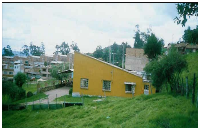
Foto 8. Vista lateral de la fila de casas que se encuentran en la parte baja de la zona 1. Las casas están separadas de la zona de ladera, por un pequeño muro en piedra pegada de mas de 40 años de antigüedad.
