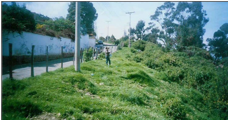
Foto 6. Vista lateral de la carrera 90, en el costado nor-oriental del área de estudio. Al lado derecho de la vía se encuentra un relleno el cual se dejó después de la conformación de la banca. Por otra parte se destaca la ausencia de cunetas en los bordes de la vía.
