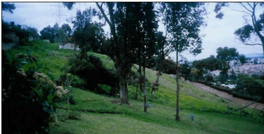
Foto 20. Vista general de la zona geotécnica 3, al costado sur de la zona de estudio. Se encuentran evidencias de reptación en la superficie producto del agua proveniente del predio de la señora Carmenza de Yepes, al lado derecho de la foto. En la casa blanca del lado derecha, también se vierten aguas residuales al suelo.
