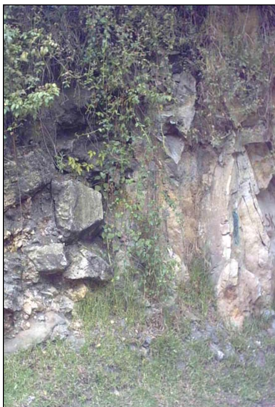
Foto 23. Detalle del macizo rocoso del costado nororiental de la zona de estudio.
