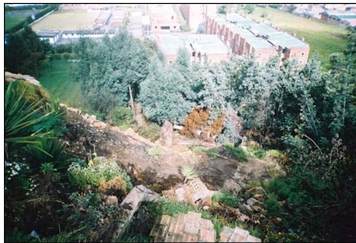
Foto 38. Esquina nor occidental de la casa de Don Octavio. Se generó el desprendimiento y la caída de un eucalipto, el cual se volcó hacia la zona del parque infantil; en donde existe una pequeña terraza natural justo debajo de la pata del deslizamiento.
