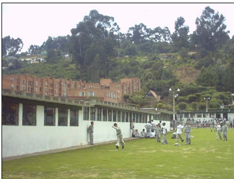
Foto 29. Foto tomada desde la parte baja de la zona de estudio. Se aprecia al fondo el talud central (zona geotécnica 2), que puede afectar los predios del colegio Antonio Nariño. Se observa también, al costado izquierdo de la foto, el Conjunto Aragón.
