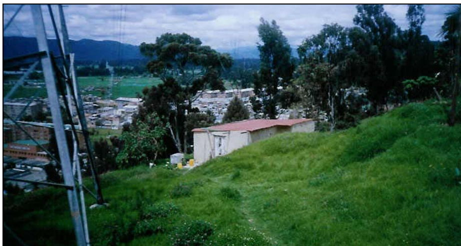
Foto 21. Detalle de la casa blanca localizada en el extremo sur-oriental de la zona 3. Allí se presenta el vertimiento de aguas residuales hacia la parte baja, contribuyendo a acentuar los problemas de deformaciones por reptación en la parte baja de la ladera..
