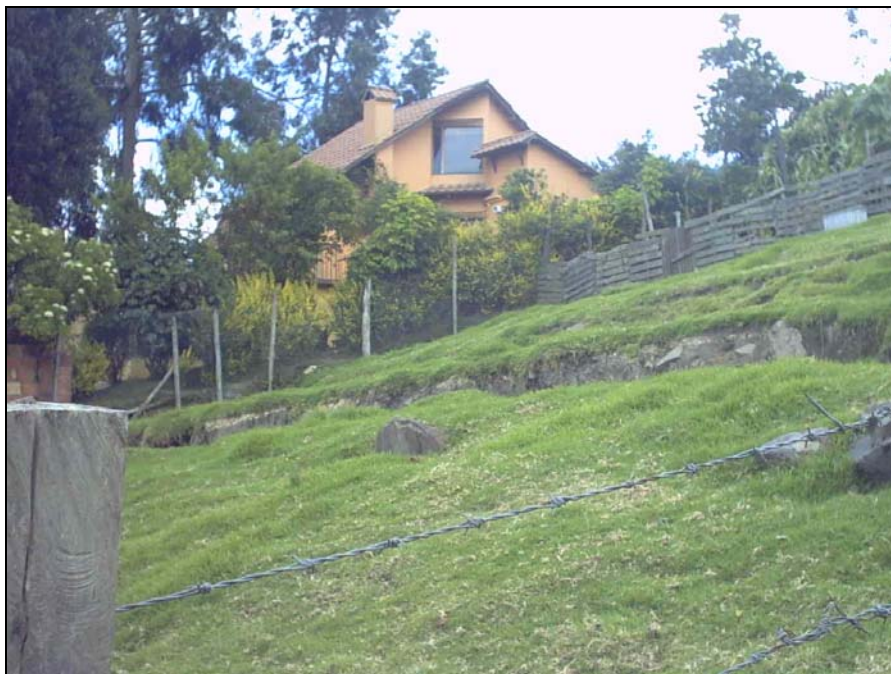
Foto 25. Al fondo se aprecia la casa ubicada en la Carrera 90 No. 157-13, de propiedad del señor Raúl Cristancho. Obsérvese el escarpe del tercer escarpe de falla, que amenaza la casa mencionada.
