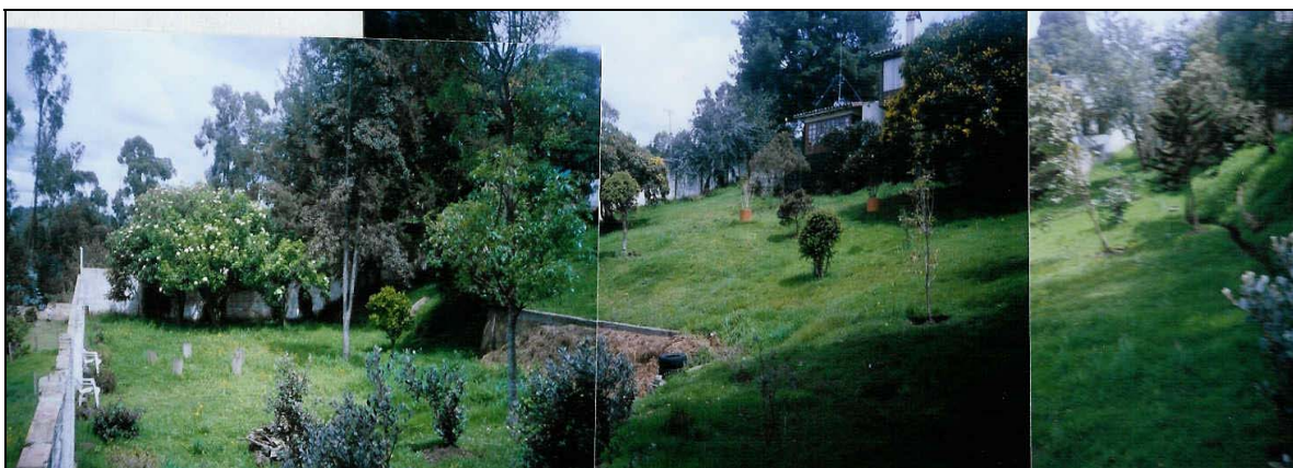
Foto 19. Predio de la señora Carmenza de Yepes, visto desde el lado sur. Allí se encuentran algunos rellenos locales detrás del muro cerramiento y de un muro interno localizado en la parte media de la foto. El agua superficial es conducida a lo largo de un zanjón que se prolonga por el muro oriental (lado izquierdo de la foto), saturando el terreno en la parte baja al otro lado del muro.
