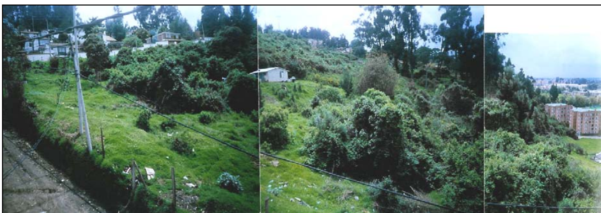
Foto 5. Vista general de la Zona geotécnica 1, en la parte alta, al costado nótase encuentra un terreno de pendiente moderada con la presencia de movimientos de masa antiguos, flujos de tierras y deslizamientos rotacionales de poca profundidad. En este sector se encuentra solamente una casa prefabricada la cual está cimentada en una zona estable.
