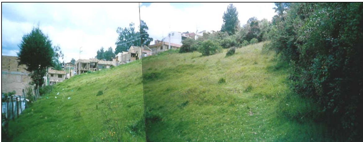
Foto 7. Vista general de la Zona Geotécnica 1, en la parte baja, al lado izquierdo se encuentran varias casas separadas de la ladera por un muro de piedra pegada de poca altura. Al lado derecho se presentan pequeñas lengüetas de falla de algunos deslizamientos menores de la parte alta; estos deslizamientos se encuentran retirados de la zona de las casas.
