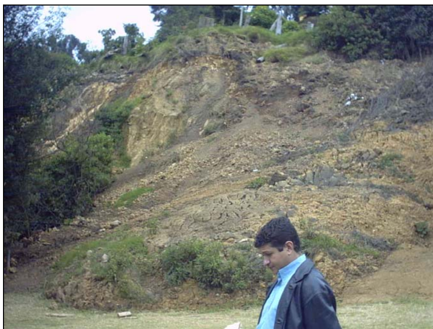
Foto 33. Vista de la pata del deslizamiento de la zona geotécnica 2, la cual afecta parte de los predios del colegio Antonio Nariño; superficialmente se ven flujos de lodos. El movimiento no ha afectado estructuras existentes en la parte inferior (colegio Antonio Nariño y Conjunto Aragón).
