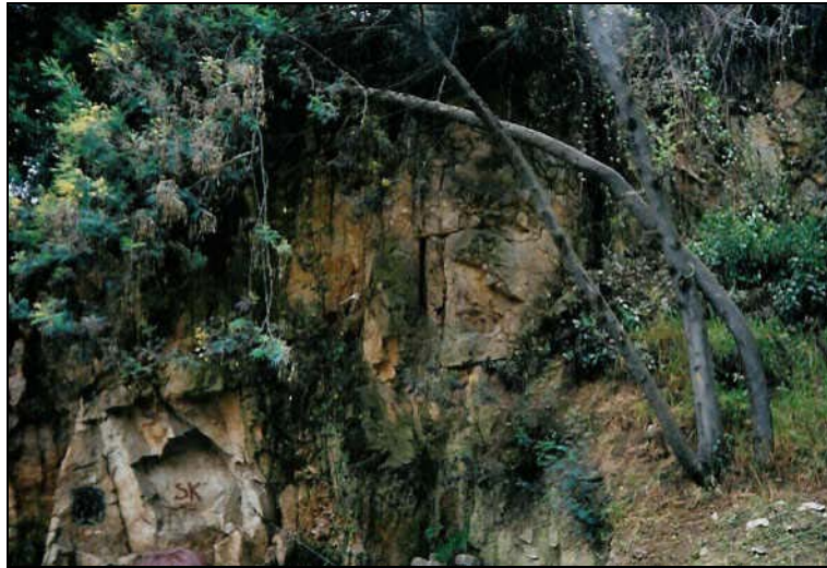
Foto 3. Vista del talud de corte en frente del Conjunto Residencial Aragón; el sustrato de arenisca buza levemente en la misma dirección de la ladera natural, y éste en conjunto con otras familias de diaclasas verticales que generan bloques susceptibles a desprendimientos.
