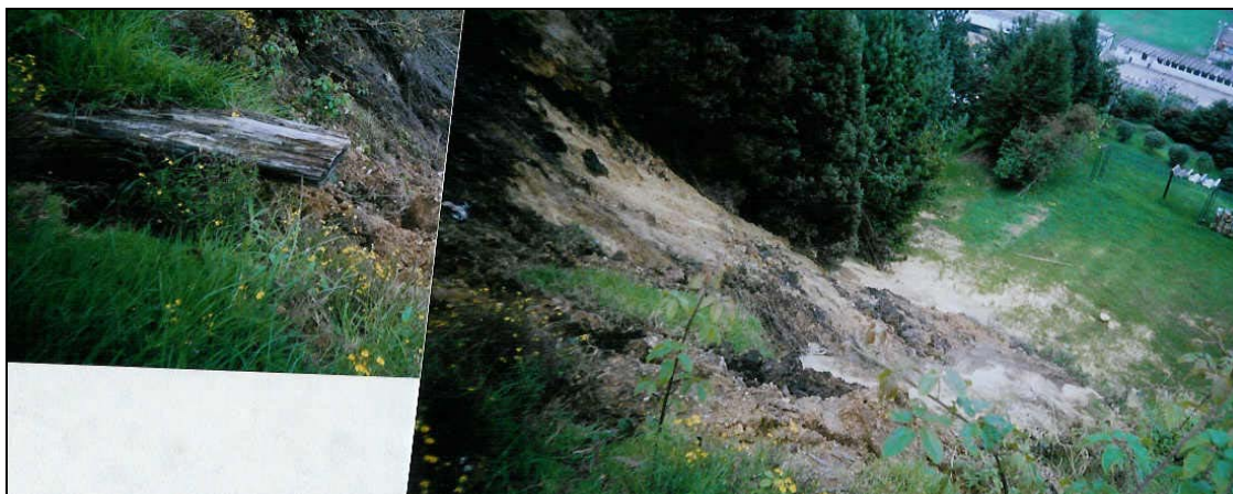
Foto 17. Detalle de un flujo de lodos que se originan en la parte alta del Colegio Antonio Nariño y que genera amenaza potencial sobre algunas de las instalaciones del Colegio. Es necesario contemplar la construcción de un dique de contención de lodos, para evitar que éstos invadan las instalaciones.
