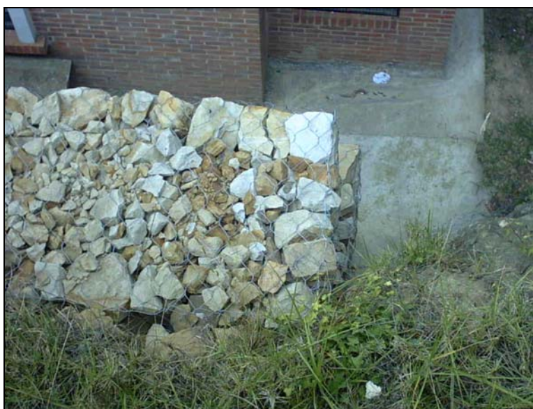
Foto 35. Vista desde arriba del muro en gaviones construido para evitar caída de bloques del macizo rocoso sobre los edificios del Conjunto Aragón.
