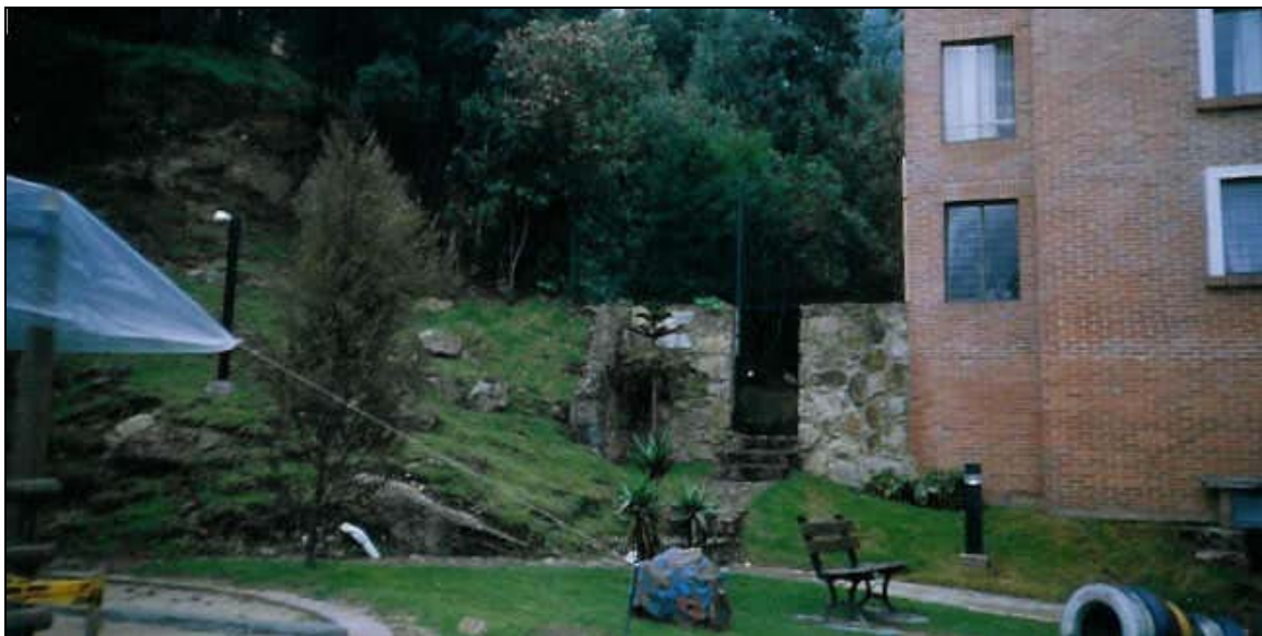
Foto 16. Vista de la parte baja de la zona 2, en el sector adyacente al Conjunto residencial Aragón. Allí se encuentra una capa delgada de coluvión clasto-soportado compuesto por grandes bloques de arenitas en matriz arcillosa; este depósito descansa sobre el sustrato de arenisca. Detrás del muro de piedra se efectuó un corte en roca.
