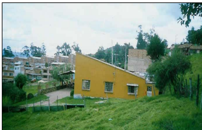
Foto 8. Vista lateral de la fila de casas que se encuentran en la parte baja de la zona 1. Las casas están separadas de la zona de ladera, por un pequeño muro en piedra pegada de mas de 40 años de antigüedad.
