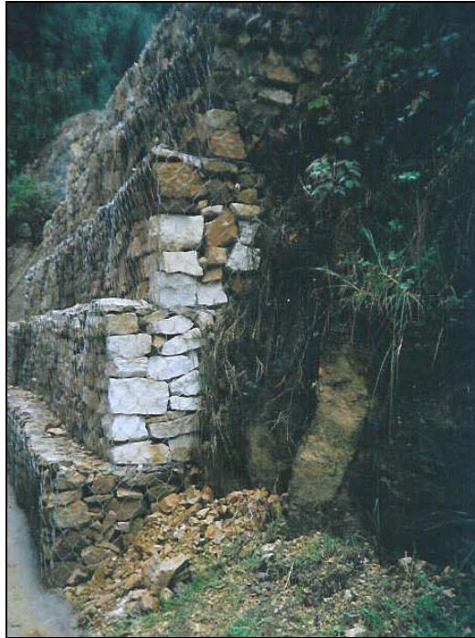
Foto 18. Detalle del talud de corte sur en el interior del Conjunto Residencial Aragón. Se encuentra un muro escalonado de gaviones de 5 m de altura y 2 m de ancho; el muro está recargado contra el macizo rocoso fracturado.
