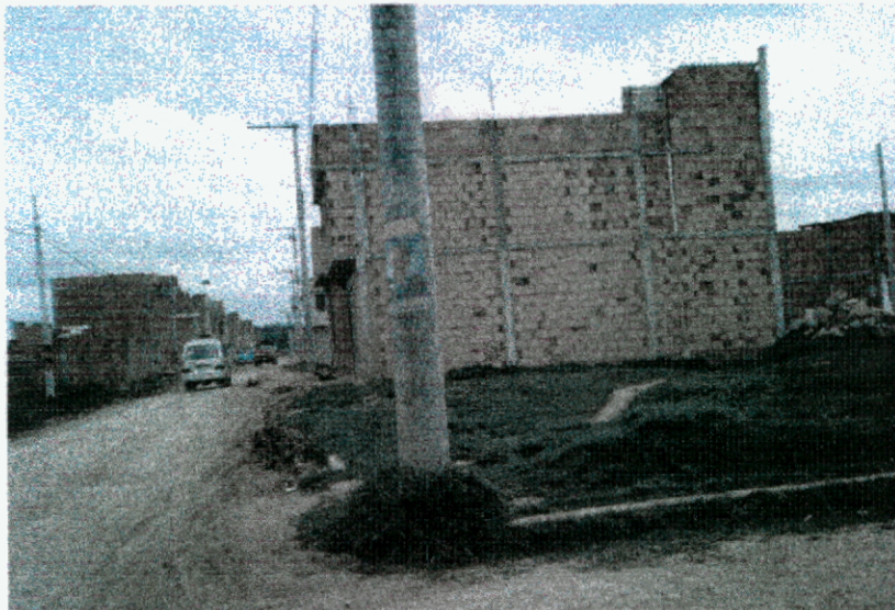
Foto 4. Panorámica del barrio Prados de La Alameda.
