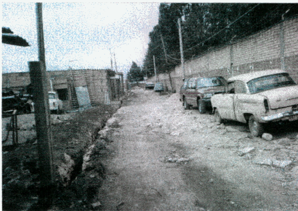
Foto 8. Barrio Villa Andrea. Se observa proceso de construcción del alcantarillado a través de la gestión comunitaria
