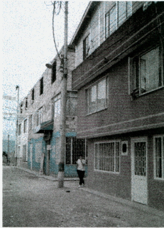
Foto 9. Viviendas del barrio Paraíso de Bavaria. Se observa la buena calidad de la construcción, con viviendas de hasta tres plantas con acabados.
