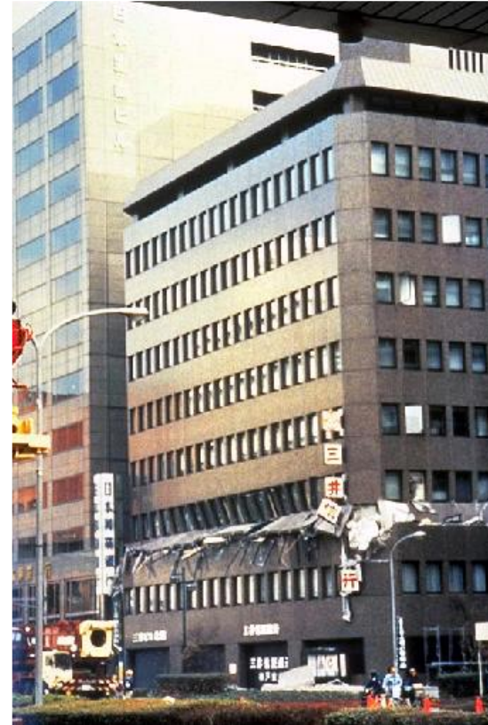
Pérdida de piso en un edificio en Kobe, 1995
