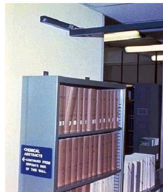
a) Estantería anclada a la pared
