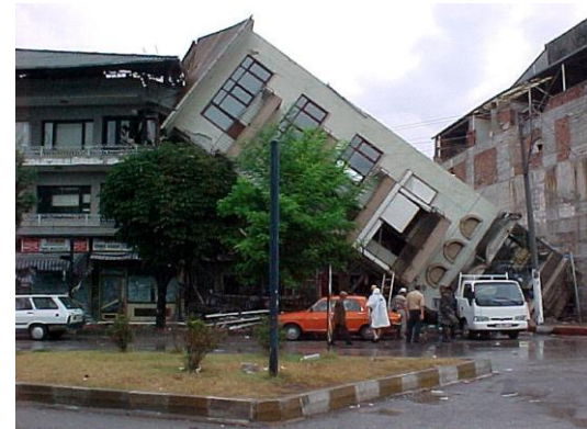
Volcamiento en Turquía por falla en cimentación.
