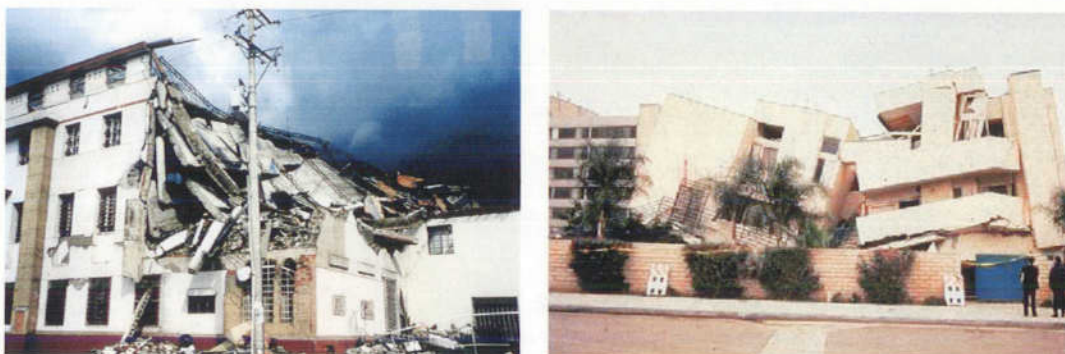
Figura 3-1: Daño Estructural en edificios.
