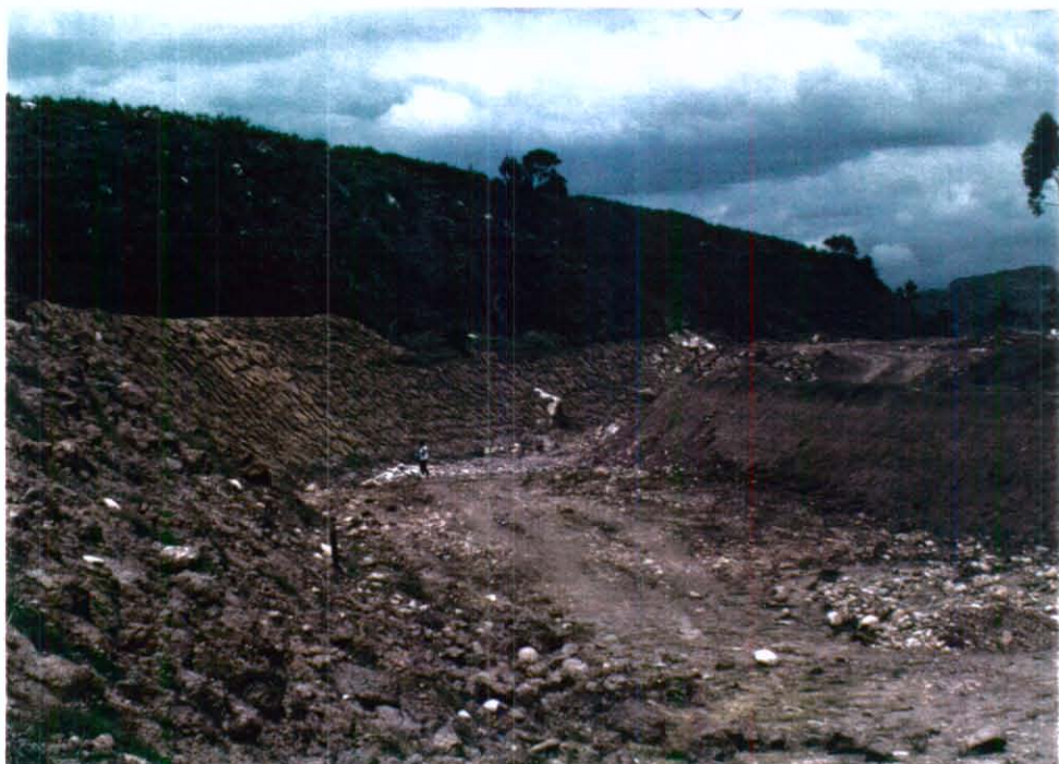
FOTO 5. Revegetalización concluída de uno de los taludes del nuevo canal del río Tunjuelito. Se debe esperar el crecimiento del césped.
