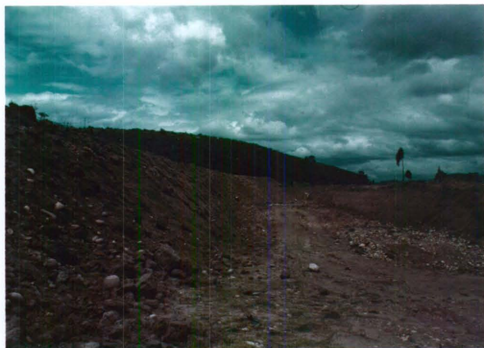
FOTO 12. Panorámica de un talud con la empradización concluida. Se debe esperar el crecimiento del pasto.
