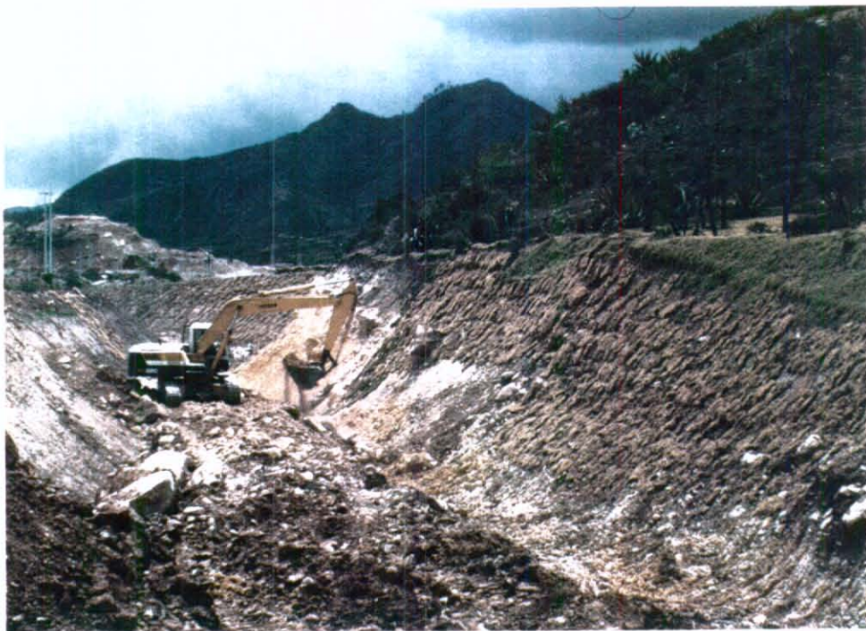
FOTO 1. Preparación del talud para su empradización en el nuevo canal del rio Tunjuelito.
