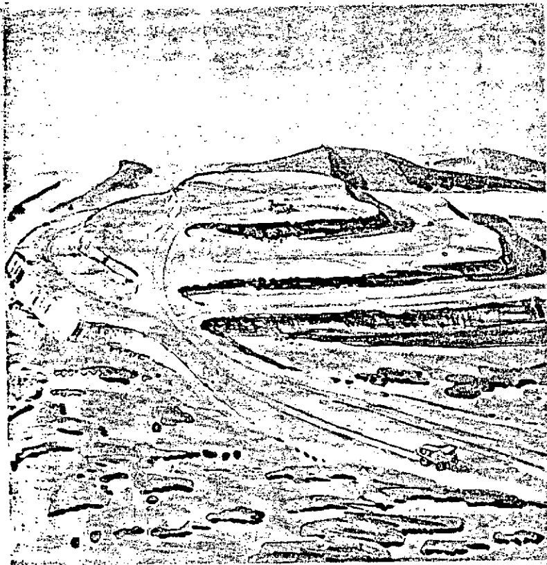
- RELLENO CONSTRUIDO EN CAPAS SUCESIVAS
