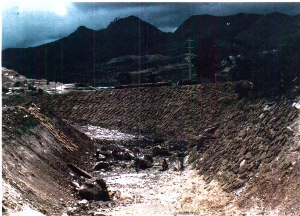
FOTO 2. Proceso de revegetalización del talud con cespedón. Finalmente se tendrá una cobertura del 100%.
