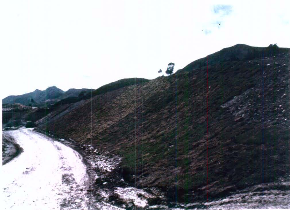
FOTO 4. Panorámica de la empradización de uno de los taludes definitivos de la mina.
