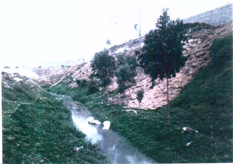
FOTO 3. Revegetalización de taludes. Obsérvese el adecuado manejo que se le hizo al talud.
