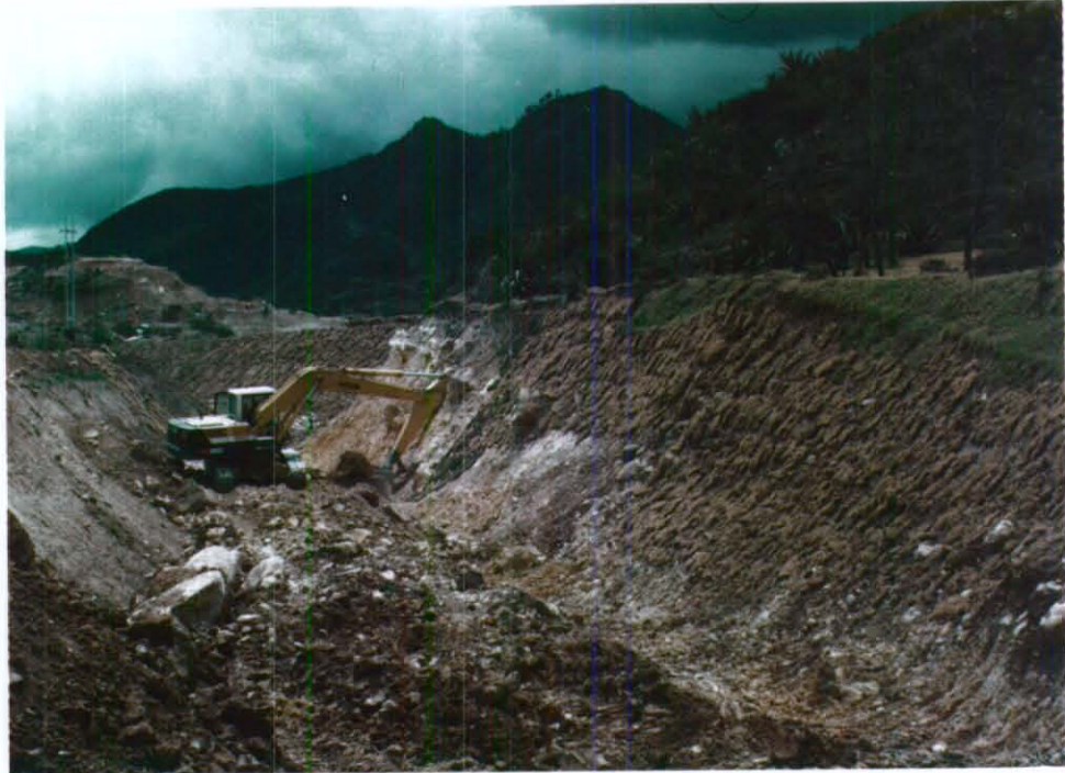
FOTO 9. Preparación del talud para su empradización en el nuevo canal del rio Tunjuelito.
