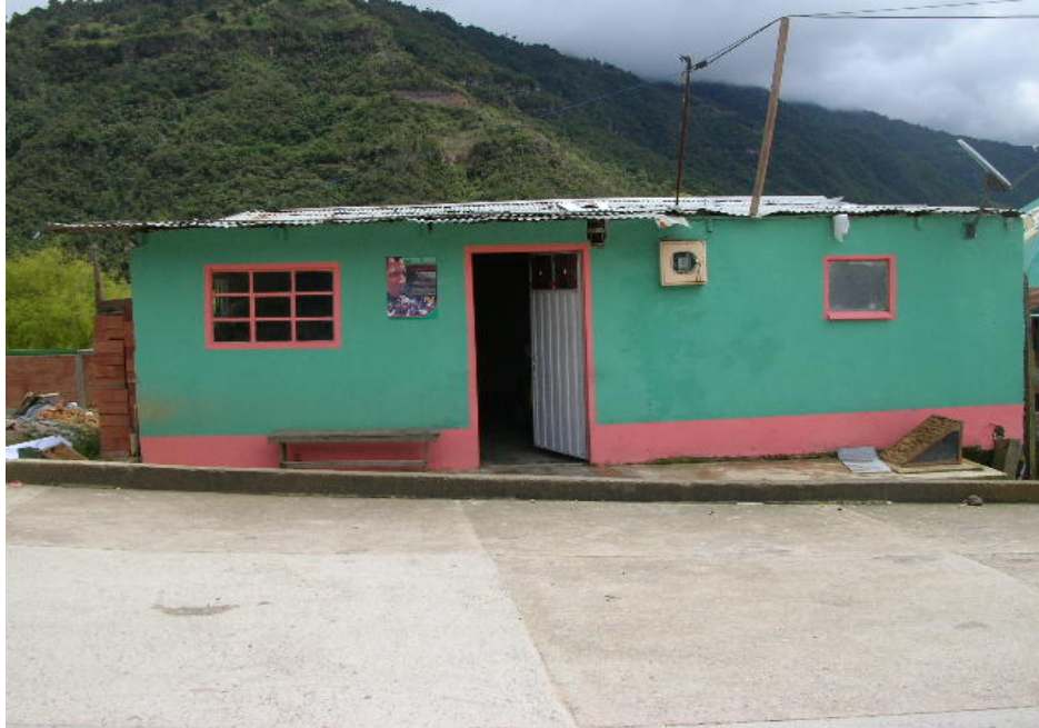
FACHADA PRINCIPAL, ENTRADA AL PREDIO VISTO HACIA EL SUR-ESTE
