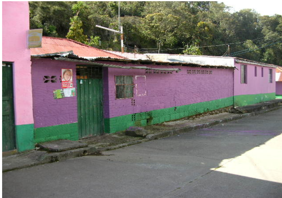
FACHADA PRINCIPAL EN BUEN ESTADO VISTA HACIA EL OESTE
