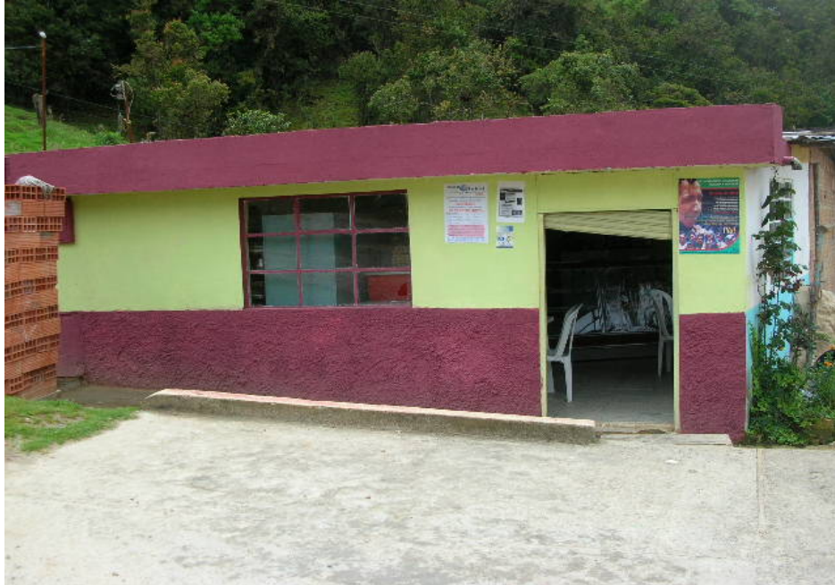
FACHADA PRINCIPAL DEL PREDIO 0009 VISTO HACIA EL ESTE, SE OBSERVA EN BUEN ESTADO
