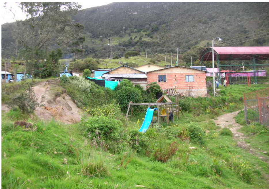
PANORAMICA DE LA FACHADA ESTE DEL PREDIO, NO SE OBSERVAN GRIETAS O AVERIAS
