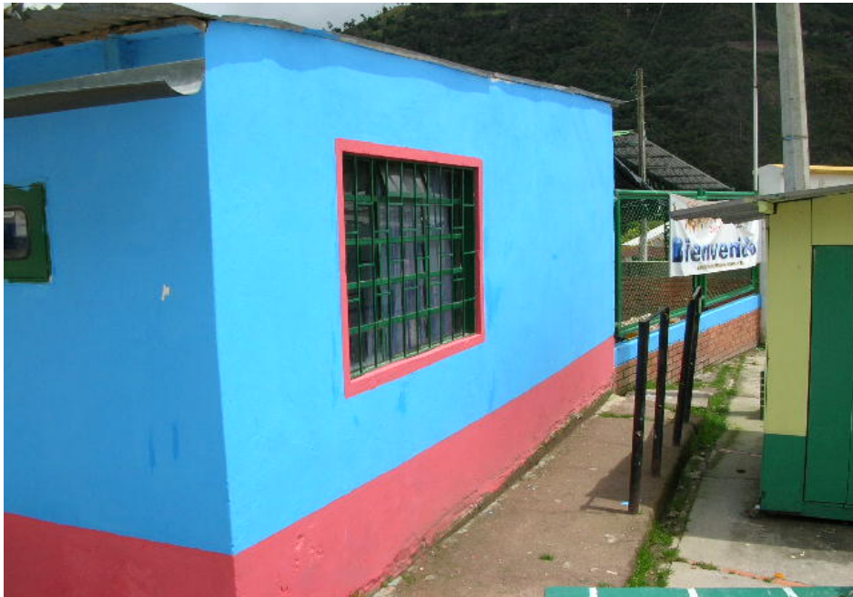
ZONA LATERAL DEL PREDIO, VISTA HACIA EL NOR-ESTE
