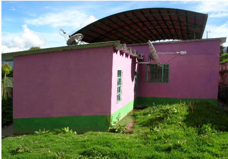
DETALLE FACHADA NORTE EN BUEN ESTADO
