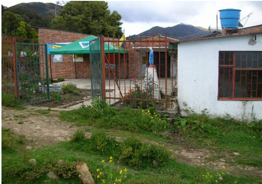
FACHADA DEL COLEGIO VISTO HACIA EL NORTE
