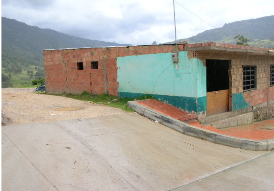
FACHADA NOR-ESTE Y FACHADA PRINCIPAL, EN PROCESO DE CONSTRUCCIÓN
