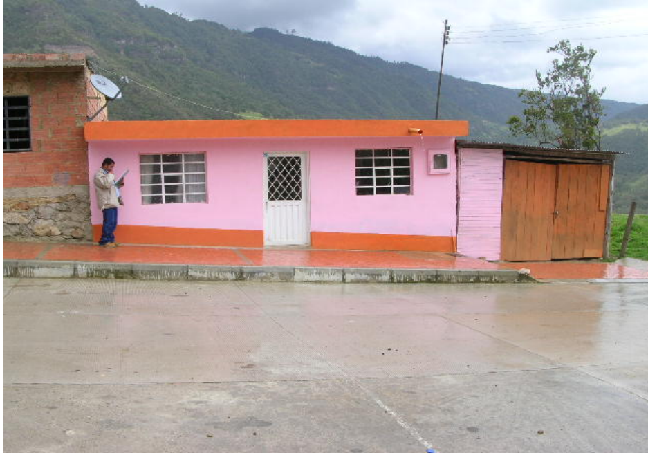
FAHCADA PRINCIPAL DEL PREDIO VISTO HACIA EL SUR-ESTE, LA VIVIENDA SE ENCUENTRA EN BUEN ESTADO
