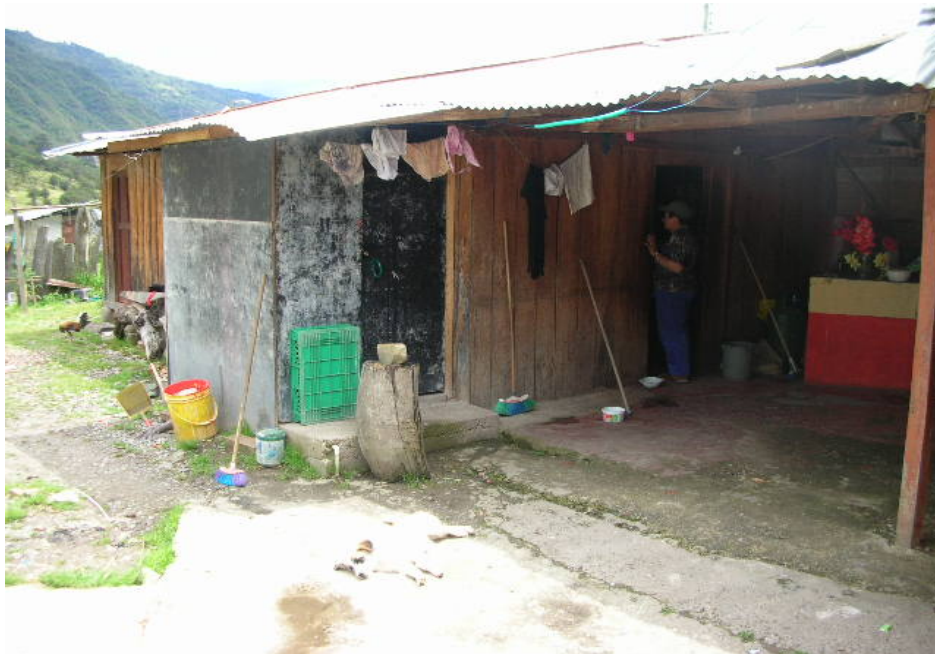
ZONA TRASERA DE LA VIVIENDA CONSTRUIDA EN MADERA
