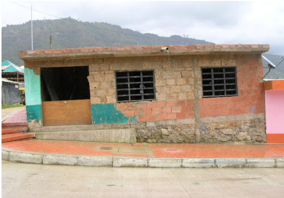
FACHADA PRINCIPAL, FOTOGRAFIA TOMADA HACIA EL SUR-ESTE
