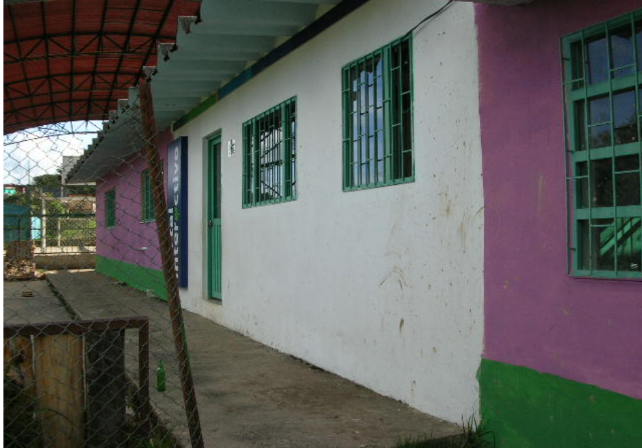
FACHADA ESTE DEL SALÓN COMUNAL VISTA HACIA EL SUR
