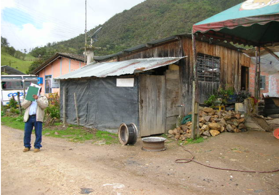
ZONA TRASERA DEL PREDIO CONSTRUIDA EN MADERA, EN BUEN ESTADO
