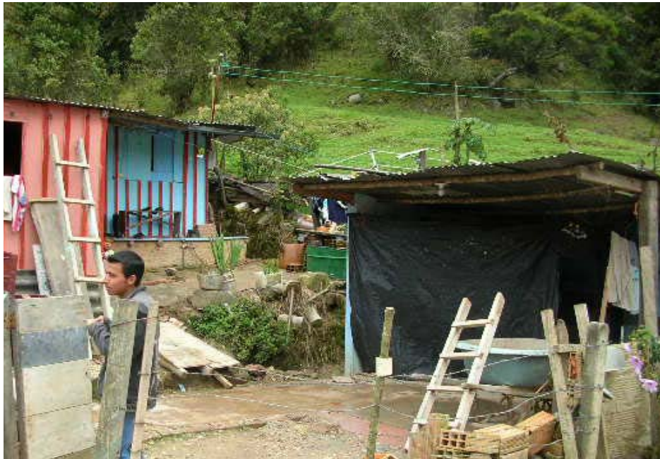
CUARTO ANEXO EN MADERA Y TEJAS DE ZINC
