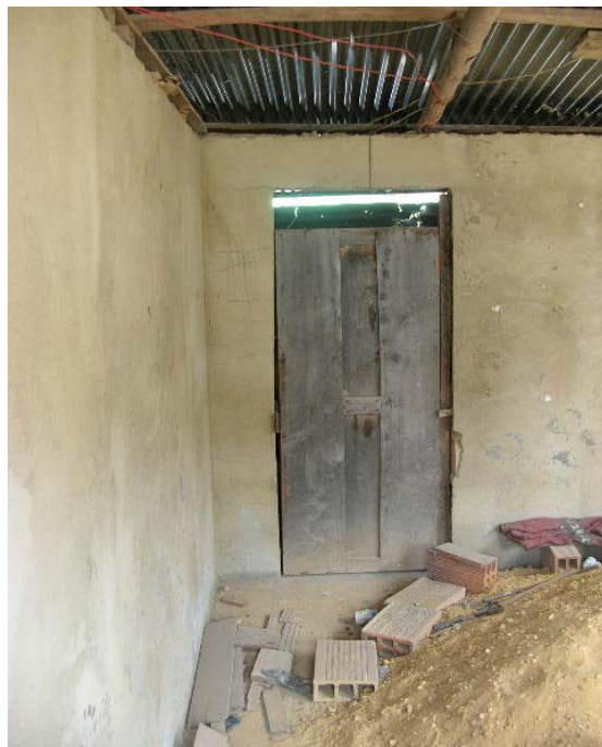
DETALLE DEL INTERIOR EN PROCESO DE CONSTRUCCIÓN
