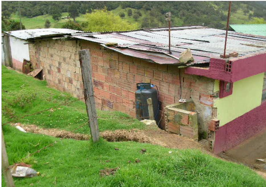
FACHADA NORTE, VISTA HACIA EL SUR-ESTE
