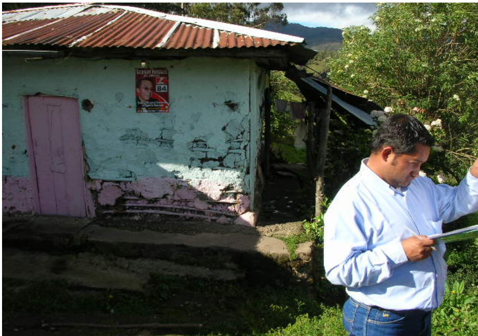
ZONA SUR EN BAREQUE EN MAL ESTADO
