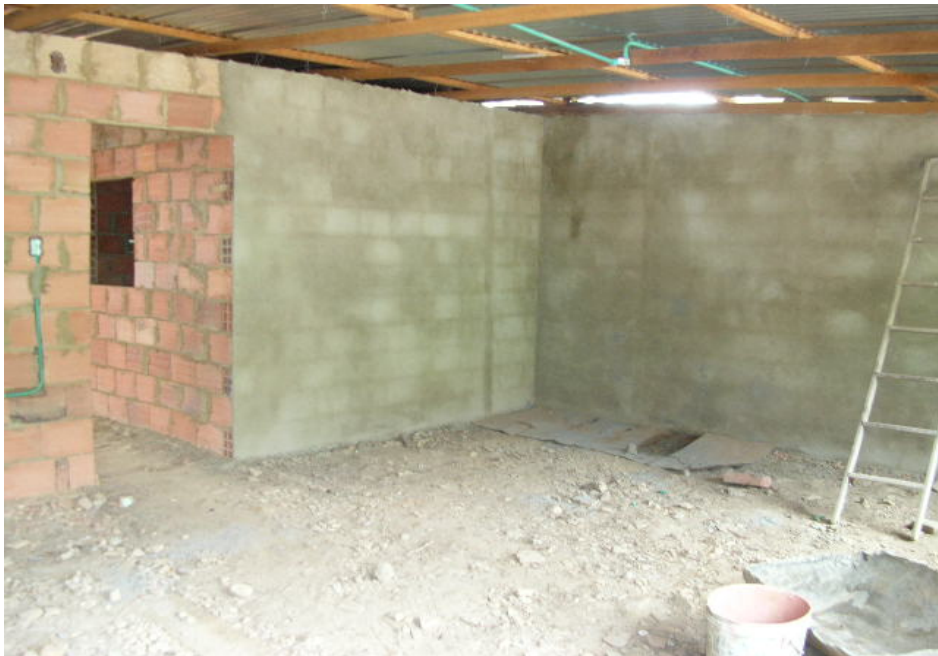
ZONA INTERIOR DEL PREDIO 0018 EN PROCESO DE CONSTRUCCIÓN
