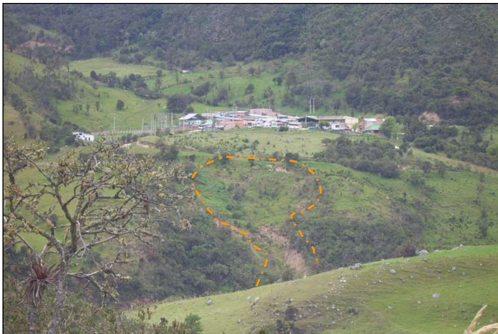
Fotografía 12 Deslizamiento ladera abajo de la vía a la vereda Tunal Bajo
