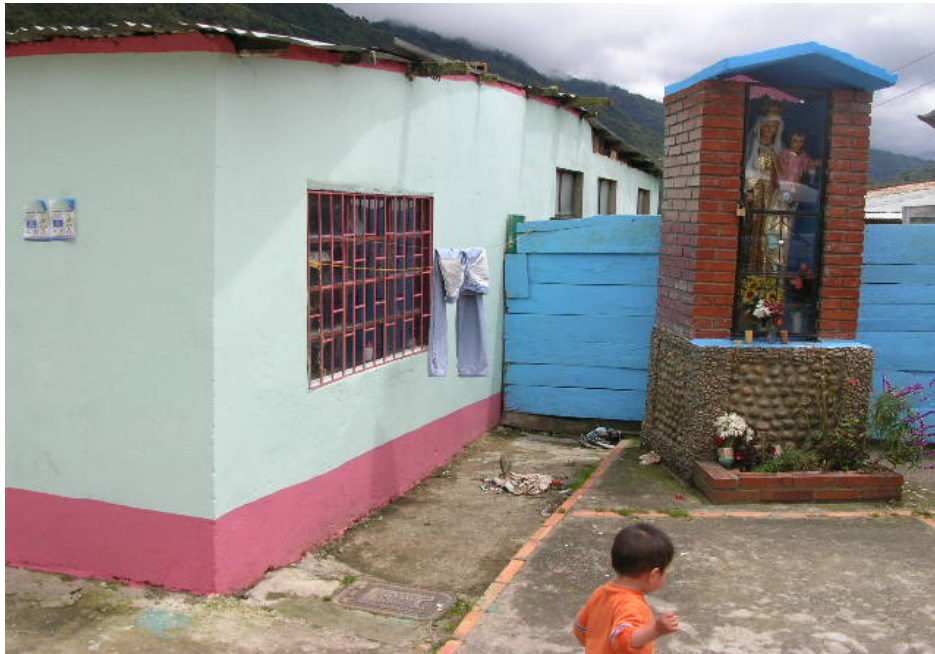
FACHADA SUR ESTE EN BUEN ESTADO
