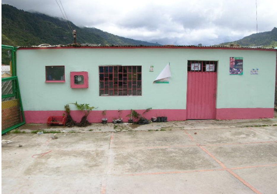
FACHADA PRINCIPAL DEL PREDIO 0015 VISTA HACIA EL SUR-ESTE
