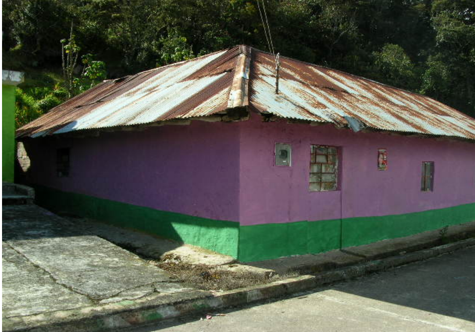
FACHADAS ESTE Y SUR DEL PREDIO 0078, NO SE OBSERVAN GRIETAS O AVERIAS
