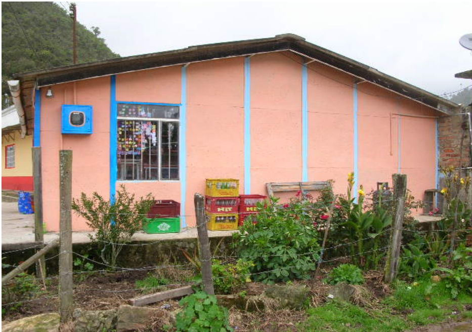
FACHADA SUR-OESTE EN BUEN ESTADO
