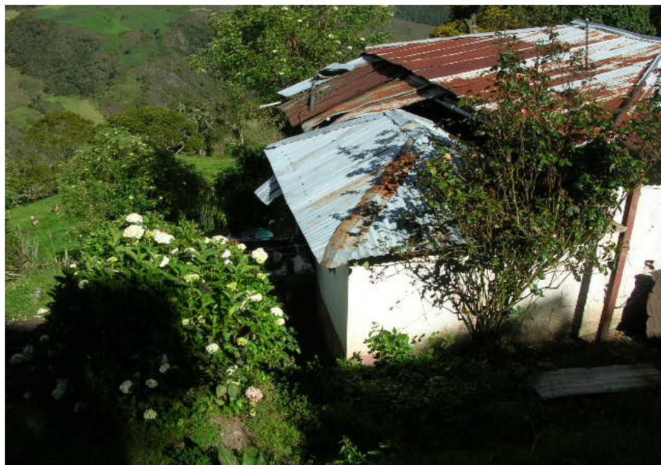
ZONA DE ACCESO AL PREDIO POR EL NORTE.
