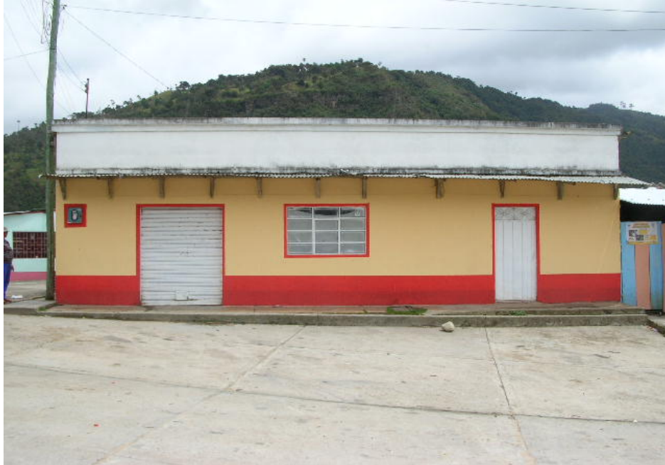
FACHADA PRINCIPAL VISTA HACIA EL ESTE EN BUEN ESTADO
