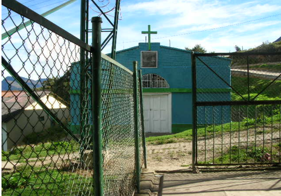
FACHADA PRINCIPAL DE LA IGLESIA
