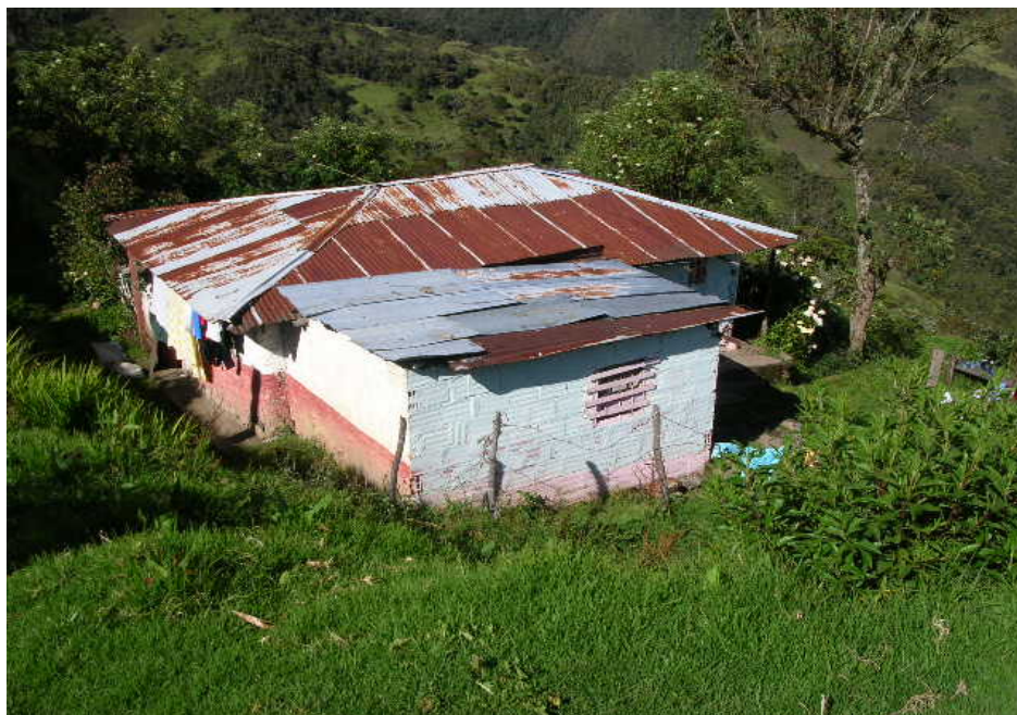
PANORAMICA DEL PREDIO 0079 VISTO HACIA EL NOR-OESTE
