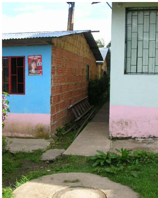
PANORAMICA DE LA FACHADA OESTE DEL PREDIO, NO SE OBSERVAN GRIETAS O AVERIAS
