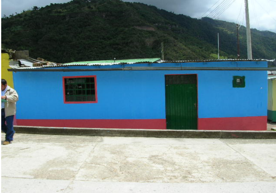
PREDIO 0013, ZONA CONSTRUIDA EN MAMPOSTERIA NO REFORZADA, EN BUEN ESTADO, FOTOGRAFIA VISTA HACIA EL SUR-ESTE
