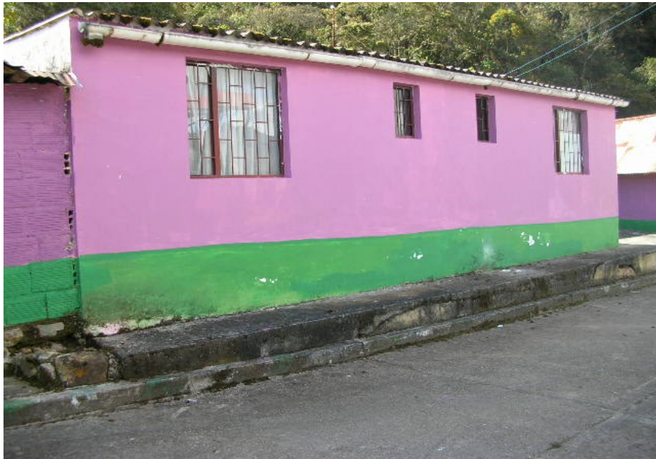
FACHADA ESTE EN BUEN ESTADO
