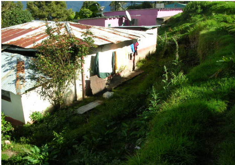
FACHADA OESTE DEL PREDIO 0079
