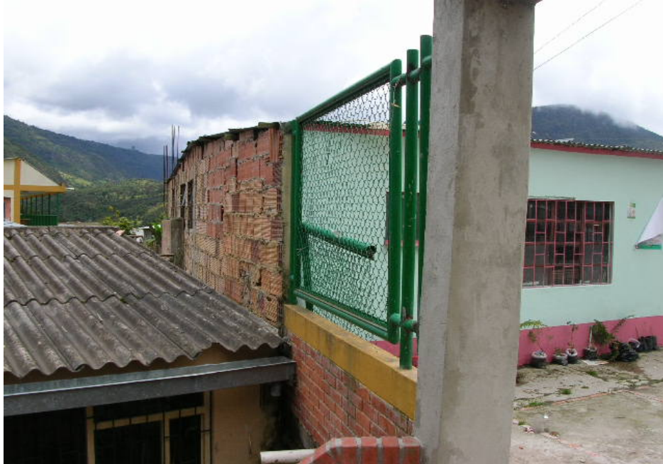
FACHADA IZQUIERDA DEL PREDIO VISTO HACIA EL SUR
