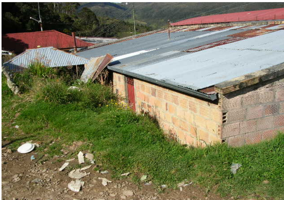
FACHADA TRASERA, EN BUEN ESTADO
