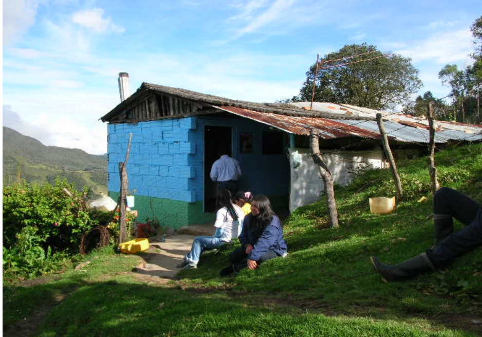
PANORAMICA ACCESO AL PREDIO 0080 EN MAMPOSTERIA NO CONFINADA, MADERA Y LATAS
