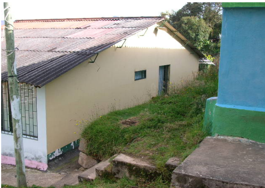
DETALLE FACHADA OESTE EN BUEN ESTADO.
