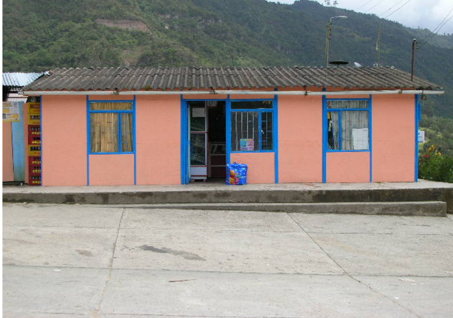
FACHADA PRINCIPAL PREDIO 0017 (PREFABRICADO) EN BUEN ESTADO, FOTOGRAFIA VISTA HACIA EL SUR-ESTE
