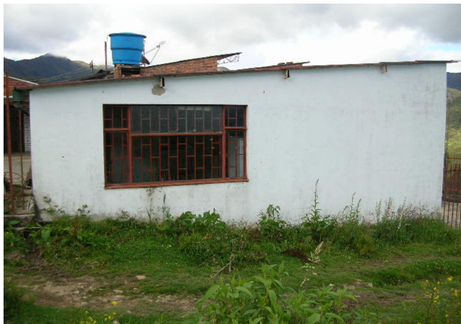
FACHADA SUR EN BUEN ESTADO
