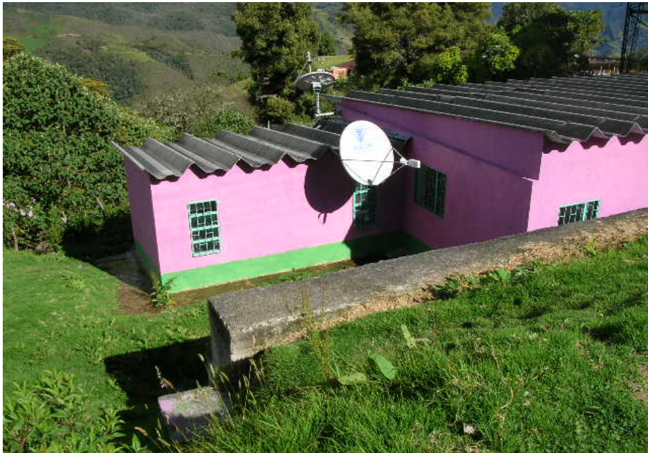
ZONA NOR OESTE DEL SALÓN COMUNAL EN BUEN ESTADO
