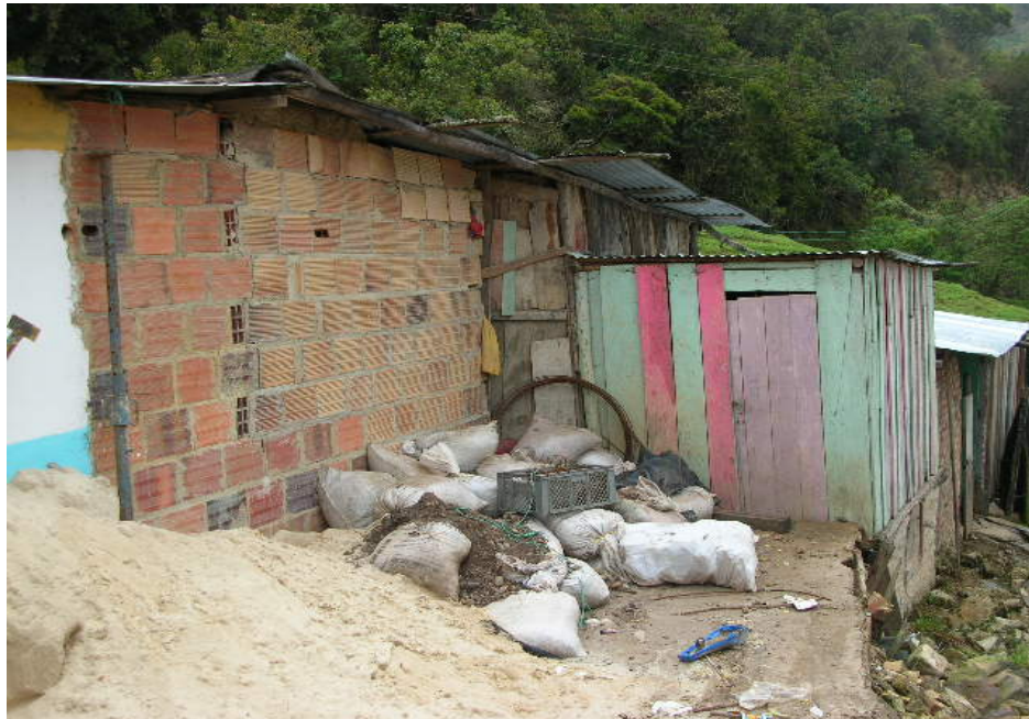
FACHADA SUR VISTO HACIA EL NOR-ESTE, DETALLE DE PARTE CONSTRUIDA EN MADERA
