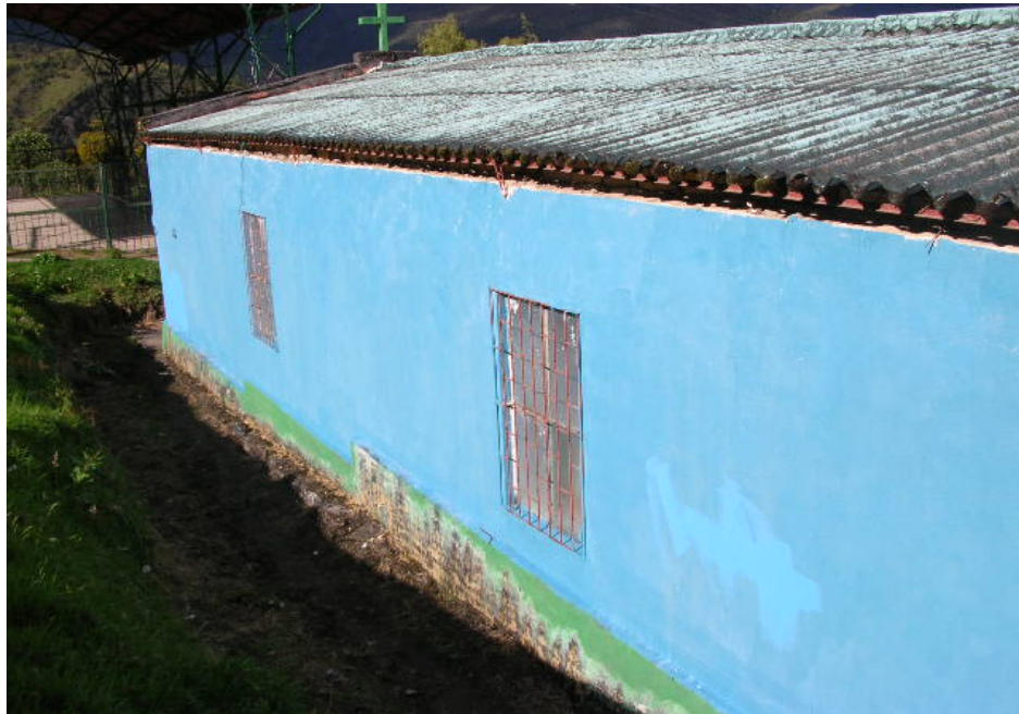
FACHADA OESTE DE LA IGLESIA EN BUEN ESTADO
