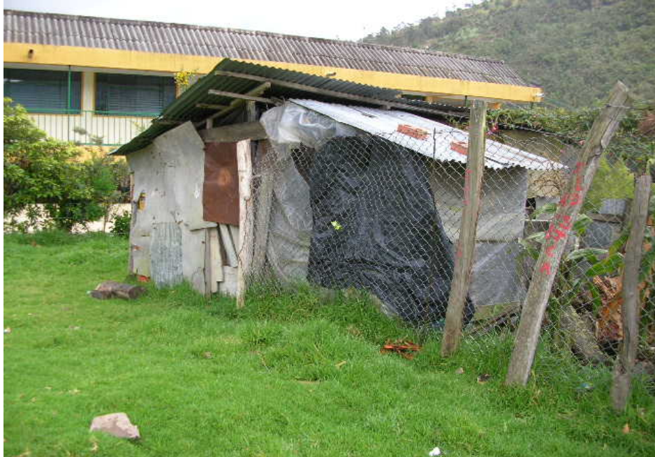
FACHADA IZQUIERDA VISTA HACIA EL ESTE
