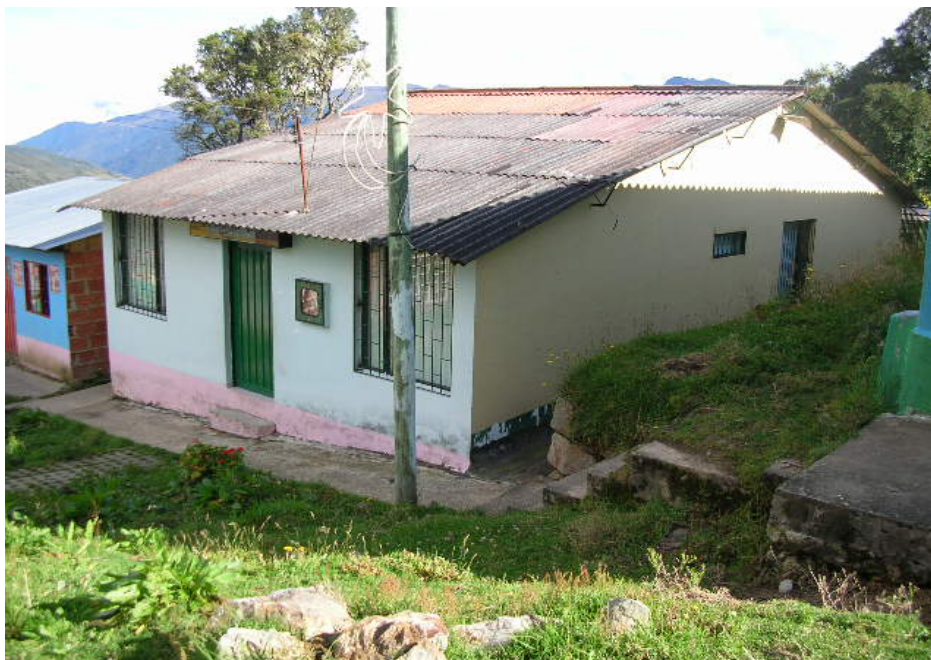
PANORAMICA GENERAL DEL PREDIO, VISTA DE FACHADA PRINCIPAL Y FACHADA OESTE.
