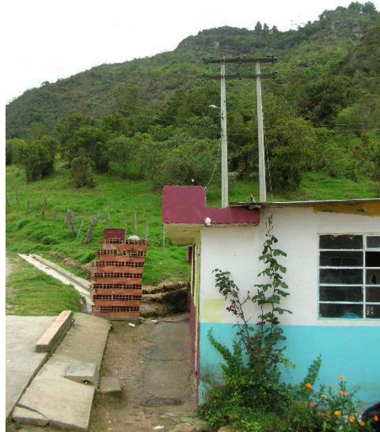
DETALLE LINEA DE TRANSMISIÓN DE ENERGÍA VISTO HACIA EL OCCIDENTE
