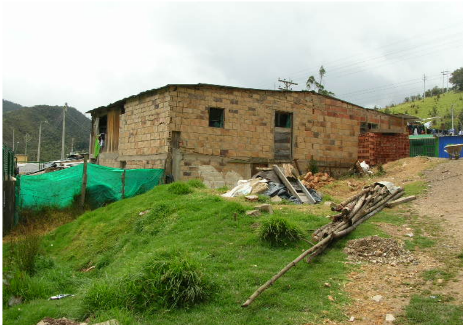
FACHADA TRASERA Y ZONA LATERAL, FOTOGRAFIA TOMADA HACIA EL OESTE
