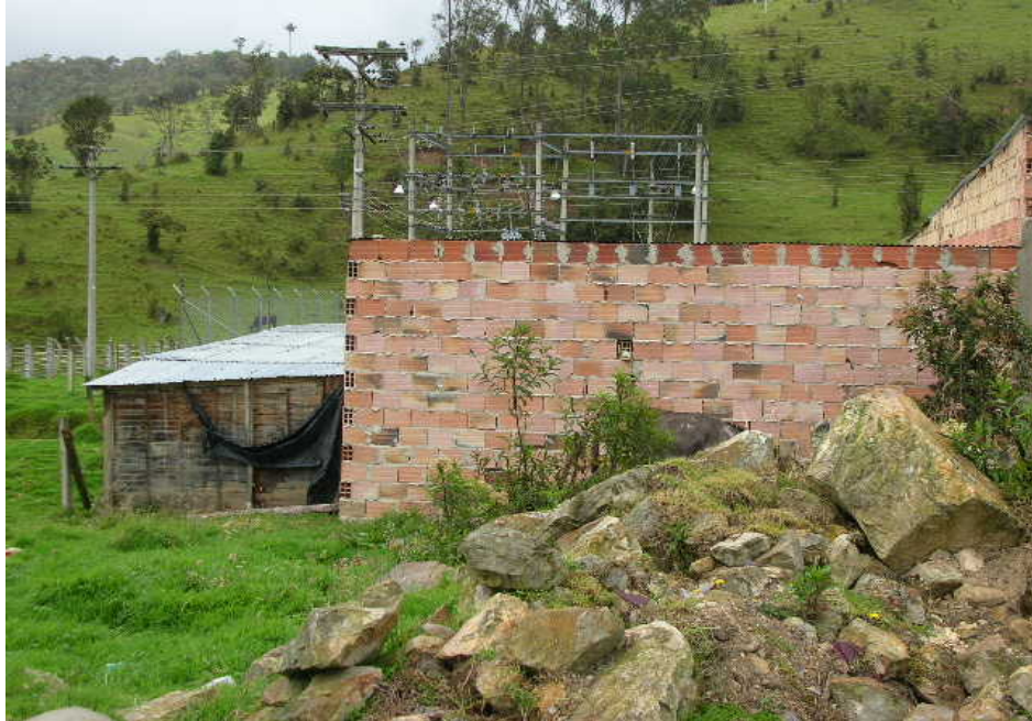
ZONA EN MADERA DEL PREDIO 0019 Y FACHADA TRASERA VISTA HACIA EL NOR-OESTE, ACUMULACIÓN DE RESIDUOS DE CONSTRUCCIÓN
