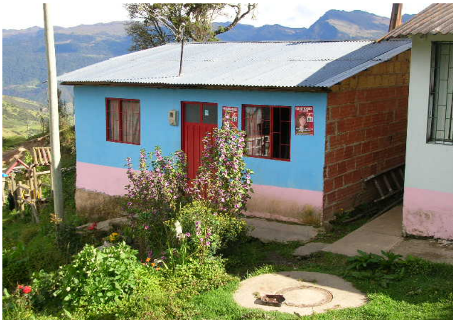
FACHADA PRINCIPAL DEL PREDIO VISTO HACIA EL SUR, SE ENCUENTRA EN BUEN ESTADO
