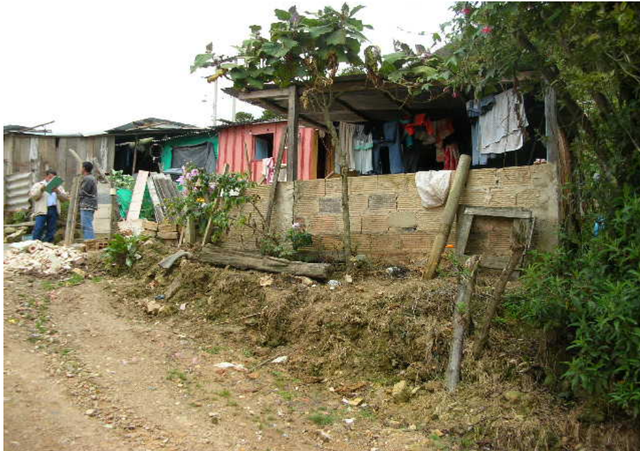
FAHCADA PRINCIPAL DEL PREDIO VISTO HACIA EL NORTE
