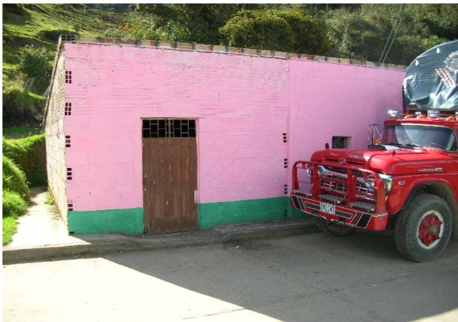
PANORAMICA FACHADA PRINCIPAL DEL PREDIO VISTO HACIA EL OESTE
