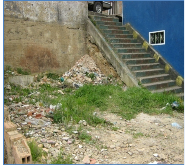
Foto 13. Rellenos antrópicos cartografiados como Sa1, localizados en la parte alta del sector occidental.
