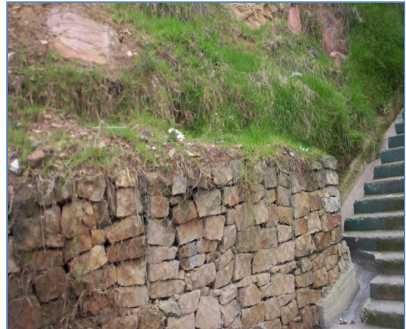
Foto 2. Vista del muro en gaviones construido en la parte inferior, límite de la zona oriental y occidental.
