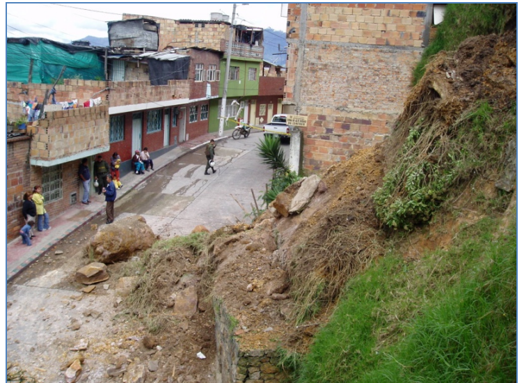
Foto 4. Evento del 18 de noviembre de 2006 – desprendimientos de suelos y bloques desde el talud de corte del predio ubicado en la Carrera 17A No. 33B – 50 Sur del barrio Río de Janeiro El Pesebre.
