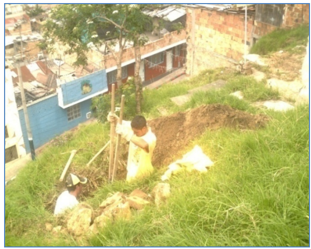
Foto 9. Apique AP-2, realizado en el costado oriental zona de estudio.
