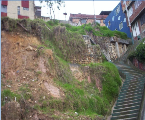
Foto 6. Obras de contención, en el costado oriental conformadas por muros en concreto ciclópeo a media ladera.
