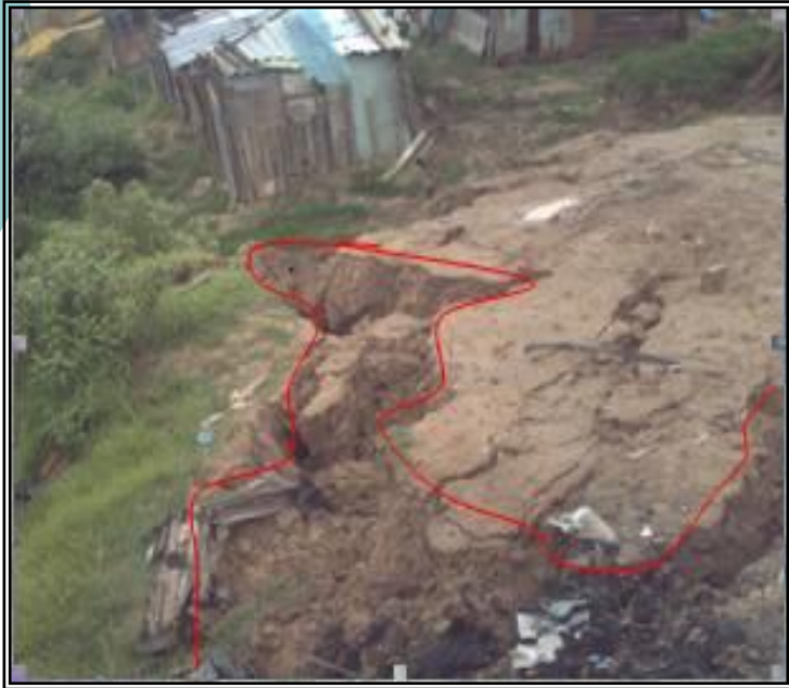
Flanco derecho del deslizamiento, afectado por carcavamiento.
