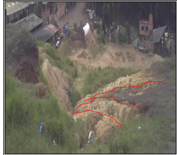
Zona de agrietamiento lo cual evidencia el estado activo del deslizamiento.
