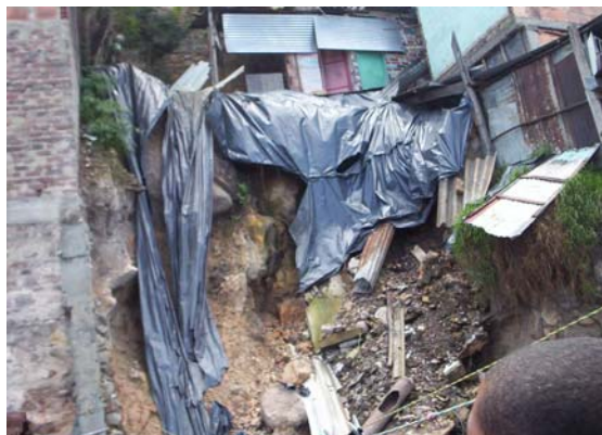
Foto 2, Se puede observar en la parte izquierda de la imagen caída de bloques y detritos en el talud de estudio.
