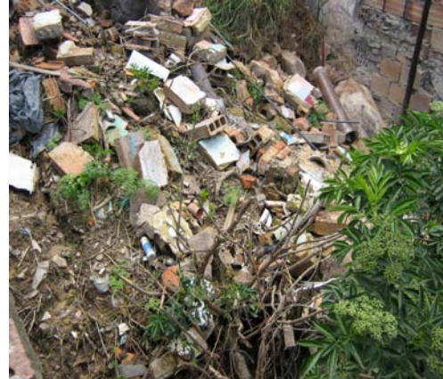
Foto 9 y Foto 10. Vista de detalle parte media inferior del deslizamiento. Obsérvese el material principalmente de escombros, de composición variada, los cuales cubren el sitio de una antigua construcción demolida.
