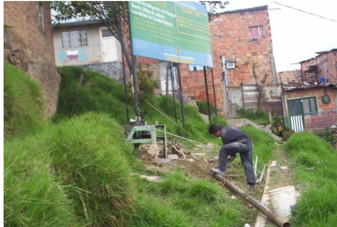
Foto 21. Sondeo realizado en la zona de escarpe en el talud sur.
