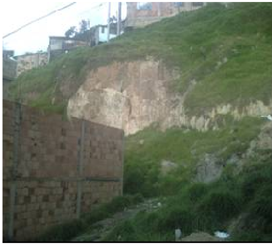
Foto 5. Viviendas afectadas den la pata del talud de la zona norte
