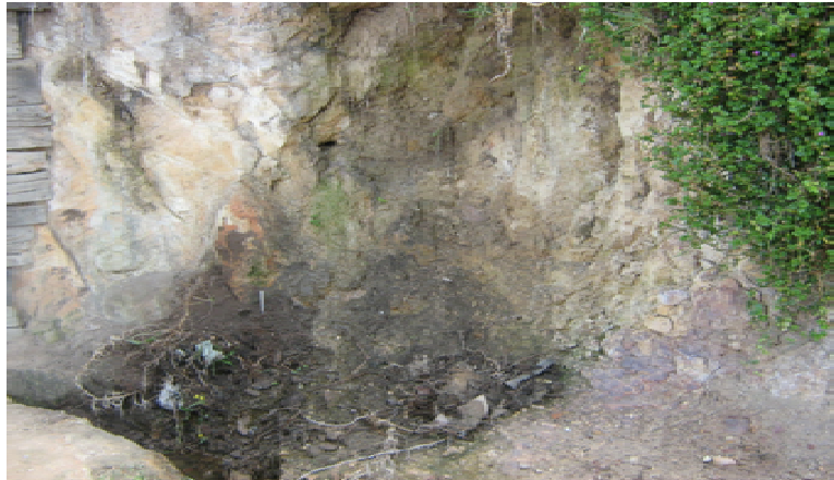
Foto 19. Afloramientos de areniscas, la cual a través del macizo rocoso se presenta infiltración de agua
