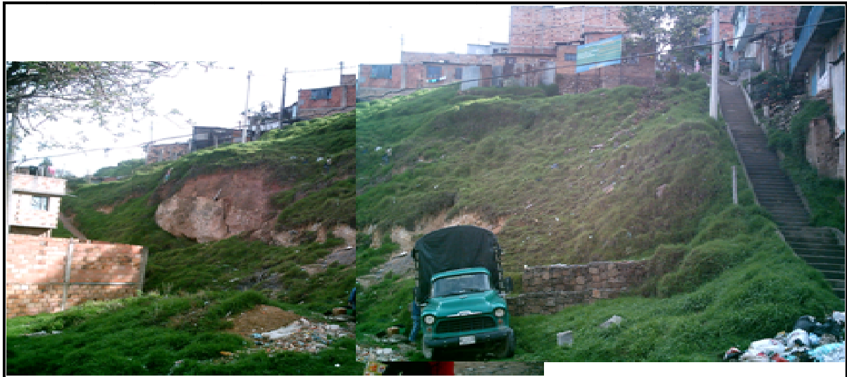
Foto 1 Panorámica de la zona de estudio, Talud Sur.
