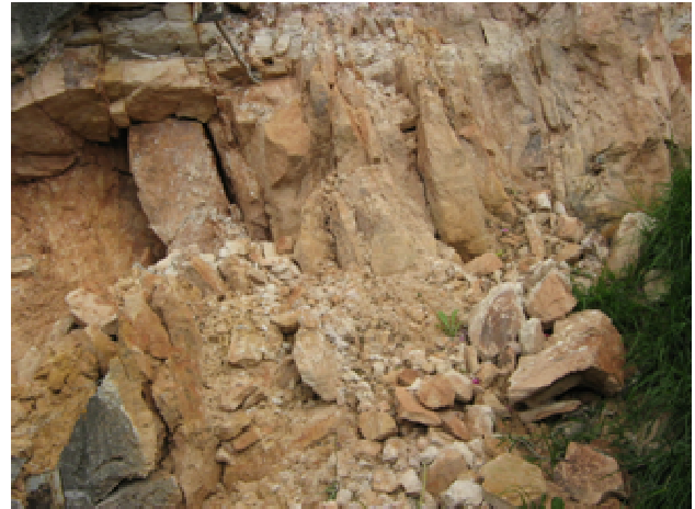
Foto 14. Macizo rocoso de composición arenácea, afectado por dos sistemas de diaclasas, las cuales propiciaron la caída de rocas.
