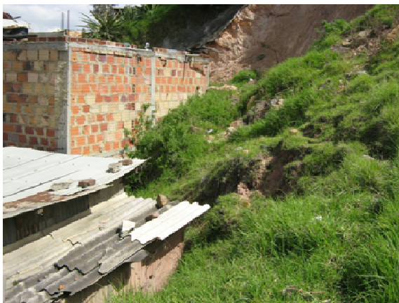
Foto 17. Vivienda ubicada en la parte inferior del deslizamiento.
