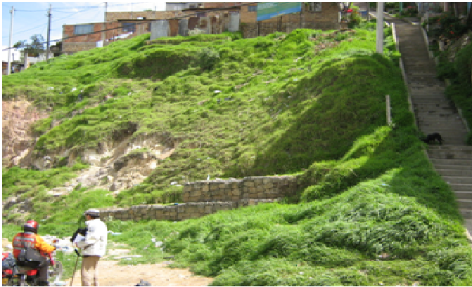
Foto 15. Obsérvese procesos de inestabilidad y erosión de moderada magnitud; en la parte inferior del talud.
