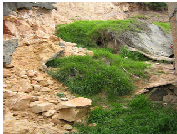
Foto 18. Vivienda ubicada en la parte inferior del deslizamiento.
