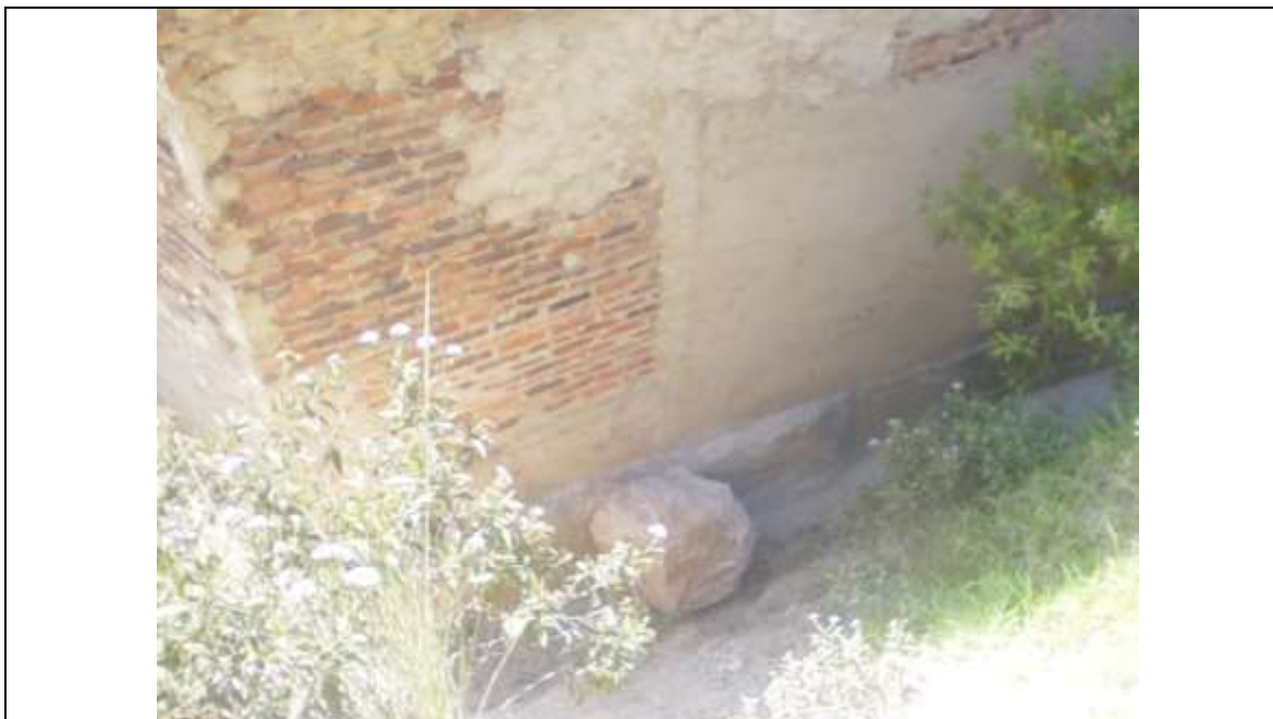
Fotografía 4-2. Bloque de arenisca con volumen aproximado de 0,1 m 3 , observado en el talud de corte de la zona occidental.
