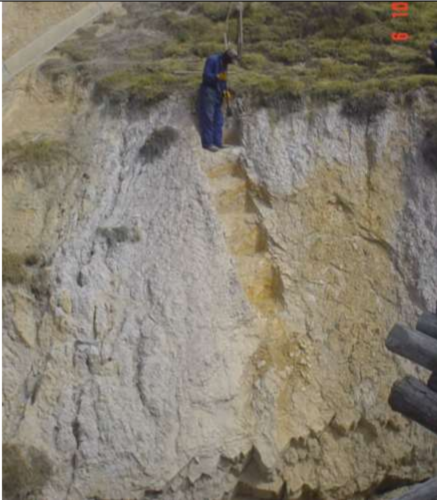
Fotografía 4-3 Arcillolitas poco fisibles, alteradas a suelos residuales arcillosos de plasticidad media a alta, que suprayacen areniscas fracturadas.
