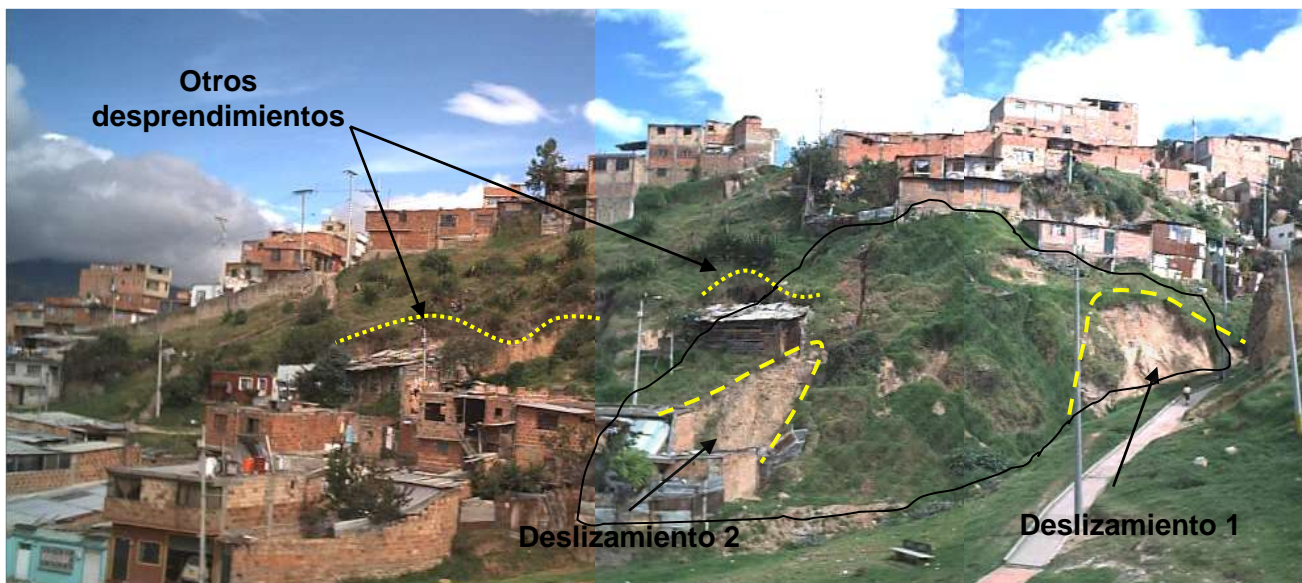
Fotografía 3-6. Panorámica de la zona de estudio. Nótese las formas que evidencian inestabilidad en la ladera adyacente a los deslizamientos 1 y 2 (area achurada) los colores más claros (menor humedad) y la ausencia de formas rugosas en el área ladera arriba de los desprendimientos menores.
