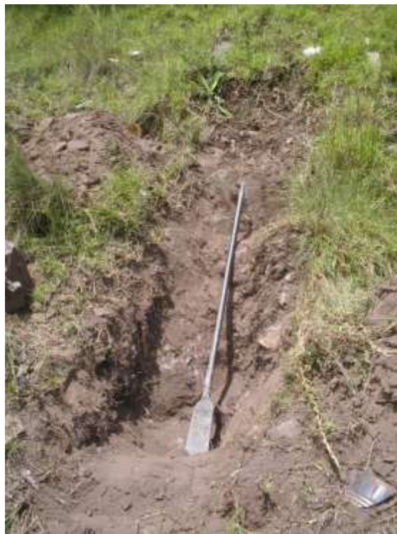
Fotografía 6-3 Ubicación de la trinchera T-3
