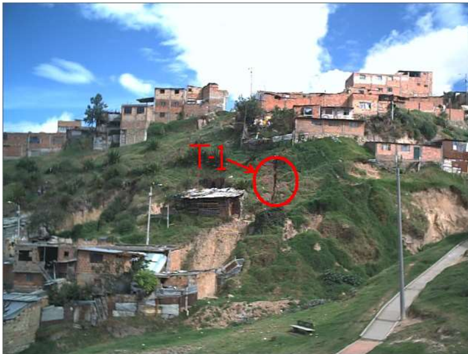
Fotografía 6-1 Ubicación de la trinchera T-1
