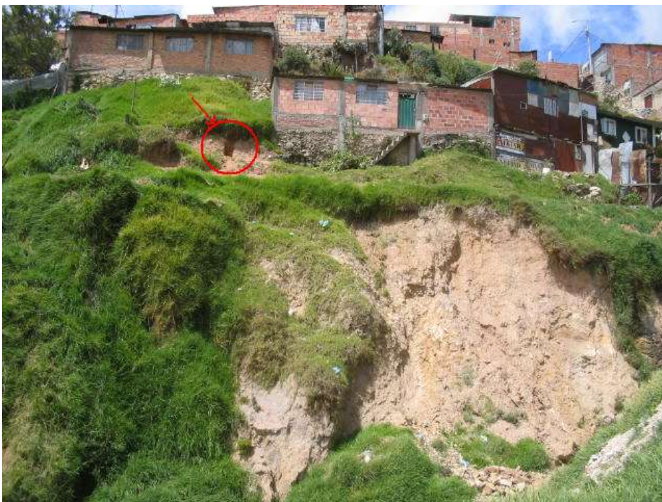
Fotografía 6-5 Ubicación de la trinchera T-5
