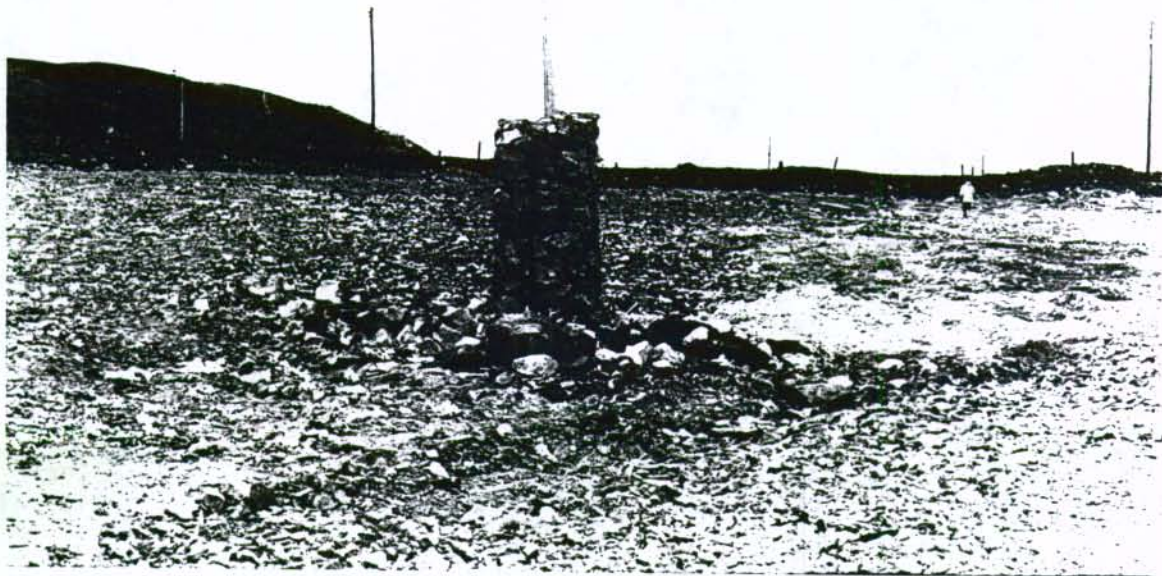
FOTOGRAFÍA 5. CHIMENEA DE EVACUACIÓN DE GASES
