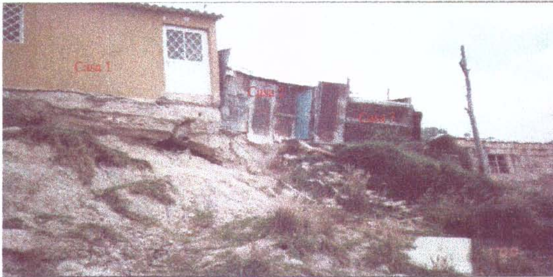
Estado de tres viviendas después del movimiento en masa y acción de los fenómenos erosivos.
