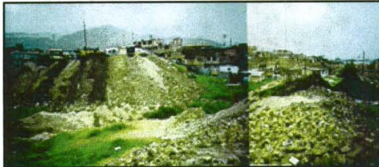
FOTOGRAFIA No. 7.20 UBICACIÓN: Vista aguas abajo de la margen derecha de la quebrada Santa Librada, a la altura del barrio Santa Marta. DESCRIPCION: Se observan los rellenos y los escombros colocados dentro de la ronda de la quebrada.
