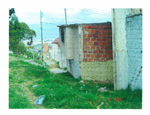
FOTOGRAFIA 3 :Detalle de la casa 3-79 de la Manzana 75, el desplazamiento de la masa inestable quero el aplastamiento de esta casa y otras aledañas. Actualmente todas estas viviendas se encuentran deshabitadas.
