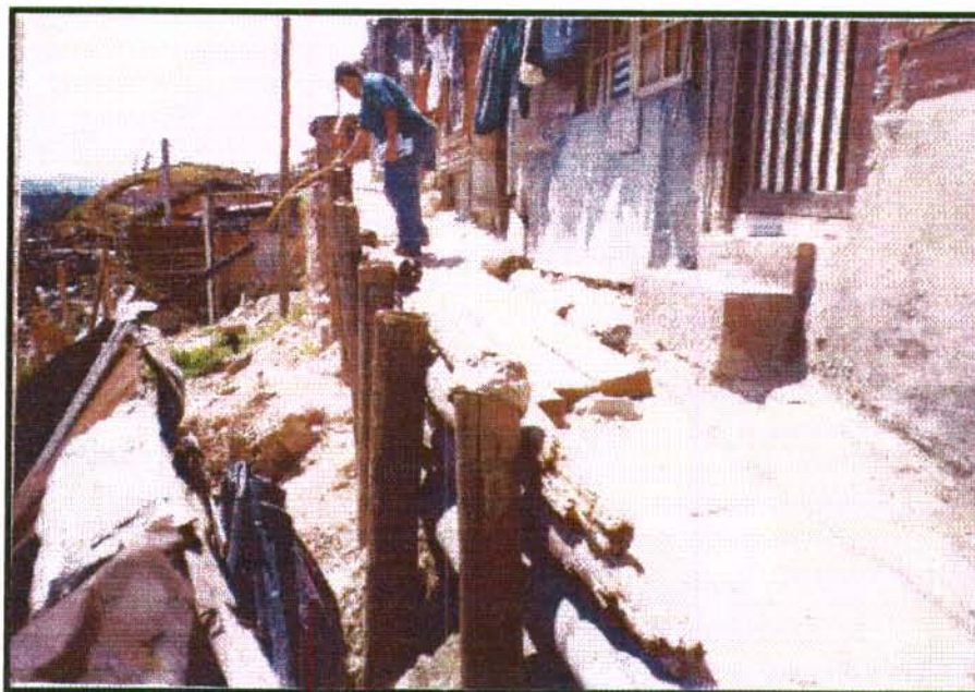
Foto 3-3. 6. Sitio típico donde se recomienda construir estructuras de contención para la adecuación de vías peatonales y protección de las viviendas aledañas.
