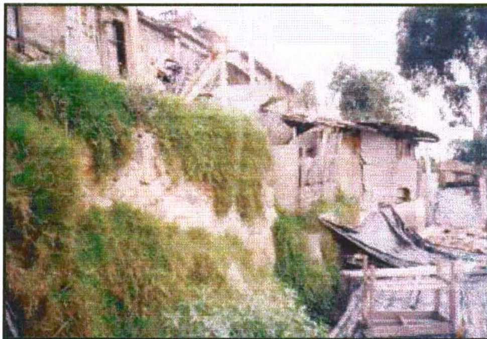
Foto 3-1. 2. Cortes y rellenos característicos realizados en la parte alta de la zona de estudio para la construcción de viviendas
