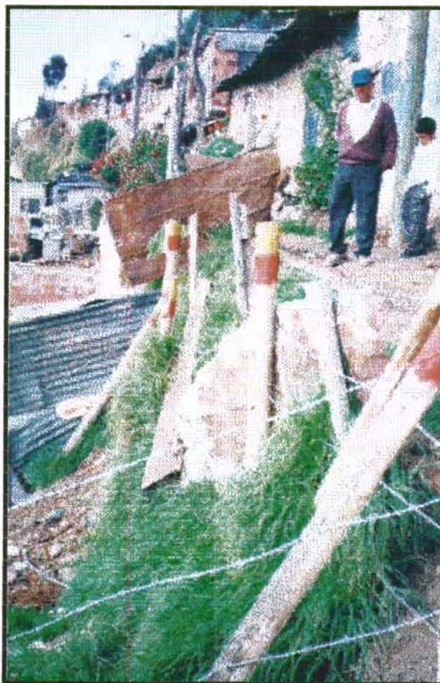
Foto 3-4. 2. “Estructura” típica para contener los rellenos y cortes para la construcción de vías y viviendas en la parte alta del área de estudio.
