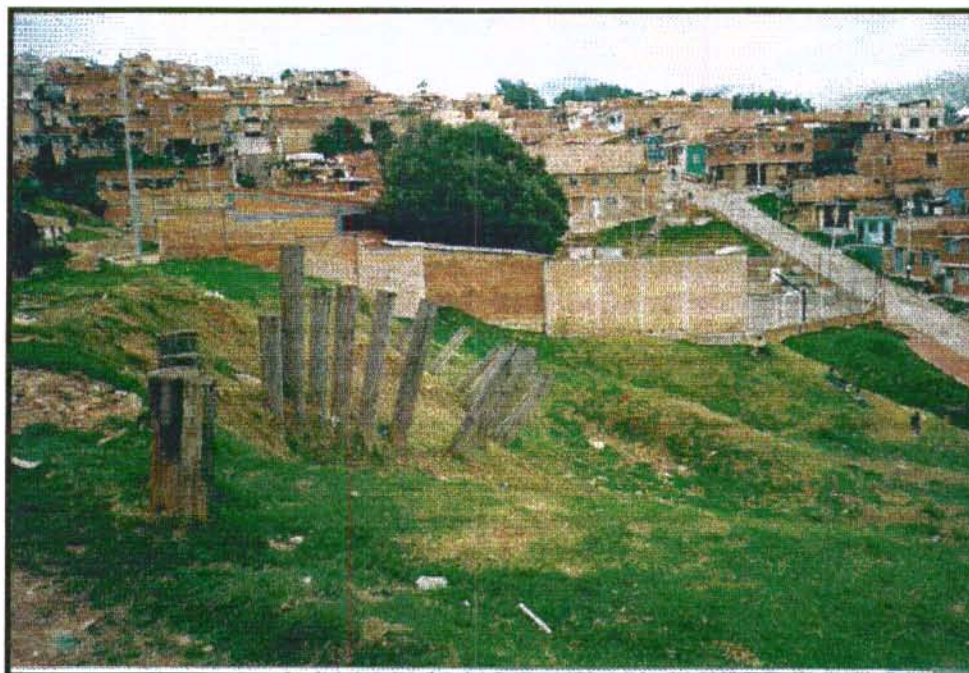
Foto 3-1. 3. Sector de reptación del relleno localizado en la parte media de la zona de estudio.
