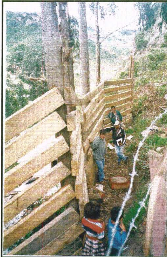
Foto 3-2. 1. Barreras construidas por la comunidad para disminuir la distancia de viaje de los bloques
