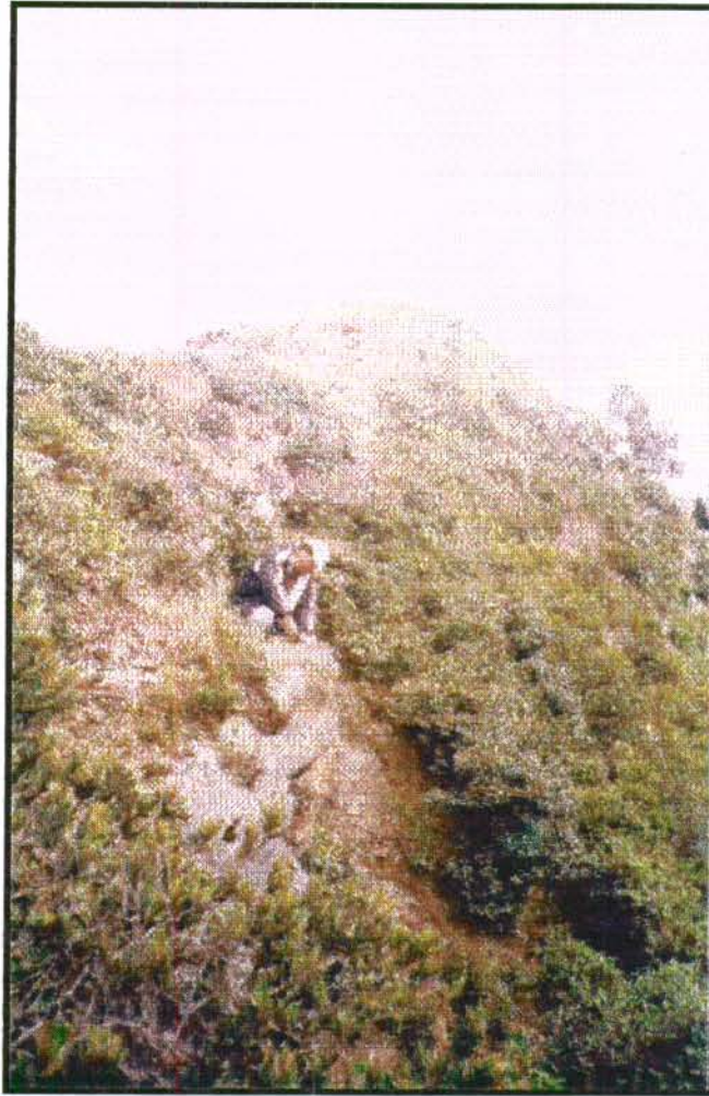
Foto 3-3. 1. Escarpe rocoso en la zona de estudio donde pueden presentarse desprendimientos o caídas de bloques.
