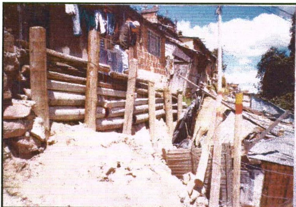
Foto 3-5. 4. Conformación de terrazas para la construcción de viviendas.
