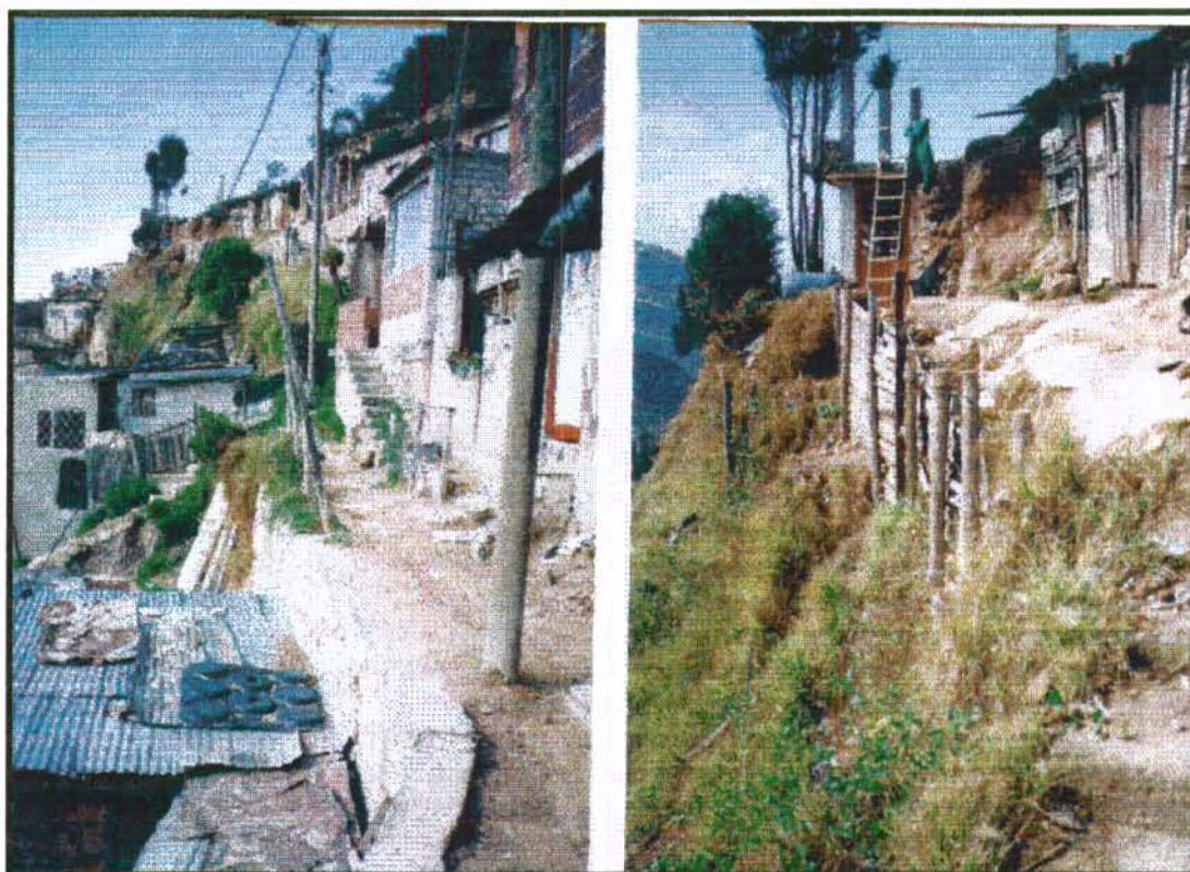
Foto 3-1. 6. Muro de confinamiento de rellenos y/o cortes realizados en la parte alta de estudio para conformación de caminos peatonales (derecha). Estado actual de mucho de los rellenos o cortes en la parte alta de la zona de estudio (izquierda).
