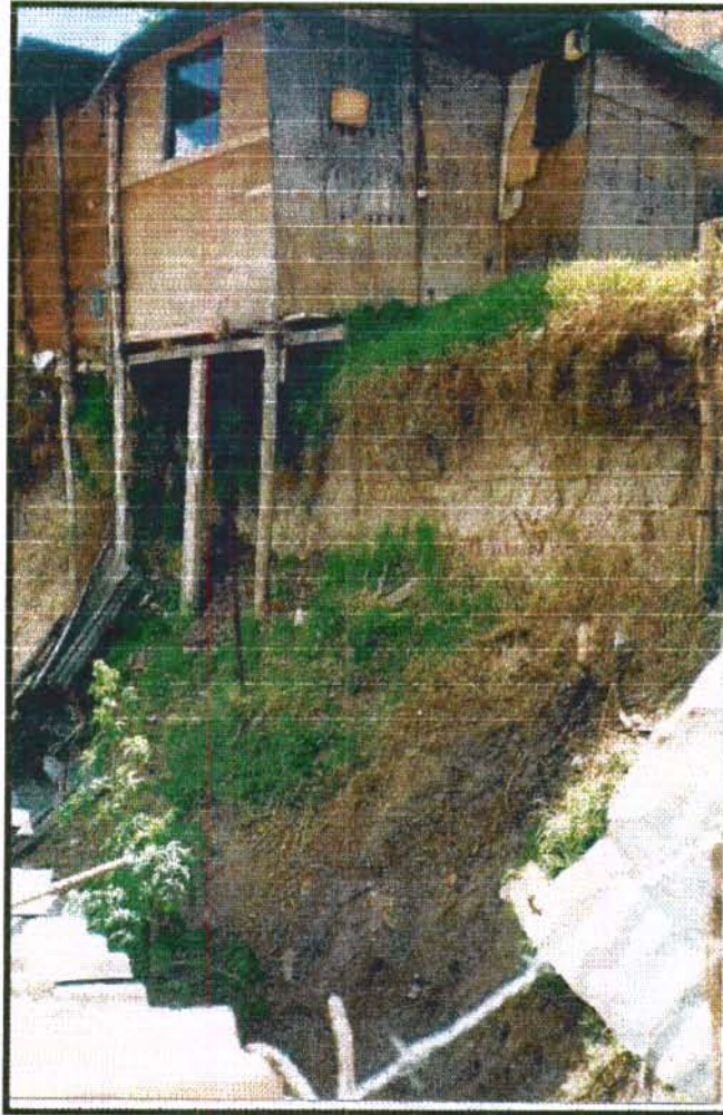
Foto 3-5. 3. Vivienda de alta vulnerabilidad.
