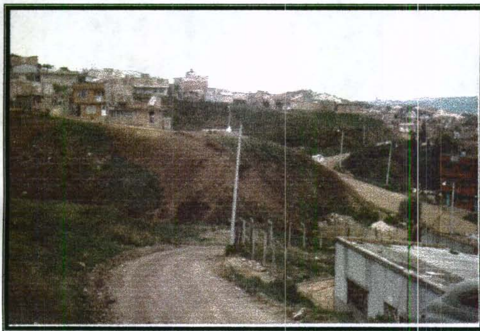
Foto No. 4. 6 Rellenos con materiales producto del corte de las vías del barrio.
