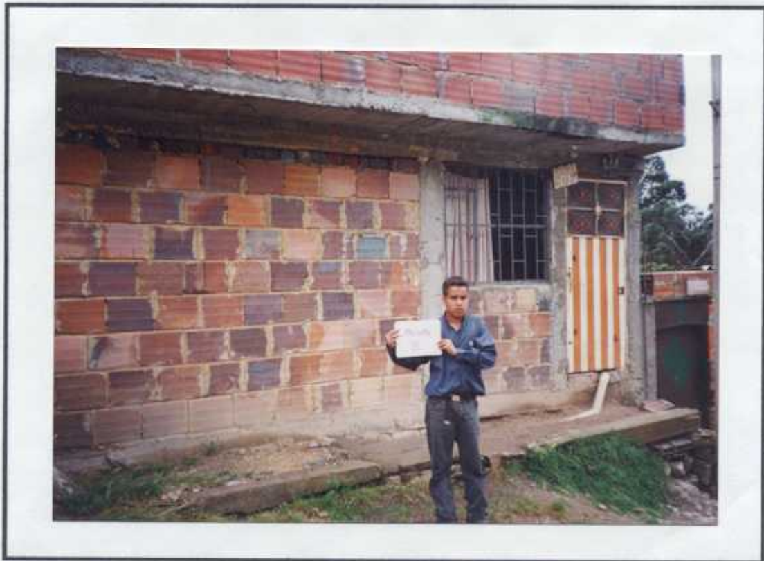
FOTOGRAFIA No14 CONTROL ESTRUCTURAL A VIVIENDAS CASA No 8 Sector Manila (Zona Activa)
