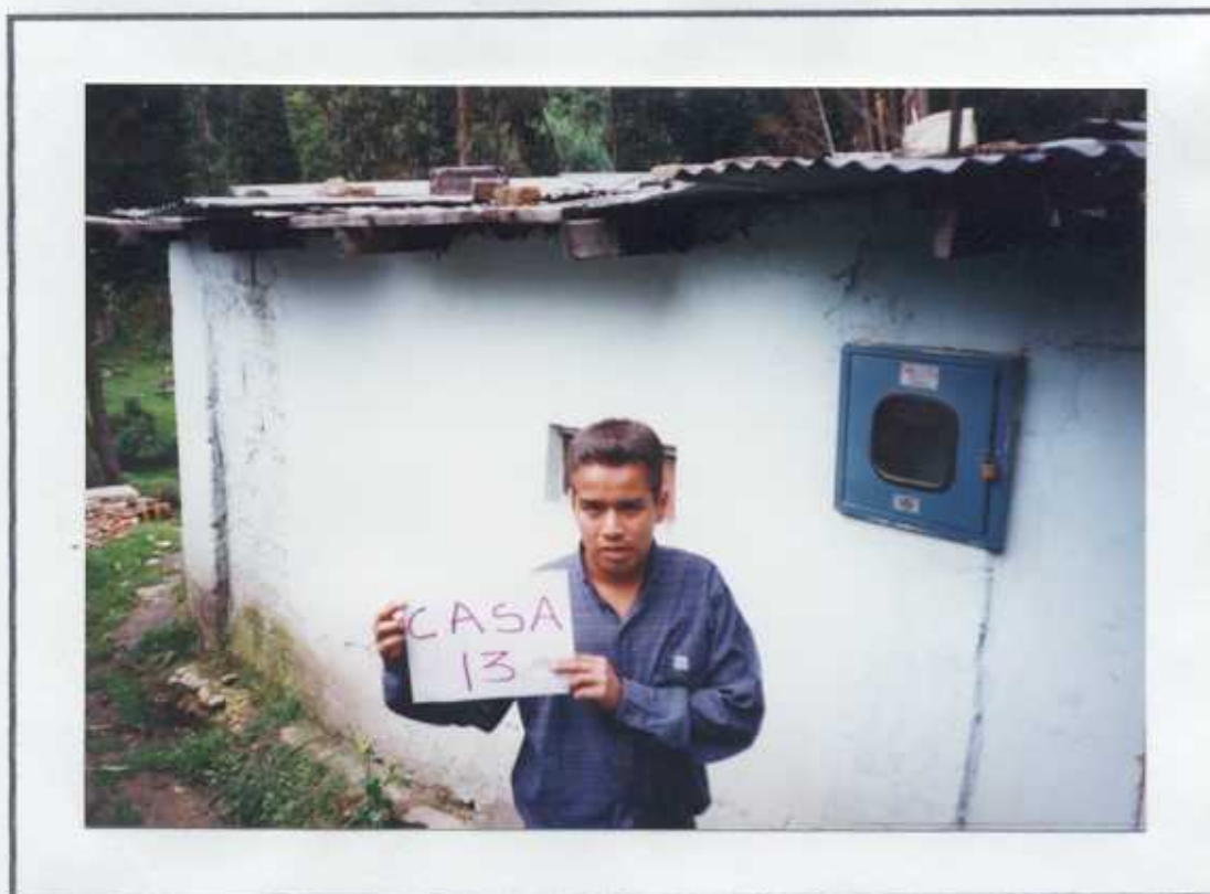
FOTOGRAFIA No 19 CONTROL ESTRUCTURAL A VIVIENDAS CASA No 13 Sector Gran - Colombia
