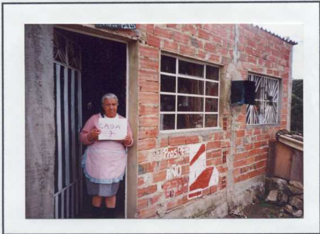
FOTOGRAFIA No13 CONTROL ESTRUCTURAL A VIVIENDAS CASA No 7 Sector Manila (Zona Activa)
