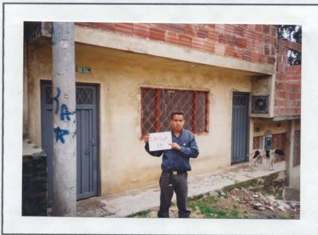
FOTOGRAFIA No 21 CONTROL ESTRUCTURAL A VIVIENDAS CASA No 15 Sector Manila (Zona Activa).
