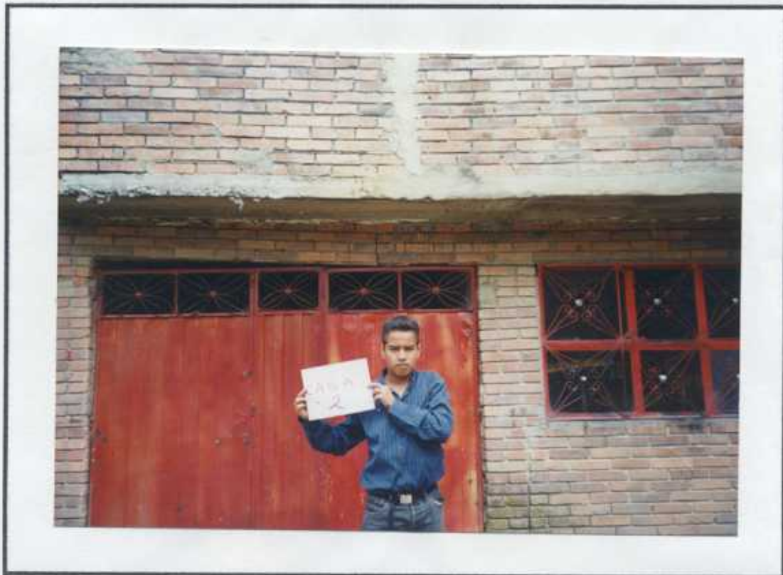
FOTOGRAFIA No 7 CONTROL ESTRUCTURAL A VIVIENDAS CASA No 2 Sector Gran Colombia
