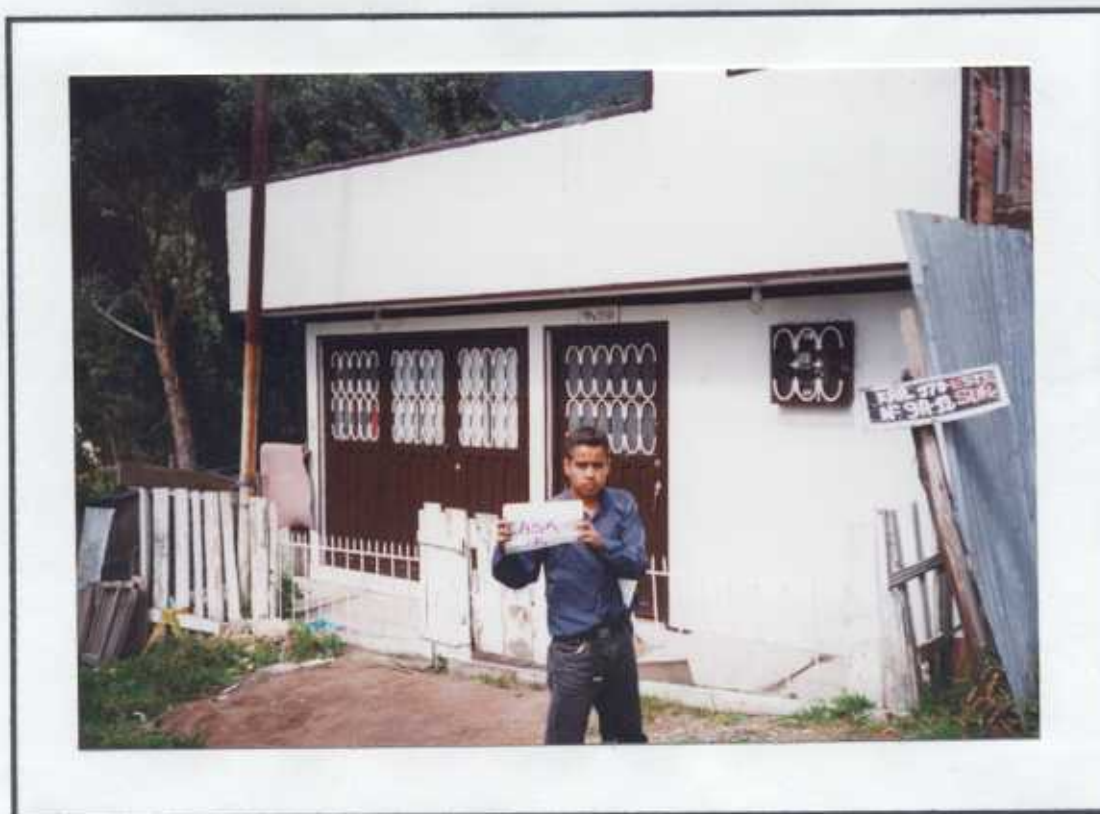
FOTOGRAFIA No10 CONTROL ESTRUCTURAL A VIVIENDAS CASA No 5 Sector Manila (Zona Activa)
