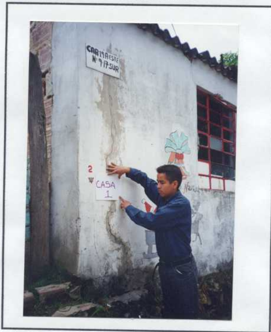
FOTOGRAFIA No 6. CONTROL ESTRUCTURAL A VIVIENDAS CASA No1 Sector Gran Colombia
