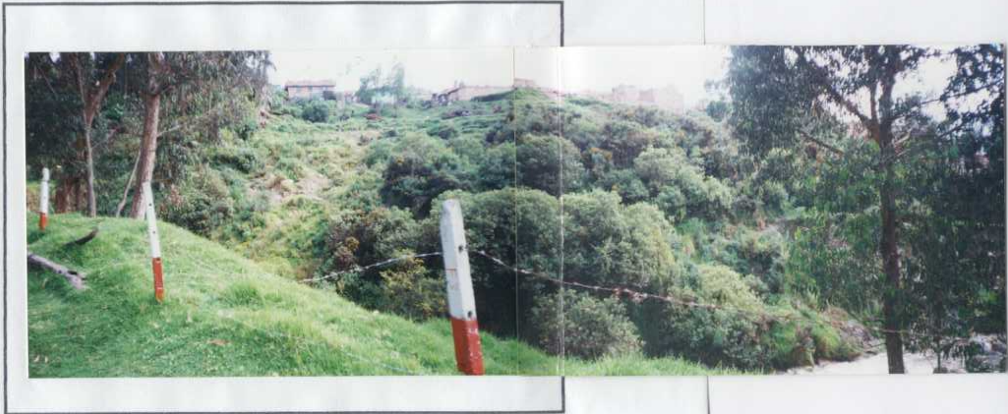
FOTOGRAFIA No 24 REGISTRO FOTOGRAFICO DE LOS TALUDES CONTROLADOS, COMO SECUENCIA DE AGUAS ARRIBA HACIA AGUAS ABAJO. DESDE EL PUNTO FOTOGRAFICO F3
