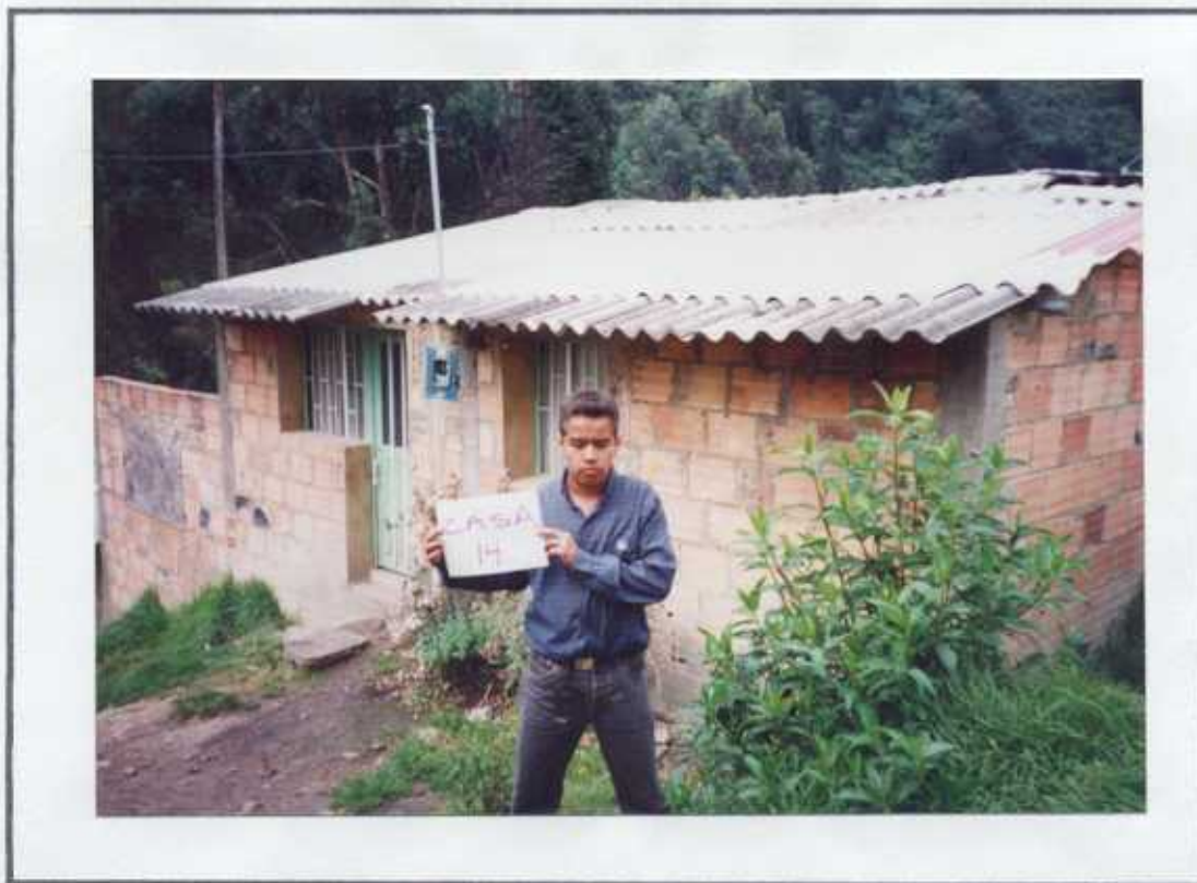
FOTOGRAFIA No 20 CONTROL ESTRUCTURAL A VIVIENDAS CASA No 14 Sector Gran - Colombia
