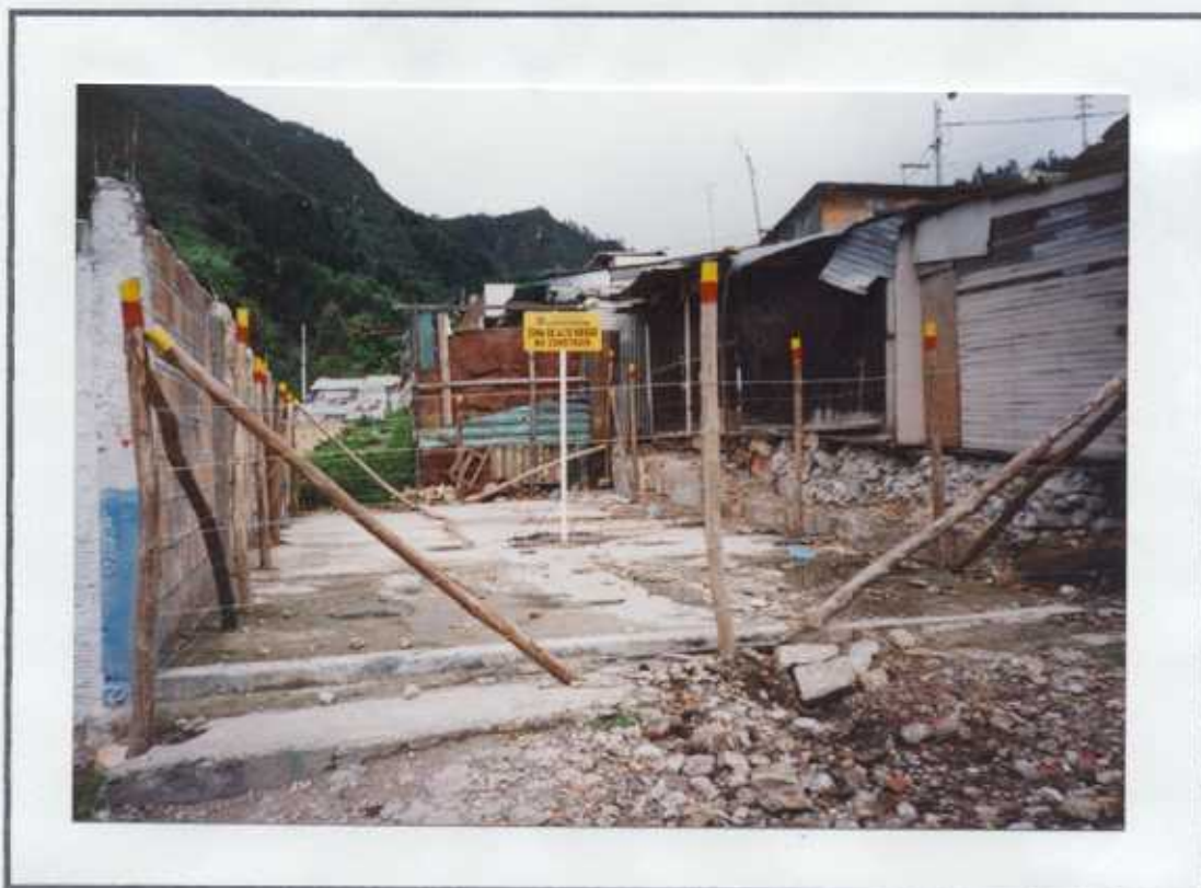
FOTOGRAFIA No 16 CONTROL ESTRUCTURAL A VIVIENDAS CASA No 10 Sector Manila (Zona Activa) Esta vivienda fue demolida durante el periodo de instrumentación
