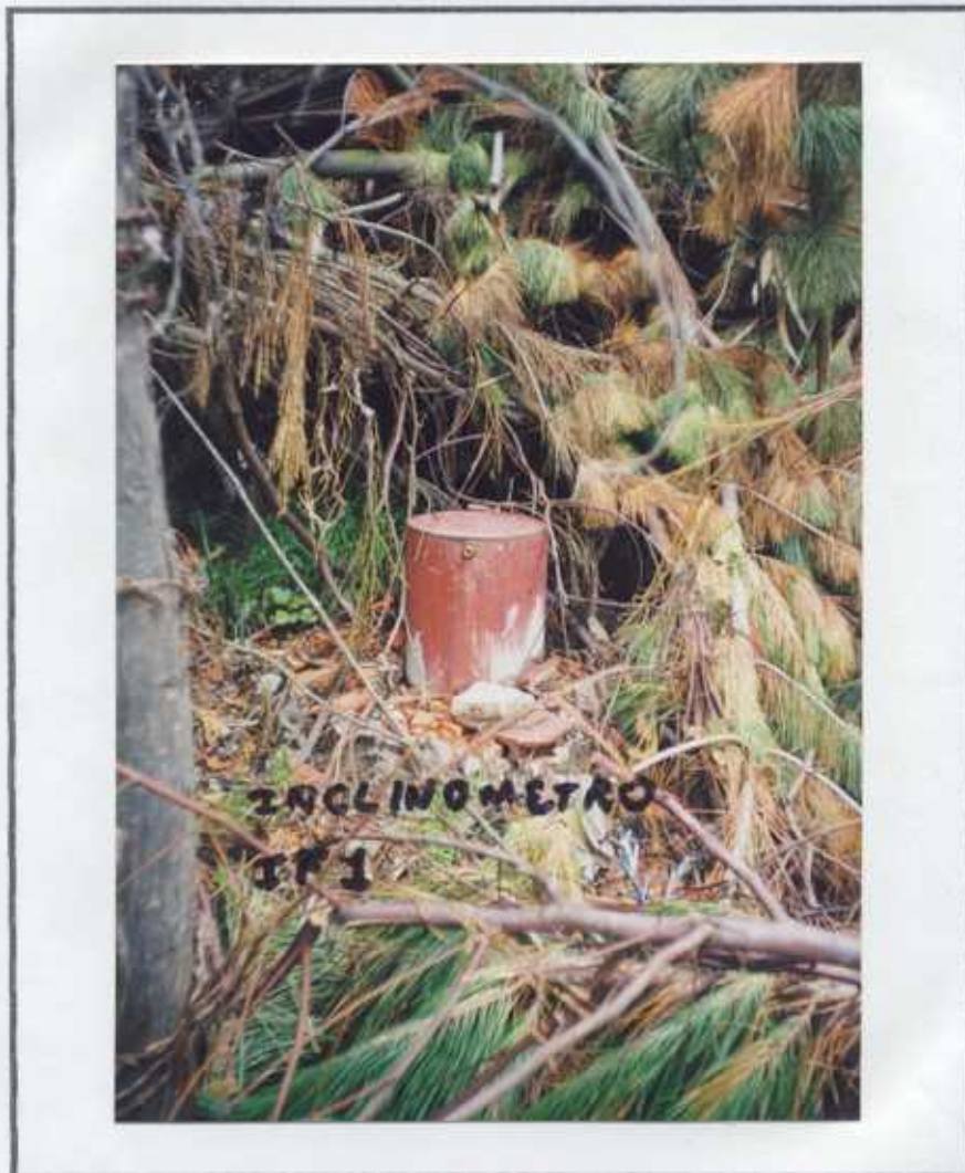
FOTOGRAFIA No 1. INCLINOMETRO IF1. INSTRUMENTO EN BUEN ESTADO FUNCIONAL
