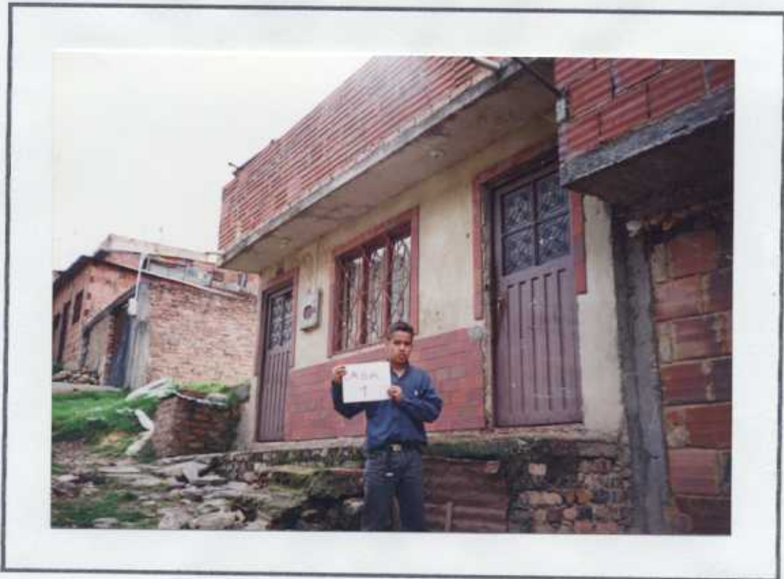
FOTOGRAFIA No15 CONTROL ESTRUCTURAL A VIVIENDAS CASA No 9 Sector Manila (Zona Activa)
