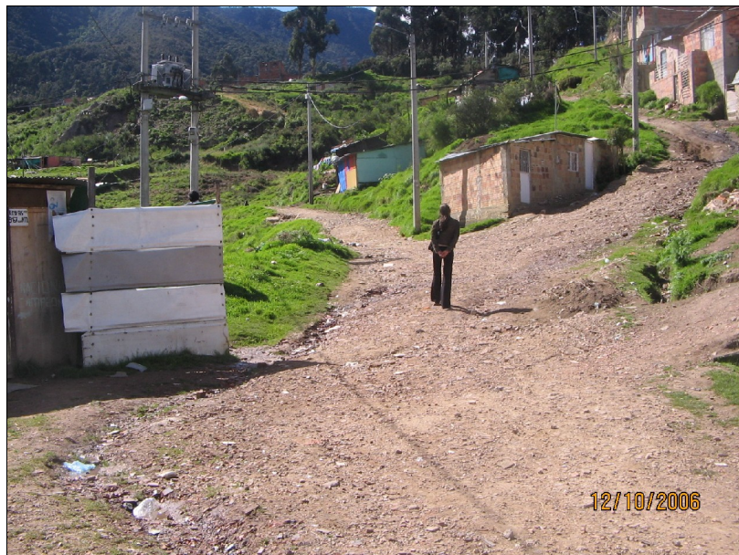
Fotografía No. 14 – Otro aspecto del Terreno a lo largo de la calle localizada por encima del Talud inestable en la zona arriba de la fotografía anterior.
