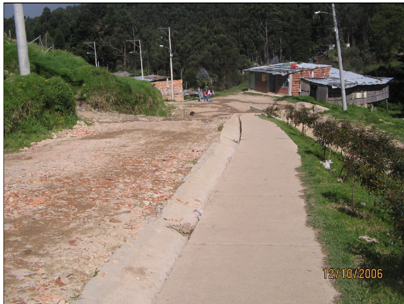
Fotografía No. 18 – Panorámica de la vía de acceso y el sistema cuneta-andén construido para la estabilización del talud con el muro de contención existente
