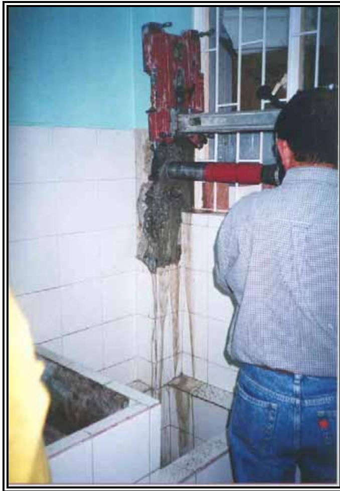
Toma de muestra de núcleo en columna No. 3.
