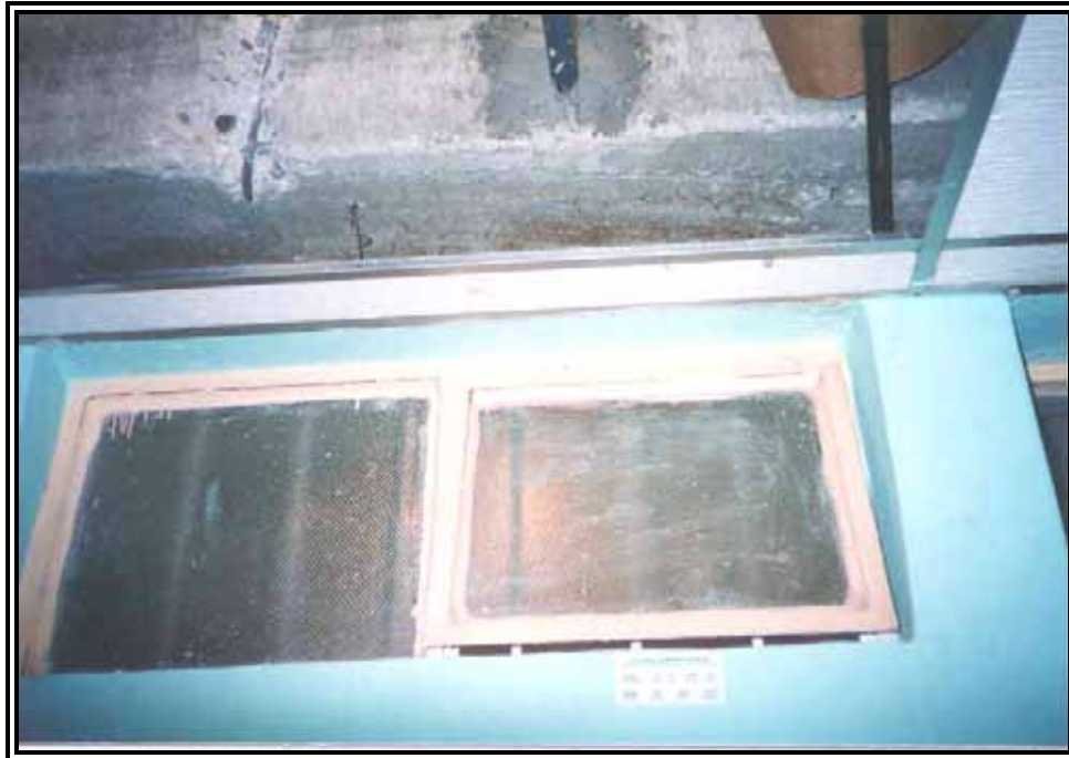
Exploración de hierro en vigas.
