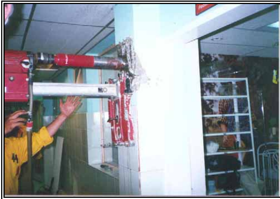
Toma de muestra de núcleo en columna No.1
