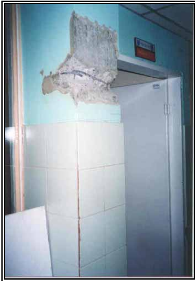
Exploración de refuerzo en columnas.
