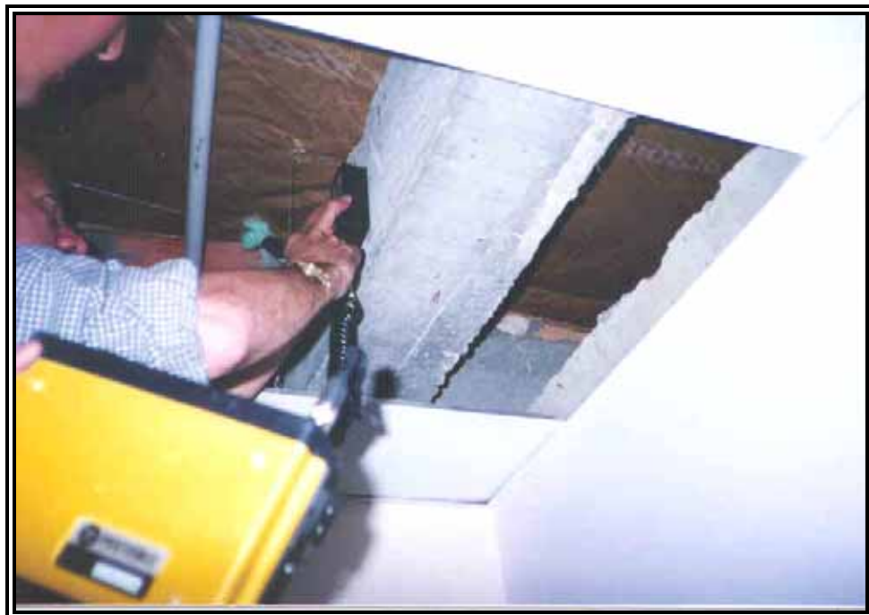
Identificación de hierros en vigas.
