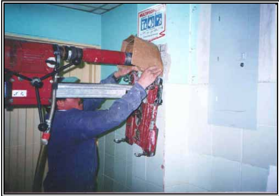
Toma de muestra de núcleo en columna No.2.
