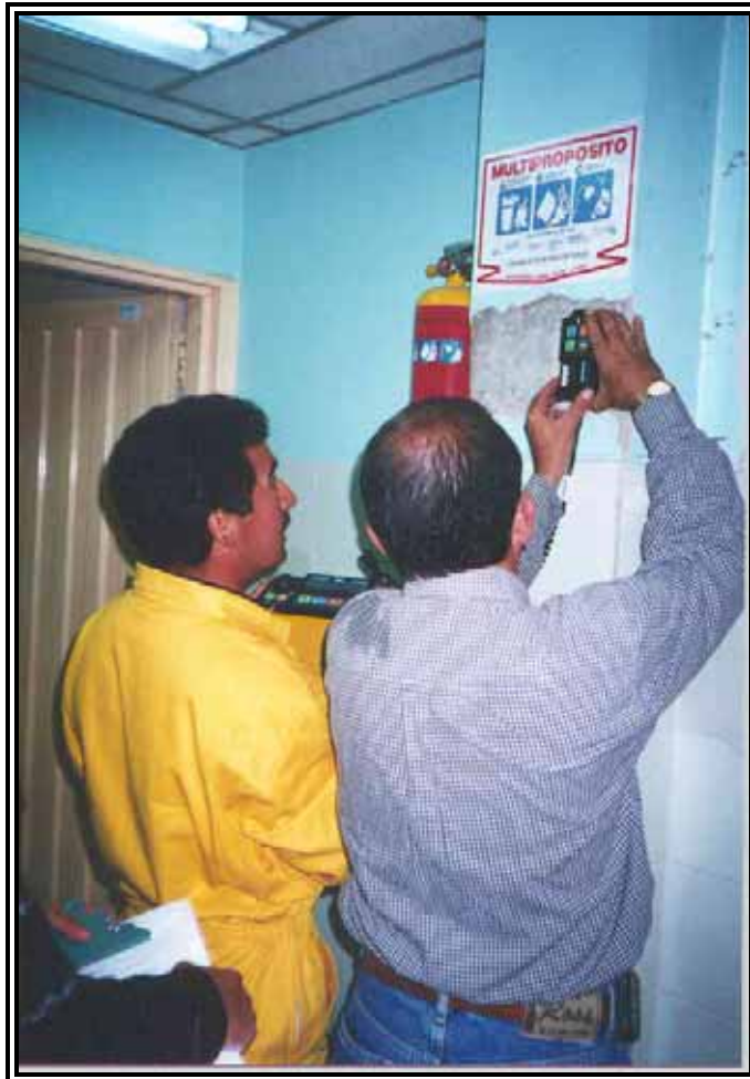
Identificación de hierros en columnas.
