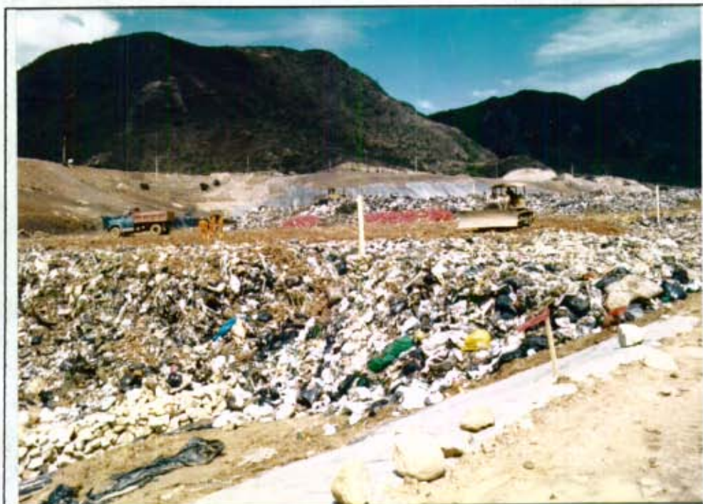
Fotografía # 13: Vista hacia el costado Nor-occidental. Se observa disposición de basura en los niveles 1 y 2, manteniéndose descubierto el nivel inferior y sin disgregar residuos patógenos (bolsas rojas) en el nivel superior. (DJ#1 - 27A-28)
