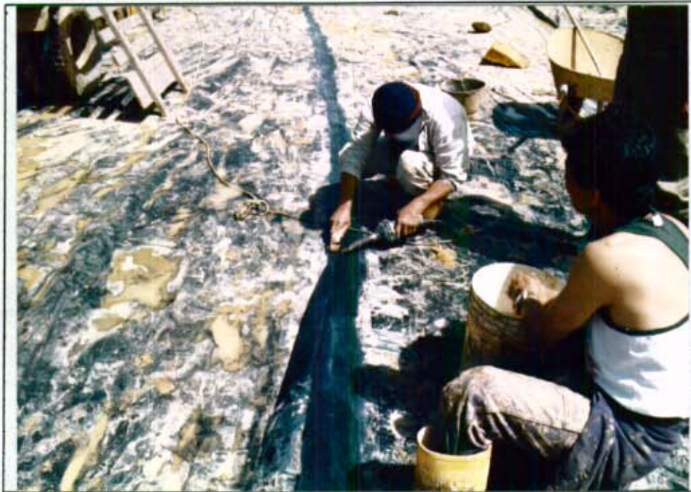
Fotografía # 7: Detalle que muestra el termosellado de la geomembrana, dispuesta incorrectamente en franjas extendidas en sentido longitudinal al avance de la disposición de basuras. (DJ#1 - 24A-25)
