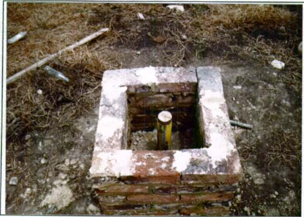
Fotografía # 19: cabezote preliminar de protección de los inclinómetros instalados. (DJ#3 - 16A-17)
