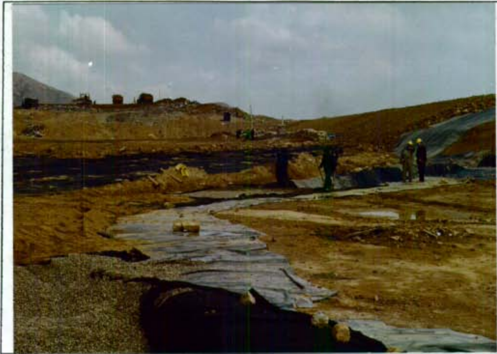
Fotografía # 9: Vista general que muestra la secuencia general del sistema de impermeabilización así : Preparación de la superficie con motoniveladora y compactador; colocación de la geomembrana, colocación de capa de arena, colocación de geotextil y colocación de capa de protección. (DJ#7 - 25A-26)
