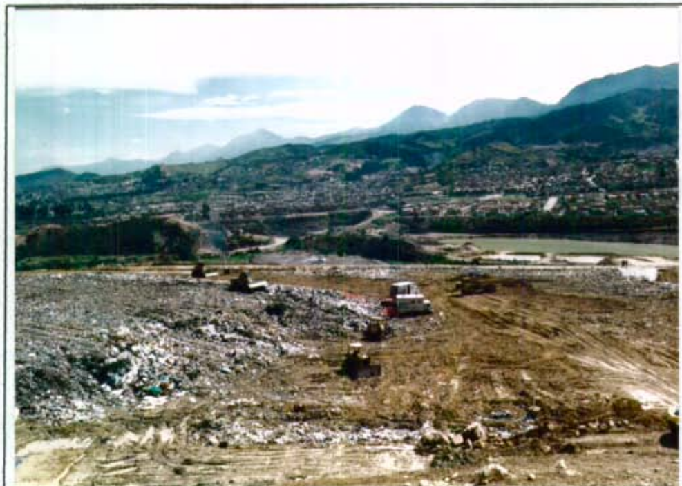
Fotografía # 11: Se observa la disposición en el nivel 2, con escasa zona de disgregación, la cual además se ejecuta de arriba hacia abajo. Nótese la gran área de basuras descubiertas. (DJ#1 - 12A-13)
