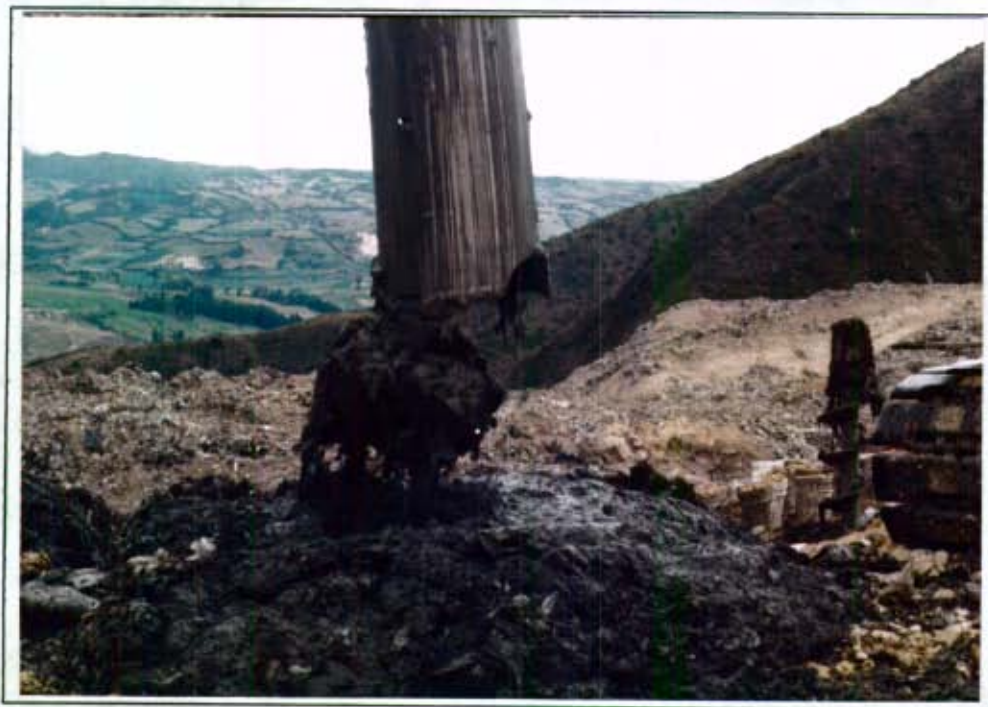
Fotografía # 27: Recuperación de basura durante la perforación de huecos de 80 cm. Nótese el contenido de materia orgánica en estado fresco, aún después de haber permanecido por espacio de 2 años dispuesta. (DJ#6 -24-24A)
