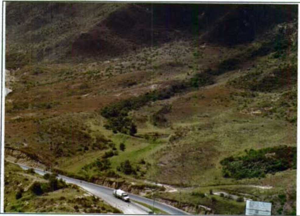
Fotografía # 31: Vista panorámica que muestra la ubicación de la zona VI o de emergencia, que no esta construida y que está prevista en el contrato de la Concesión. (DJ#7 -7A-8)
