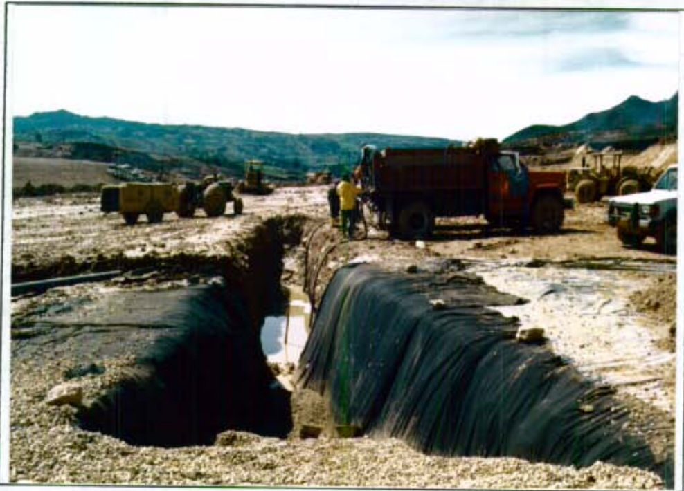
Fotografía # 1: Avance en la construcción de filtros principales. Nótese la geometría irregular de la zanja, el deficiente manejo de agua de escorrentía y la ausencia de las dos capas de arcilla por debajo de la geomembrana. (DJ#1 - 16A-17)
