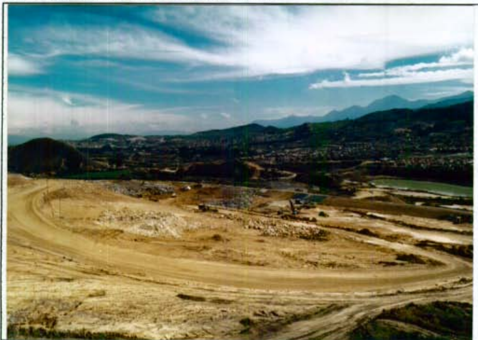
Fotografía # 9: Vista general que muestra la secuencia general del sistema de impermeabilización así : Preparación de la superficie con motoniveladora y compactador; colocación de la geomembrana, colocación de capa de arena, colocación de geotextil y colocación de capa de protección. (DJ#7 - 25A-26)
