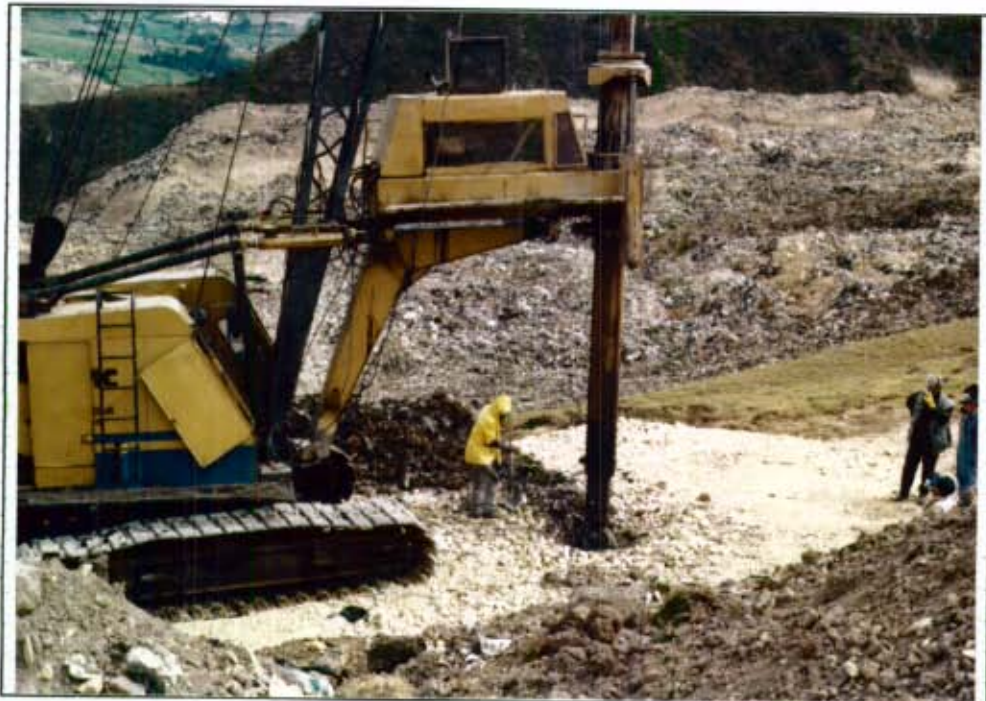
Fotografía # 26: Perforación de huecos de 80 cm de diámetro y profundidad variable de 6m a 22 m de profundidad para aliviar la presión de poros detectado en los aparatos instalados en estas zonas. (DJ#6 -17-17A)
