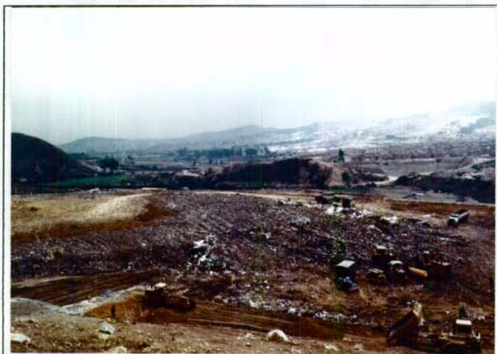
Fotografía # 13: Vista hacia el costado Nor-occidental. Se observa disposición de basura en los niveles 1 y 2, manteniéndose descubierto el nivel inferior y sin disgregar residuos patógenos (bolsas rojas) en el nivel superior. (DJ#1 - 27A-28)
