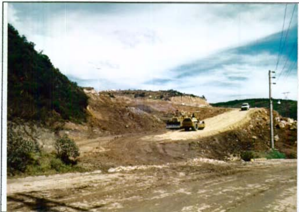
Fotografía # 29: Readecuación de vía para el acceso a la zona I, zona II y Mansión. (DJ#1-1A-2)
