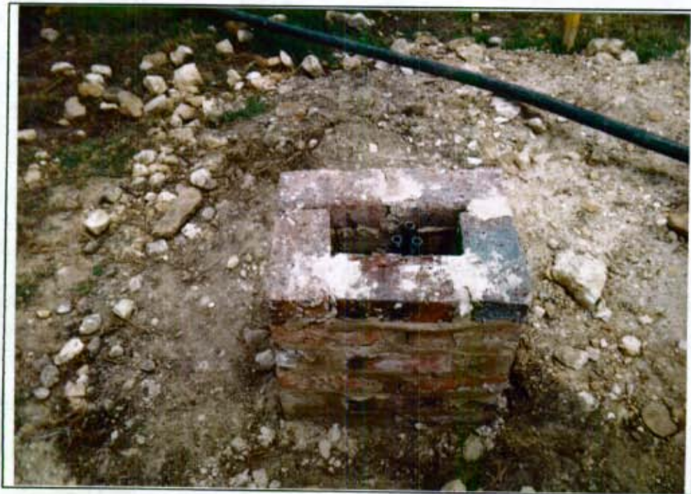
Fotografía # 20: Cabezote preliminar de protección de los piezómetros de Casagrande instalados. (DJ#3 - 17A-18)
