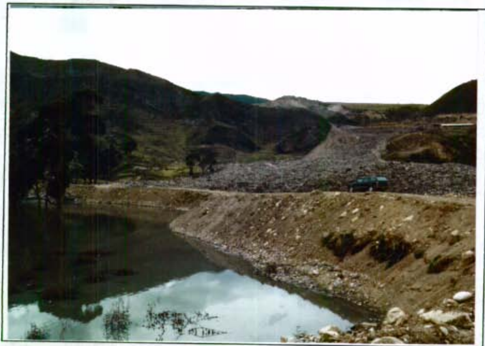
Fotografía # 36: Construcción de dique de protección que aisló las basuras provenientes del derrumbe. (DJ#4 - 22A-23)
