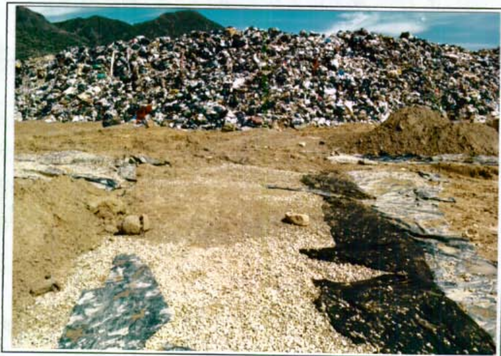
Fotografía # 1: Avance en la construcción de filtros principales. Nótese la geometría irregular de la zanja, el deficiente manejo de agua de escorrentía y la ausencia de las dos capas de arcilla por debajo de la geomembrana. (DJ#1 - 16A-17)
