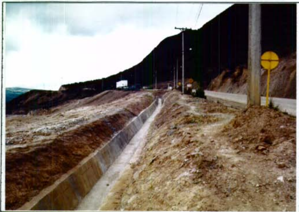
Fotografía # 5: Construcción de canal trapezoidal revestido en concreto, localizado en la parte superior de la vía de Acceso al Campamento. (DJ#2 - 1-1A)
