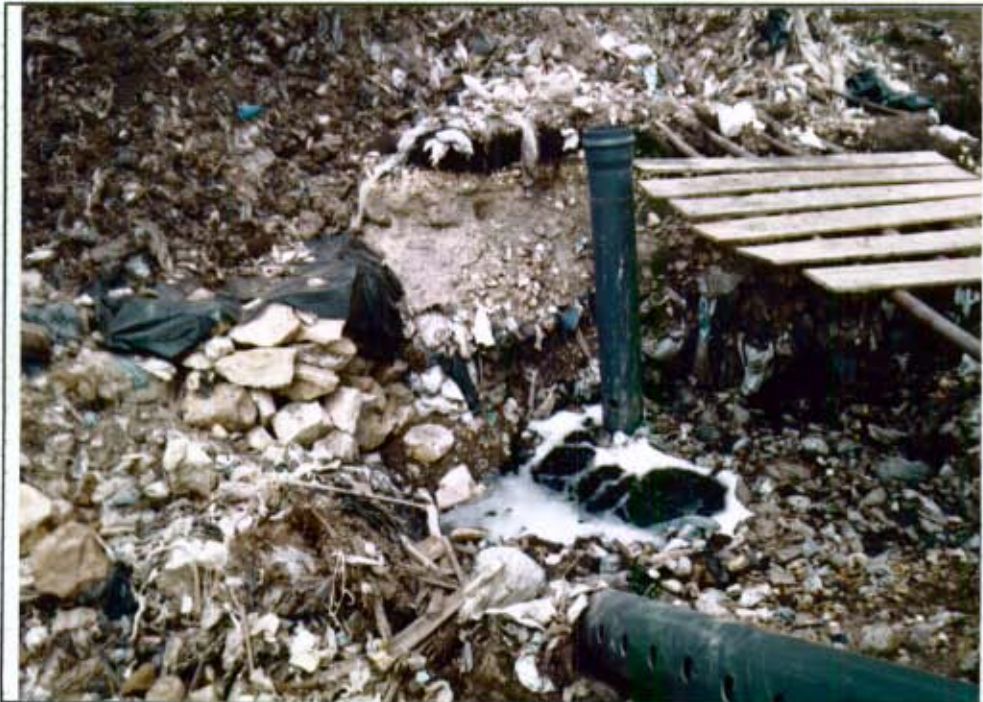
Fotografía # 23: Pozos excavados durante los estudios de aprovechamiento del bio-gas y por donde brota lixiviado con presencia de gas. (DJ#3 - 14A-15)
