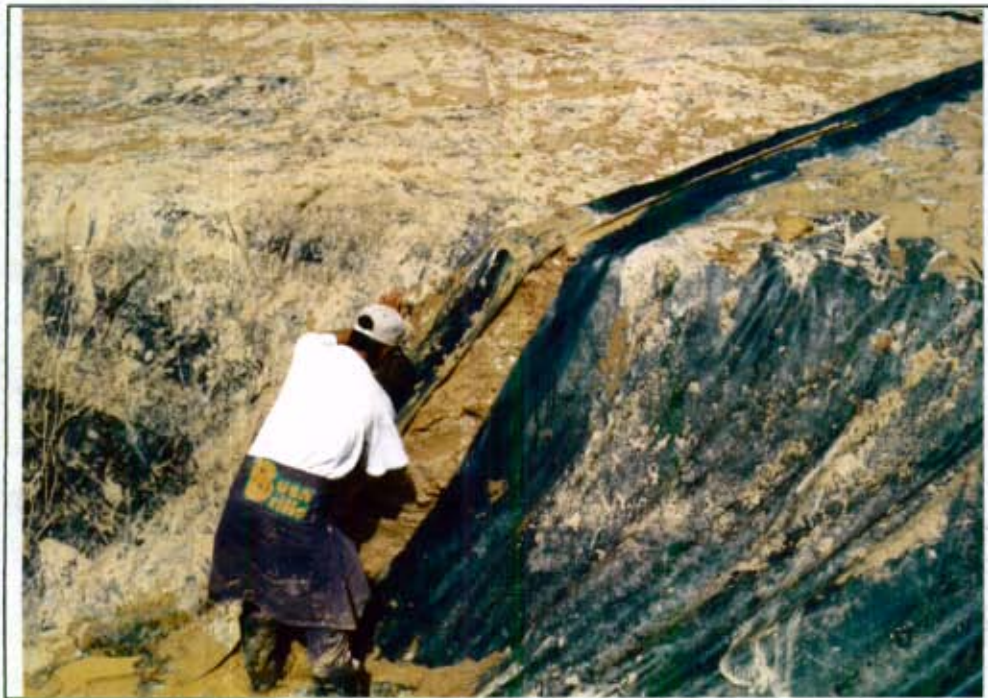
Fotografía # 7: Detalle que muestra el termosellado de la geomembrana, dispuesta incorrectamente en franjas extendidas en sentido longitudinal al avance de la disposición de basuras. (DJ#1 - 24A-25)
