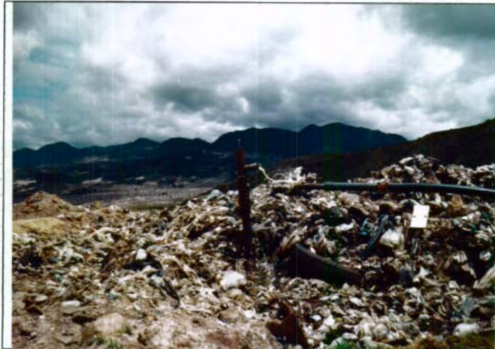
Fotografía # 22: Presencia de lixiviado expulsado a presión, por tubería de infiltración utilizada en el sistema de recirculación puesta en operación antes de la ocurrencia del deslizamiento de basuras el 27 de septiembre de 1997. (DJ#3 - 2A-3)
