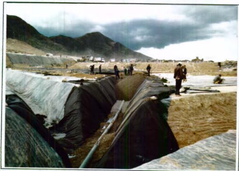
Fotografía # 3: Construcción de filtro principal obstaculizado por la presencia del bloque de arenisca. Se observan los preparativos para su demolición empleando pólvora negra. El frente de disposición de basuras se extiende por todo el ancho de la zona. (DJ#3 - 22A-23)
