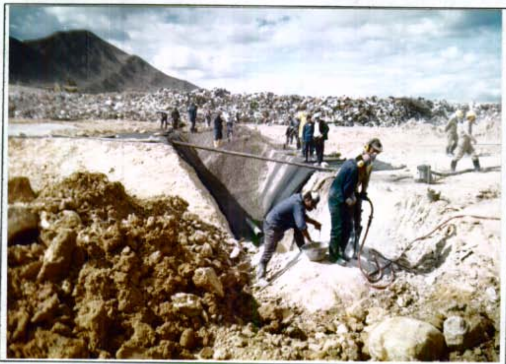
Fotografía # 3: Construcción de filtro principal obstaculizado por la presencia del bloque de arenisca. Se observan los preparativos para su demolición empleando pólvora negra. El frente de disposición de basuras se extiende por todo el ancho de la zona. (DJ#3 - 22A-23)
