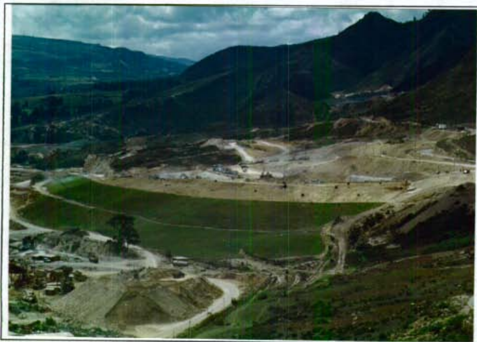
Fotografía # 18: Vista panorámica hacia el Sur-occidente de la zona. Se observan tres franjas: La primera empedrada para la protección de la pata del talud natural. La segunda empedrada y corresponde al dique de contención de la pata del relleno, que aloja el nivel 1 del relleno, y la tercera corresponde al dique de protección de los demás niveles conformados. (DJ#7 - 6A-7)
