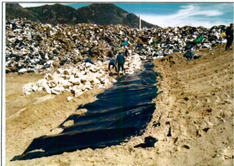
Fotografía # 12: Construcción de filtro perimetral en piedra rajón muy próxima al frente de colocación de basuras que se encuentra descubierto. (DJ#1 - 22A-23)
