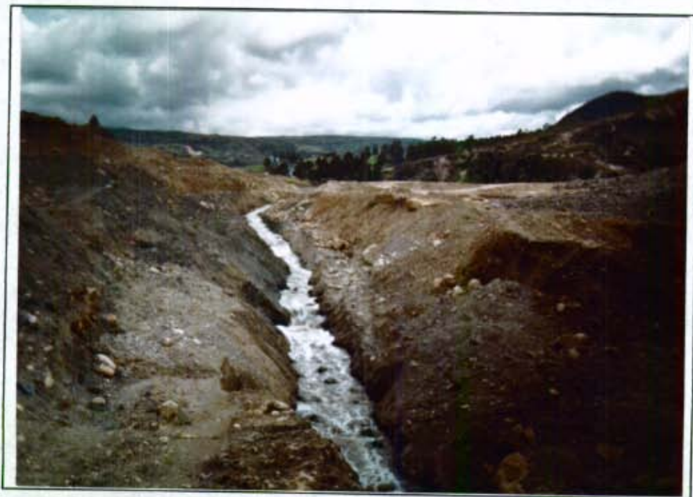
Fotografía # 38: Vista general hacia aguas arriba del canal de desvío en tierra del Río Tunjuelito. (DJ#4 - 10A-11)
