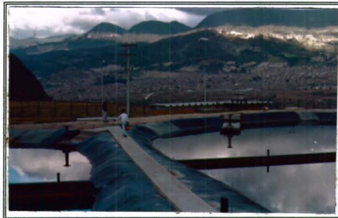
FOTO No. 5 Piscinas de Tratamiento de Lixiviados área más antigua del Relleno
