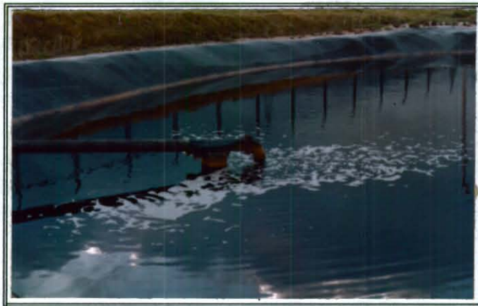
FOTO No. 6 Piscinas de Tratamiento de Lixiviados área más antigua del Relleno
