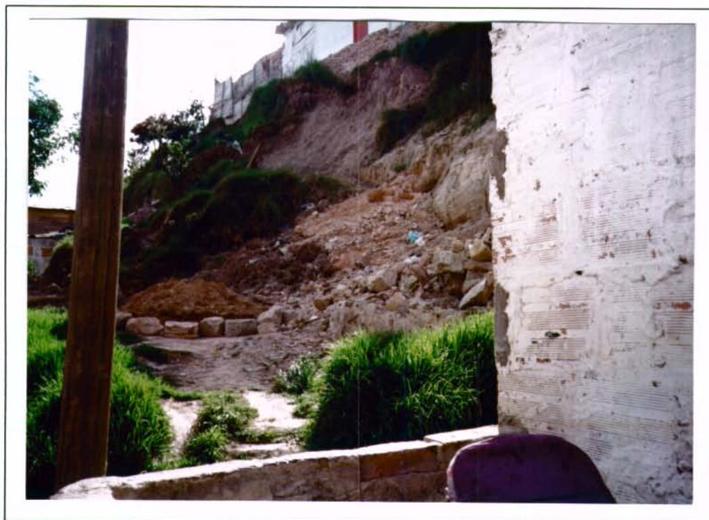
Foto No. 21. Barrio Malvinas - San Martín de Porres: Viviendas reubicadas por deslizamiento en el talud posterior de las viviendas.
