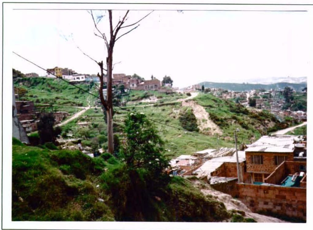
Foto No. 10: Barrio Ramajal. Deslizamiento en un relleno sobre una de las laderas del Barrio Ramajal.
