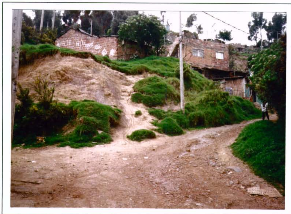
Foto No. 4: Barrio Triángulo. Erosión y Deslizamiento en la vía de Acceso principal al barrio Corinto.
