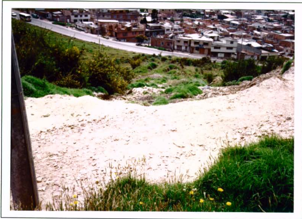
Foto No. 12. Barrio Nueva España. Zona deslizada sobre la Calle 38 Sur con Carrera 12 G.
