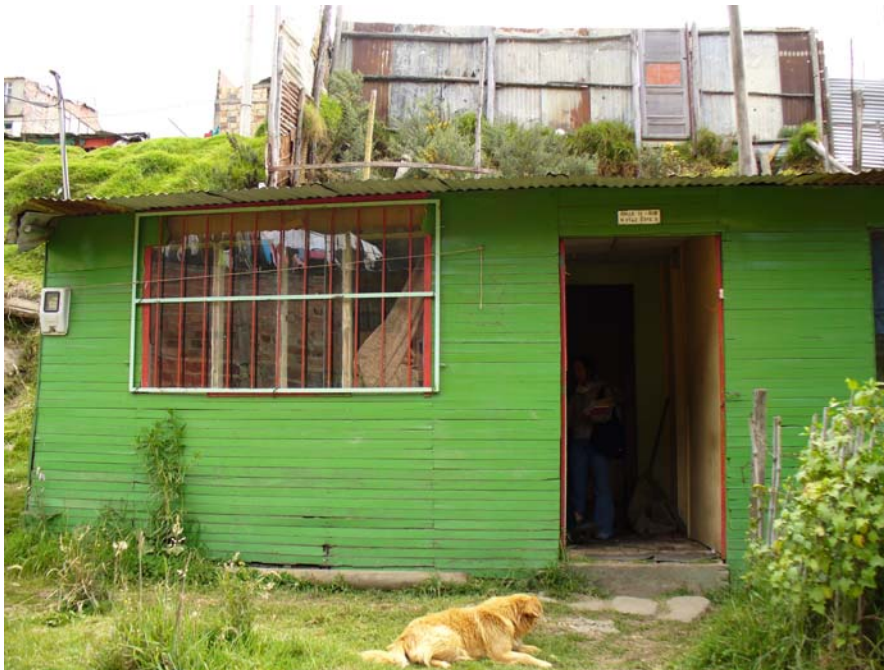
Fotografía 8 - 7. Estructura en madera.
