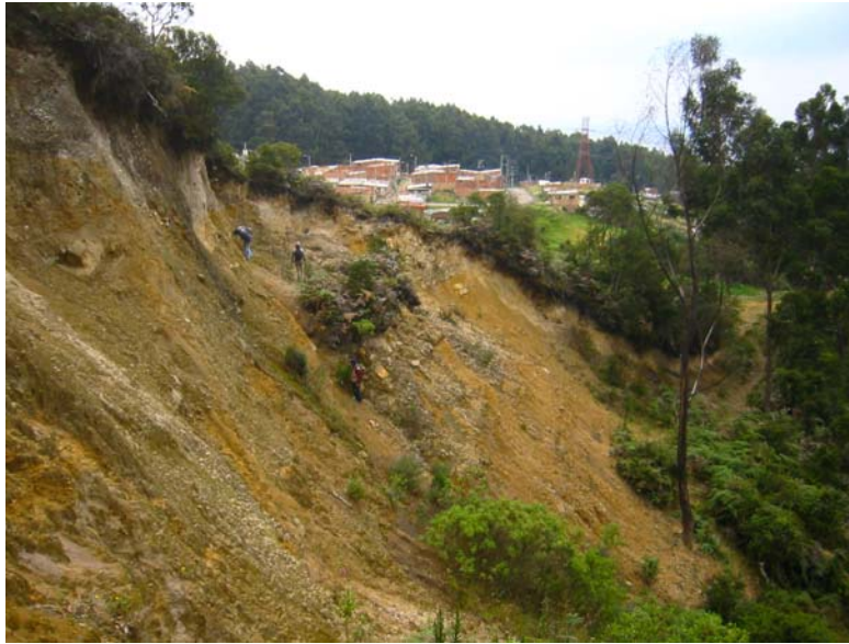
Fotografía 6 - 41. Deslizamiento traslacional ubicado en una antigua cantera, ubicada entre San Isidro y Aguas Claras.
