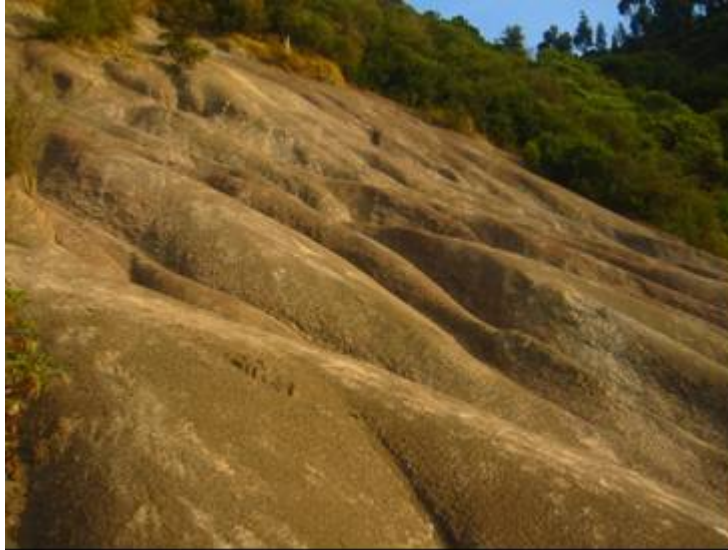
Fotografía 6 - 16. Lodolitas de la Fm. Bogotá en una antigua zona de extracción no recuperada, afectada por procesos de erosión hídrica superficial concentrada.
