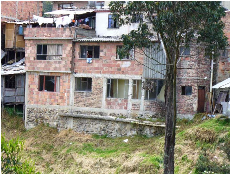
Fotografía 8 - 3. Estructuras en mampostería confinada
