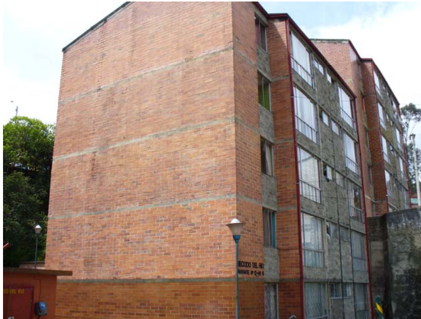
Fotografía 8 - 6. Estructura en mampostería estructural
