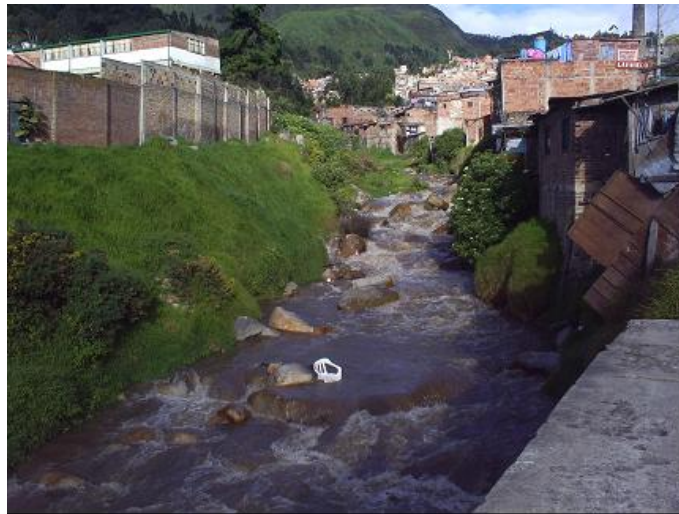
Fotografía 9 - 2. Cruce carrera 8 A este con el río San Cristóbal: Ubicación de viviendas en la zona de ronda del cauce. Calle 12 Sur carrera 8 A este.
