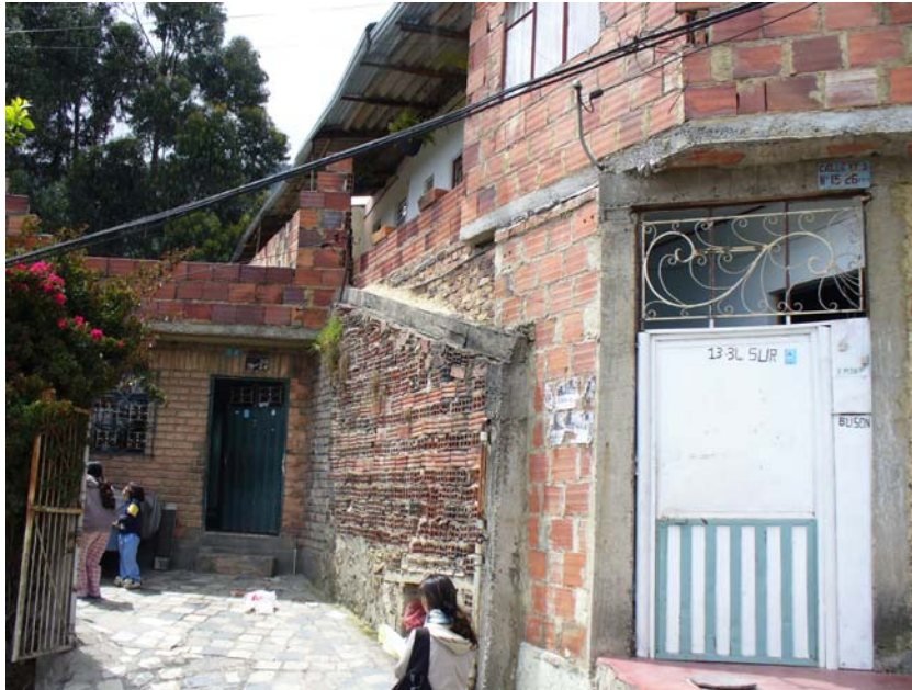
Fotografía 8 - 2. Estructuras de uno y dos pisos, con estructura en mampostería. Tipología predominante en la zona de estudio
