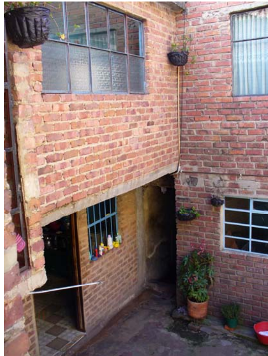
Fotografía 8 - 1. Estructura en mampostería de 2 pisos, con irregularidades en planta y altura.
