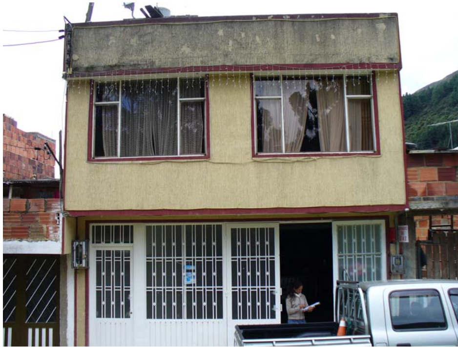
Fotografía 8 - 4. Estructura de dos pisos aporcada
