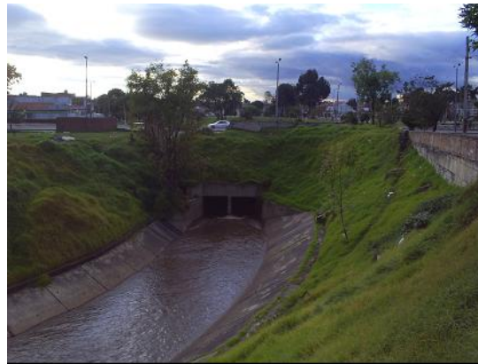
Fotografía 9 - 8. Río San Cristóbal a la altura de la carrera 10, sección de la estructura de cruce.
