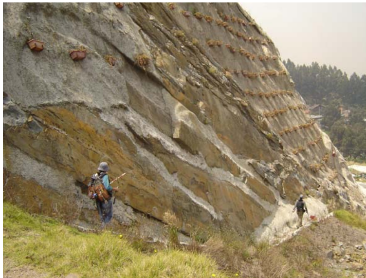
Fotografía 6 - 43. Obras de mitigación para caída de bloques (San Jerónimo del Yuste).
