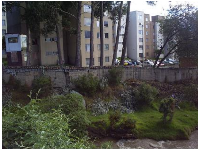
Fotografía 9 - 4. Zona de ronda entre la carrera 3 G este y la carrera 6 Este.
