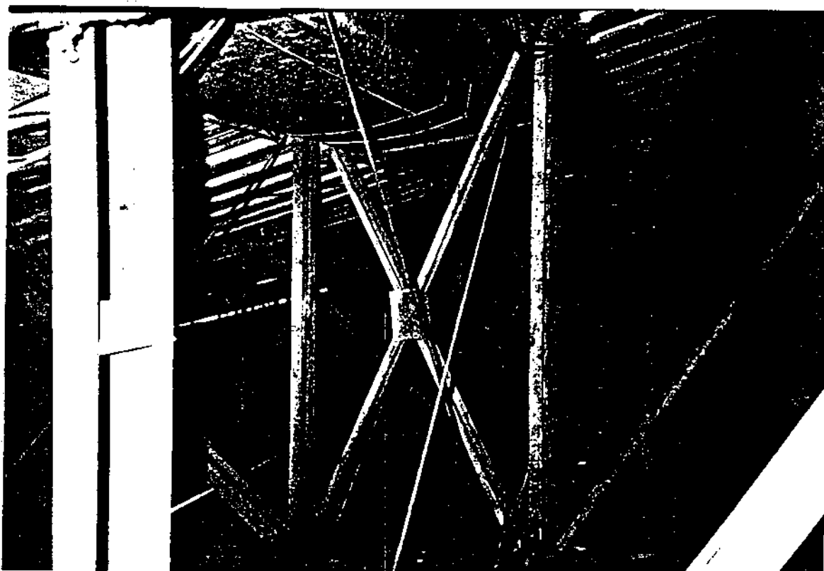
FOTO N° 19: Estructura de cubierta
