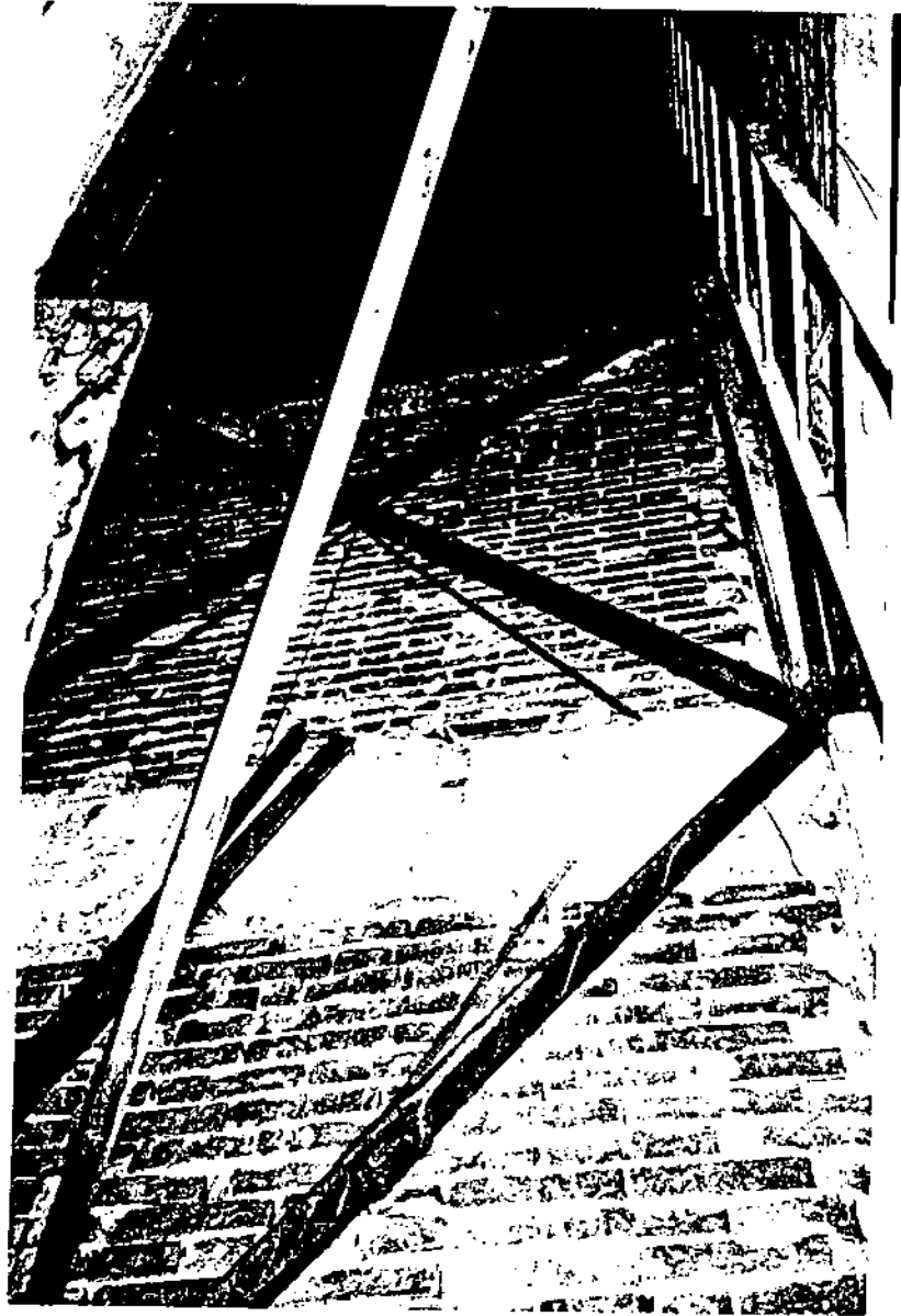
FOTO N° 6: Torre izquierda - columnas 12, 14 y 20 · Arriostamiento interior
