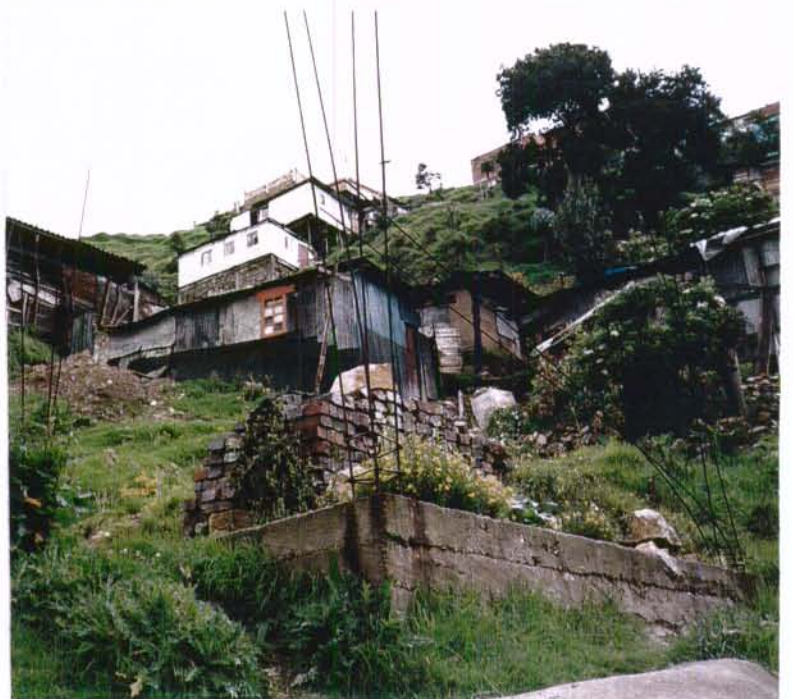
INFRAESTRUCTURAS DE VIVIENDA EN LA ZONA DE ALTO RIESGO, AL CENTRO.
