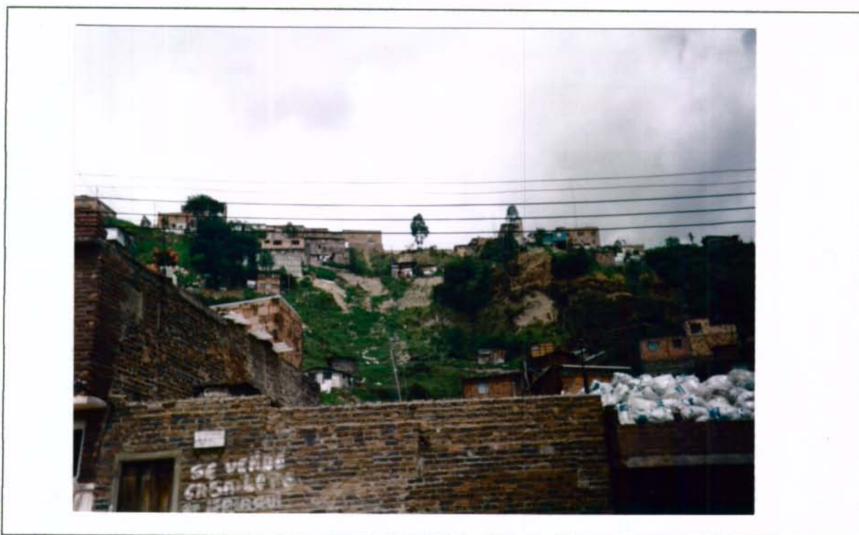
FOTO No. 14. Panorámica frontal del sitio del derrumbe principal del muro. Se observan los escarpes de las dos coronas sucesivas de derrumbe. Vista al oriente. Foto EPR – Sept/99. Cuadro No. 3. Rollo 8688
