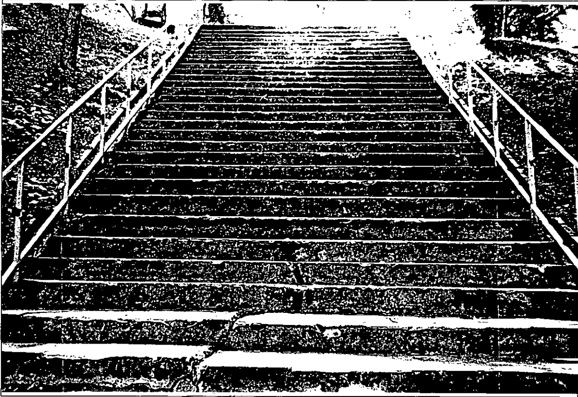
Junio 12/02 Escaleras de Acceso Cancha de fútbol sector occidental. (Rollo 7 Foto 15)
