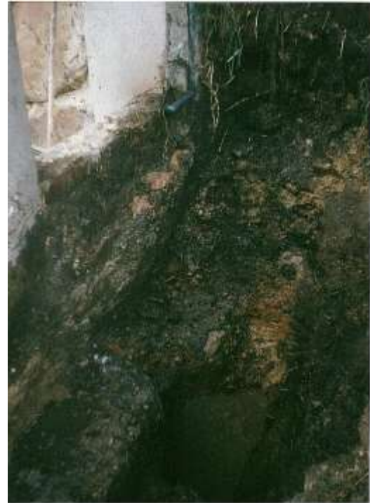
Foto No. 10.22 - CASA 1. APIQUE No. 1, VISTA LATERAL
