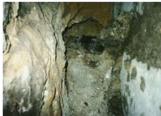
FOTO No. 10.29 - CASA 3. APIQUE No. 2, DETALLE SUELO DE FUNDACIÓN
