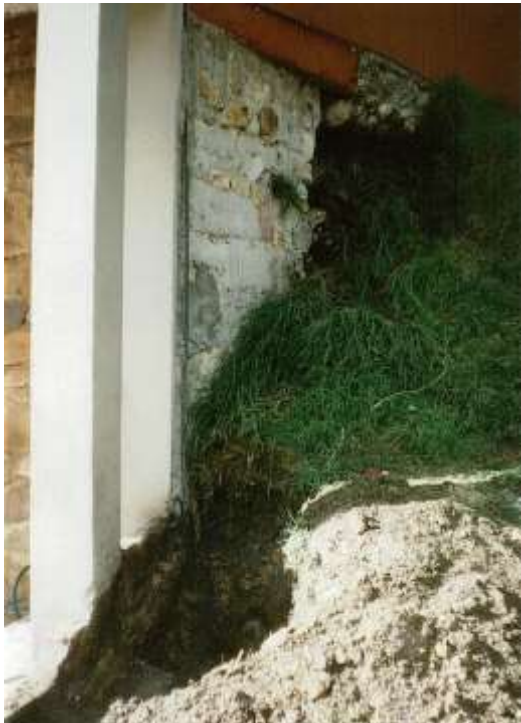
FOTO No. 10.24 - CASA 1. DETALLE VIGA DE AMARRE PERIMETRAL Y MURO DE CONTENCIÓN EN CONCRETO CICLOPEO
