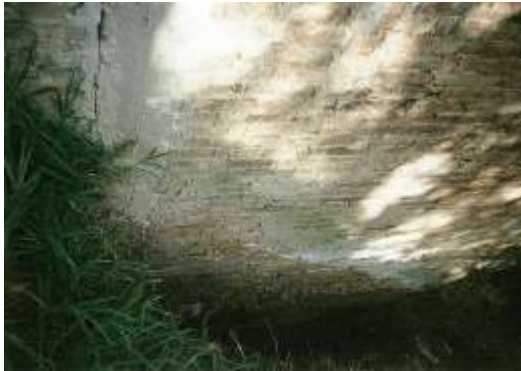
FOTO No. 10.27 - CASA 3. APIQUE No. 2, VISTA SUPERIOR
