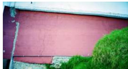
Foto No. 10.1 - CASA 1. FACHADA LATERAL IZQUIERDA, VISTA FRONTAL
