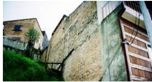
Foto No. 10.5 - CASA 3. FACHADA LATERAL DERECHA
