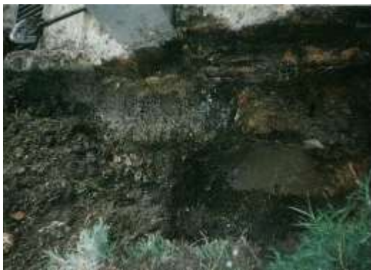
Foto No. 10.21 - CASA 1. APIQUE No. 1, VISTA SUPERIOR
