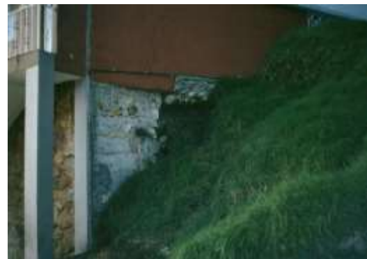
Foto No. 10.23 - CASA 1. VIGA DE AMARRE PERIMETRAL
