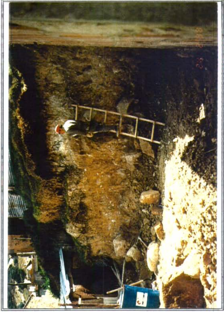
Fotografía No 3 Corte para la construcción de una vivienda de la manzana J. Se observa el material de coluvión con buena resistencia, permitiendo cortes verticales de apreciable altura.
