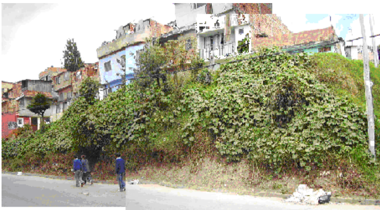
Fotografía 2. Vista general sobre el sitio de estudio el 22/Nov/2006
