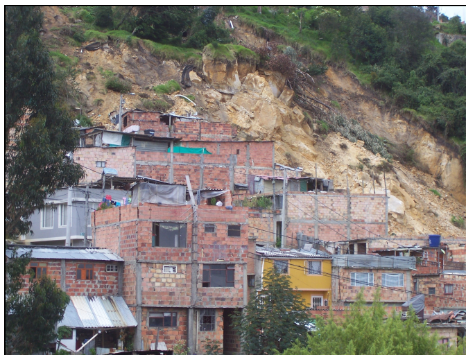
FOTO 3.26 IMAGEN DEL DESLIZAMIENTO OCURRIDO EN MAYO DE 2006
