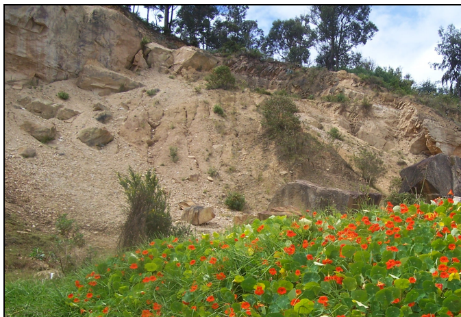
Foto 3.24 AL FONDO DE LA IMAGEN SE APRECIAN TALUDES DE EXTRACCIÓN EN MATERIALES SUELTOS, AFECTADOS POR PROCESOS DE EROSIÓN HÍDRICA CONCENTRADA (SURCOS). PARTE BAJA CENTRAL DEL FRENTE SUPERIOR
