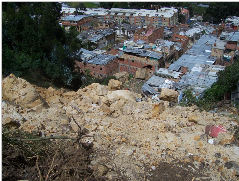
Foto 3.13 DESLIZAMIENTO DE MASAS COLUVIALES Y DE TALUS QUE AFECTARON ZONAS POBLADAS DEL SECTOR CENTRAL DEL BARRIO EL CODITO EN MAYO DE 2006.
