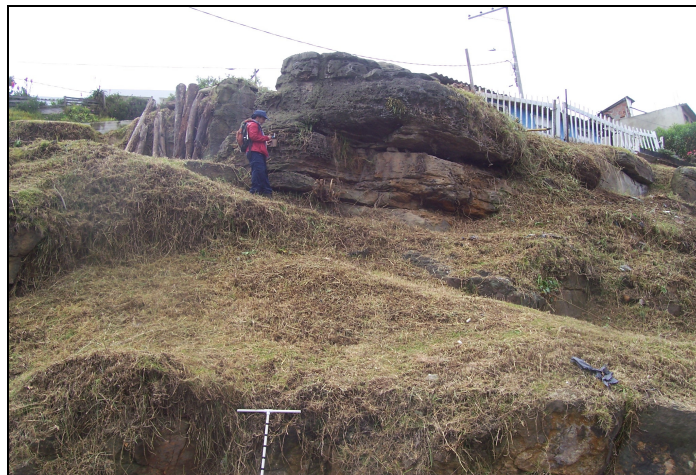
Foto 3.20 ZONA MODERADAMENTE INTERVENIDA, CON TALUDES BAJOS, GENERALMENTE SIN PROBLEMAS DE ESTABILIDAD
