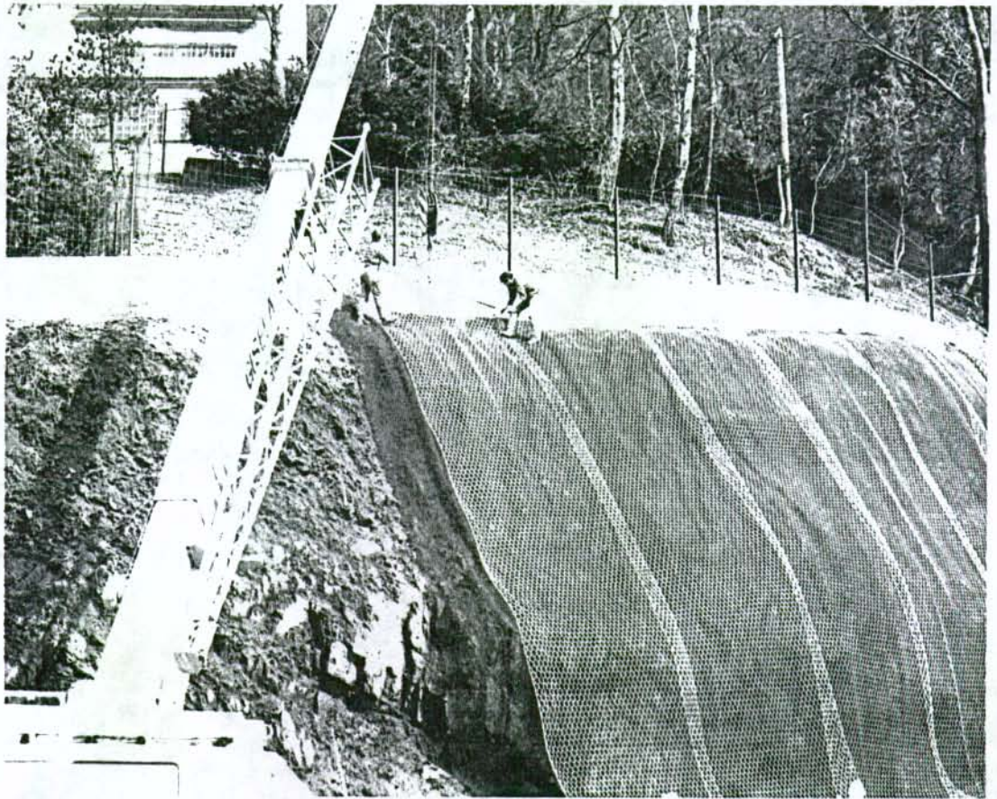
Preparación de un talud con tela metálica para evitar el desprendimiento de rocas, seguida de un tratamiento de recuperación vegetal por hidrosiembra en la Carretera Nacional B 54 (Schalksmühle/Dahlebrück), 1987
