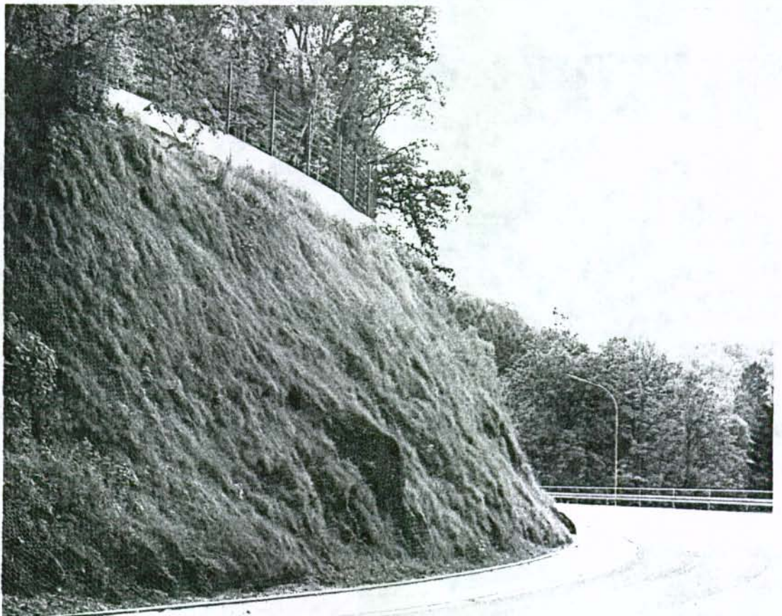
Recuperación vegetal en el talud de una carretera recién construida (Bodenmais/Selva Bávara), 1988
