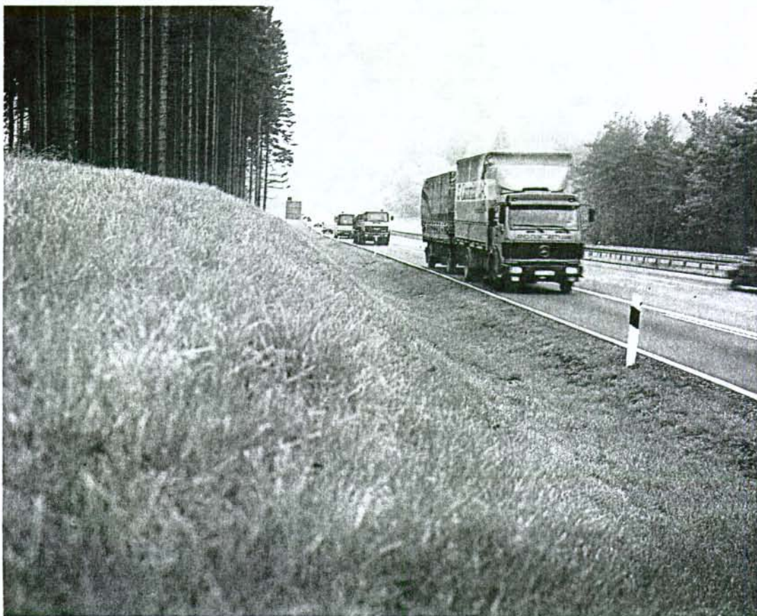
Obras de recuperación vegetal en la Autopista A 5 en las cercanías de Alsbach, 1988
