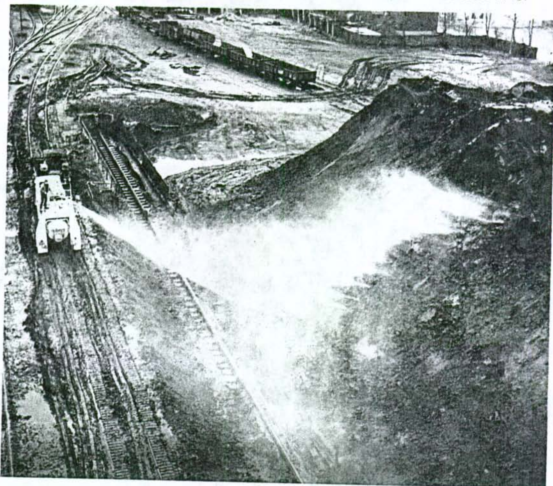
Compactado de masas polvorientas en un amontonamiento de carbón con TERRAVEST
