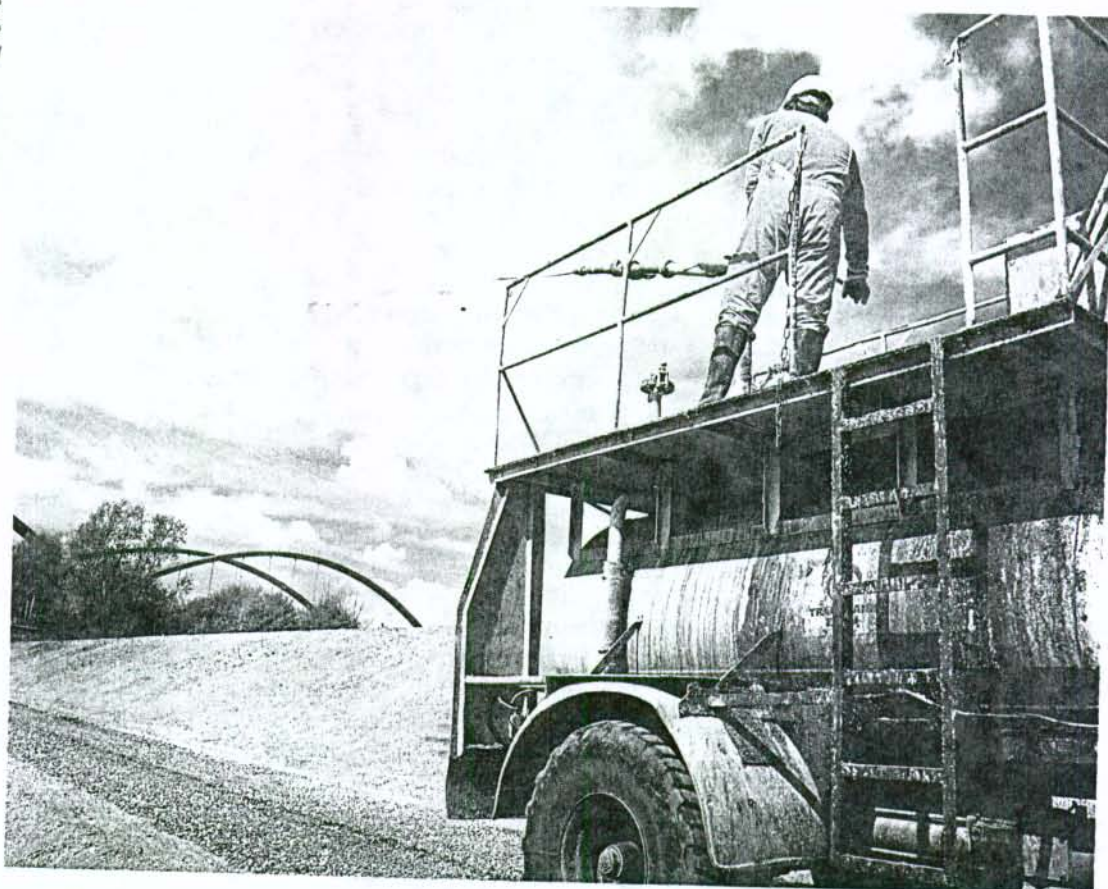
Aspersión de la mezcla de hidrosiembra en el talud de un canal
