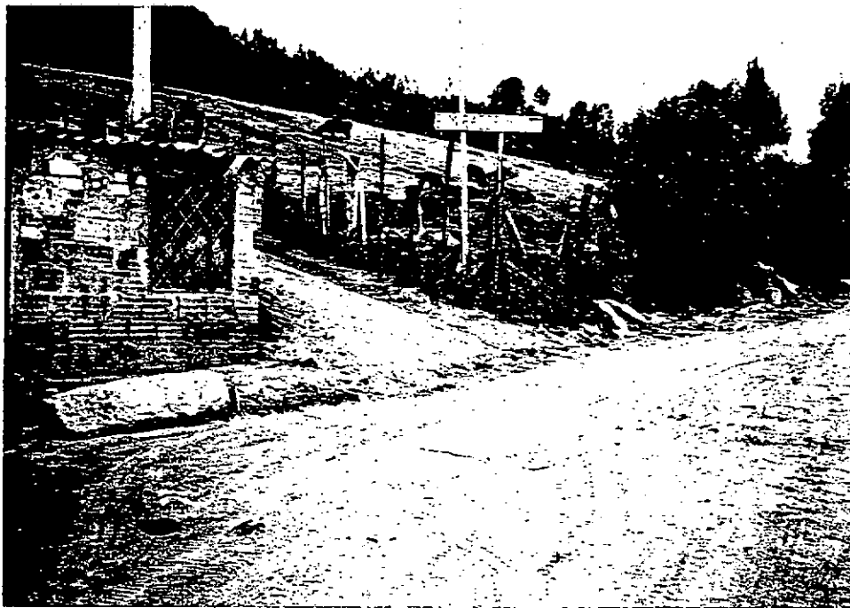
Foto 2. Antigua vía al Guavio. La vía no posee cuneta, lo que complementado con el alto tráfico de volquetas produce un rápido deterioro de la misma.
