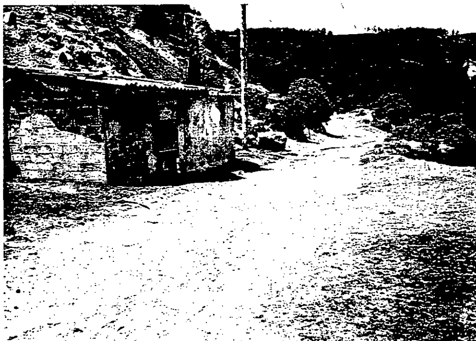
Foto 14. Carrera 23 en la parte mas alta del Codito. Es necesario Canalizar aguas para desviarlas, ya que es parte del problema de la parte baja, debido a que acrecenta la cantidad de agua a drenar, escurre entre las viviendas y arrastra materiales de los taludes contiguos a la carrera 24.
