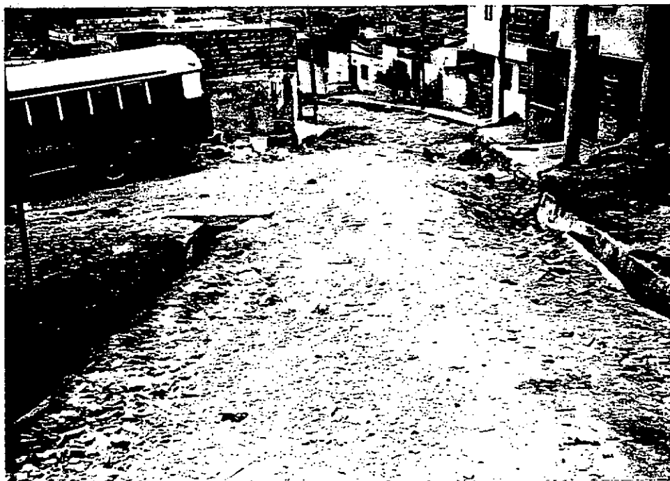
Foto 24. Longitudinal de la calle 182, a la izquierda se observa la carrera 24. En esta calle empieza el alcantarillado de aguas lluvias en 24" el cual esta completamente taponado de arena. las aguas escurren una parte sobre la calle y otra por el canal de la carrera 24 mostrado en las fotos anteriores.
