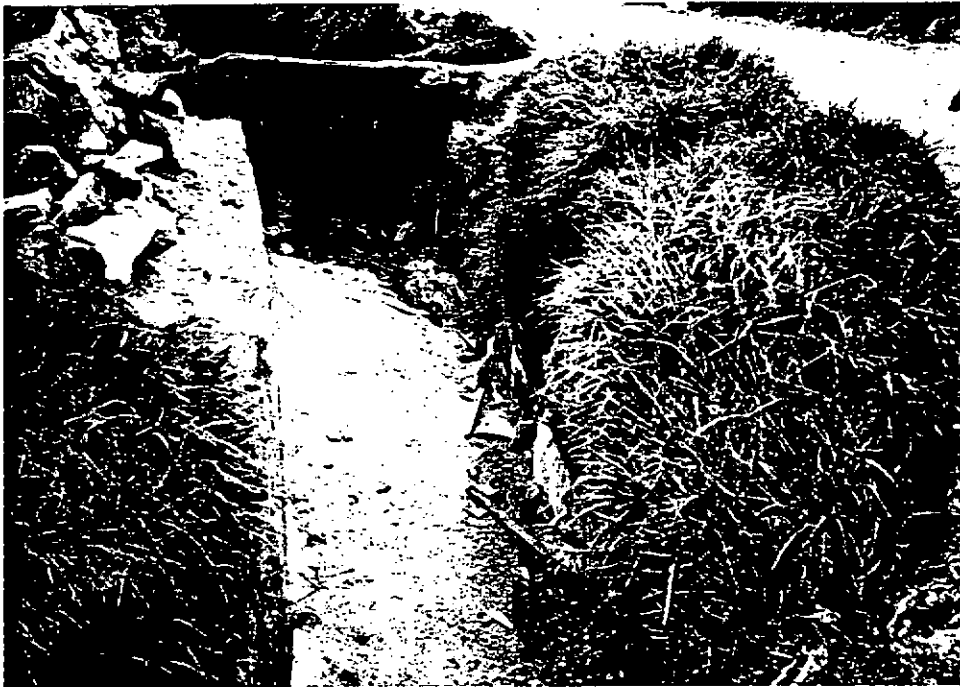
Foto 12. Tramo inicial de canal en concreto en el barrio Horizonte (calle 184 bis), El concreto esta completamente deteriorado.
