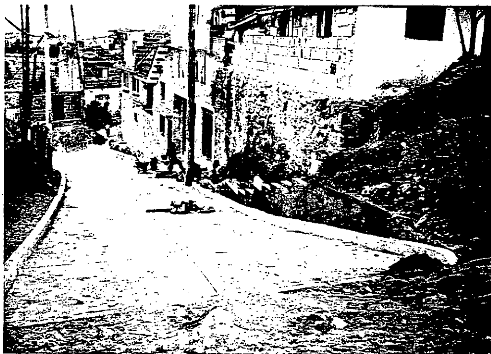
Foto 20. Calle 180 B. Este sector drena todas las aguas del punto de confluencia descrito en la foto 16. Esta vía está recién pavimentada, para protegerla se están realizando las paredes del canal.
